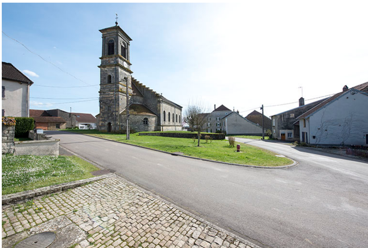
Place et église vues du nord-ouest.
