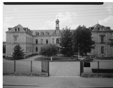
Elévation antérieure. Phot. Jean-Luc Duthu IVR26_19785800117V
