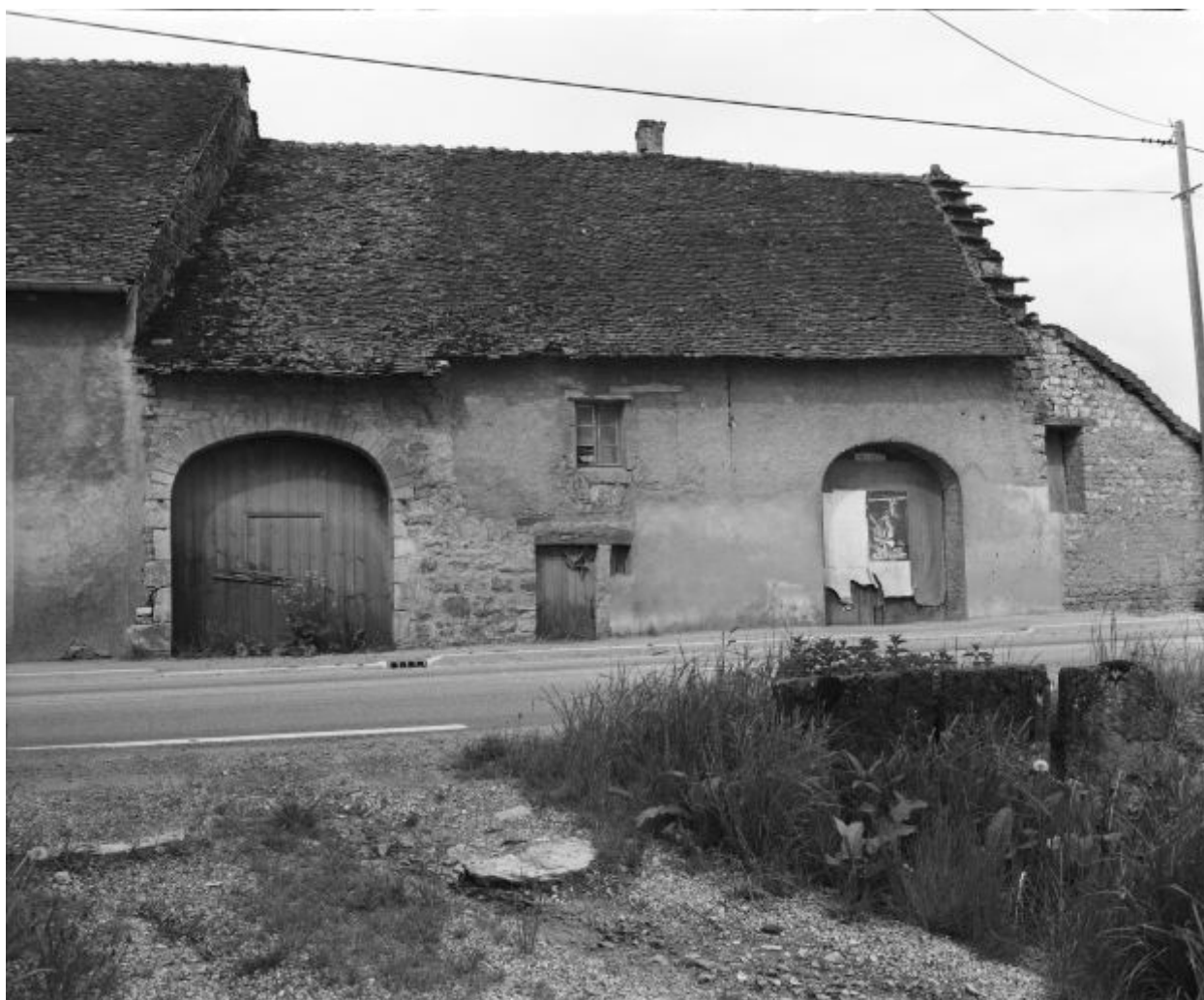
Façade antérieure vue de face.
