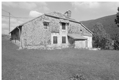
Face sud-ouest. Phot. Jérôme Mongreville IVR43_19963901584X
