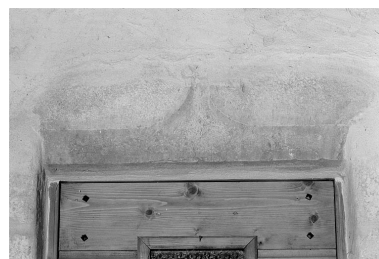
Linteau de la porte d'entrée en accolade. Phot. Jérôme Mongreville IVR43_19963901580X
