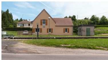
La maison éclusière vue de face.
