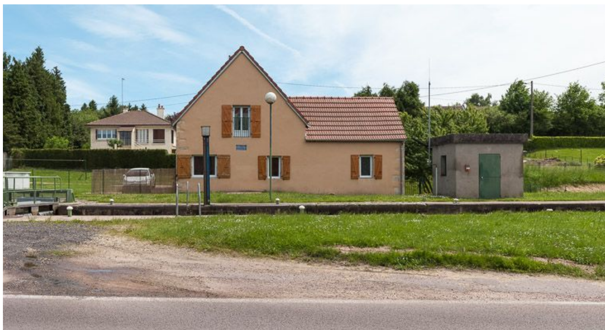
La maison éclusière vue de face.
