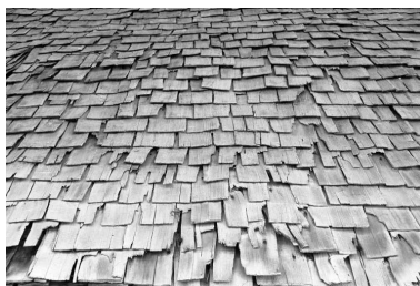
Détail de l'essentage de la façade antérieure. Phot. Laurent Poupard IVR43_19903900632Z
