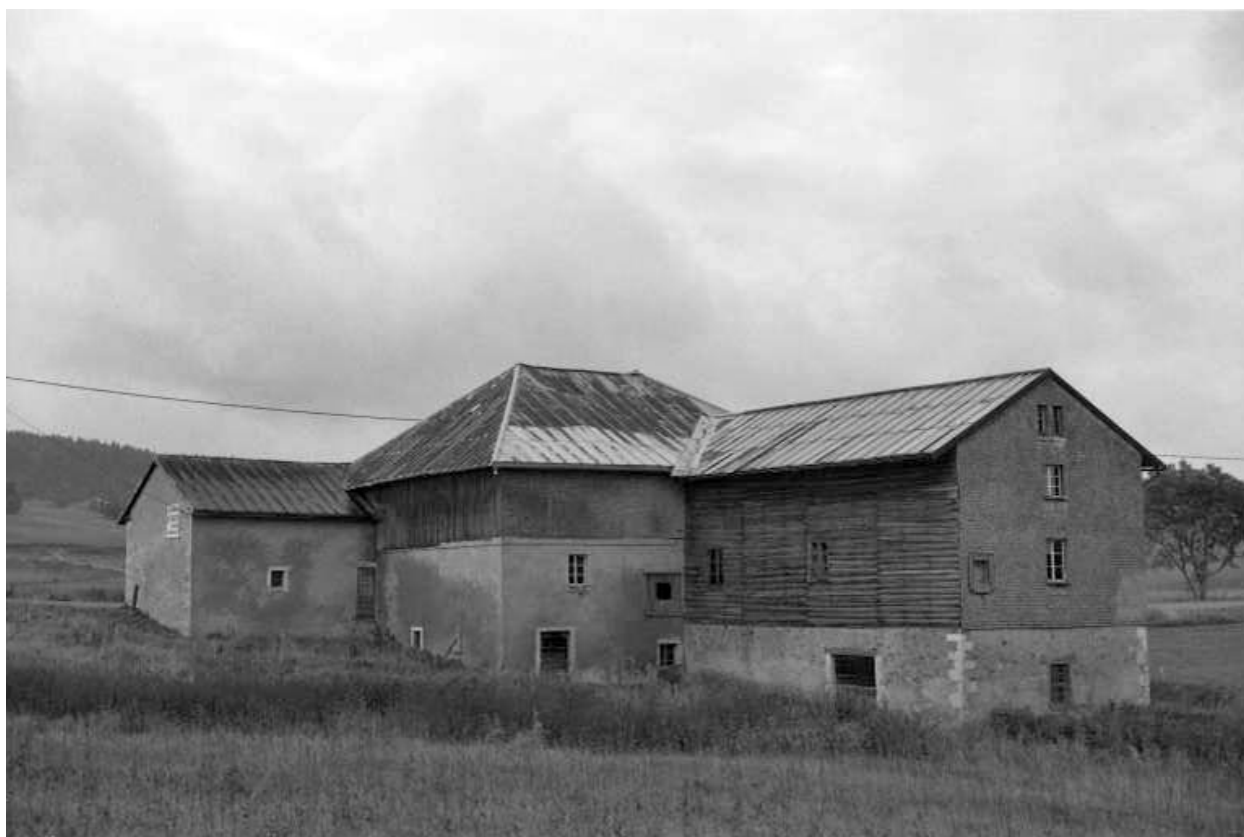
Vue d'ensemble depuis le nord (façades postérieures).
