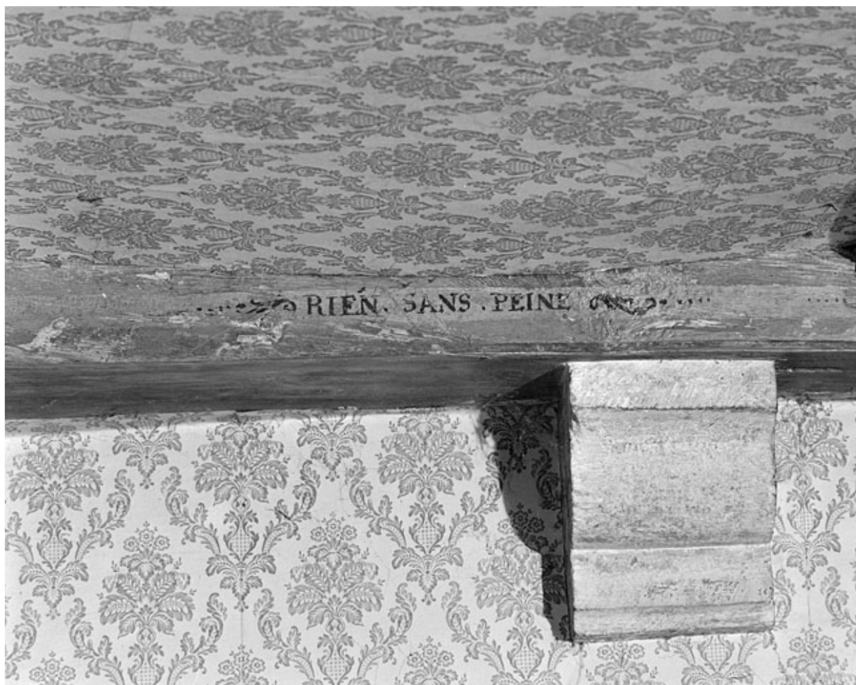
Premier corps de bâtiment. Plafond du rez-de-chaussée.
