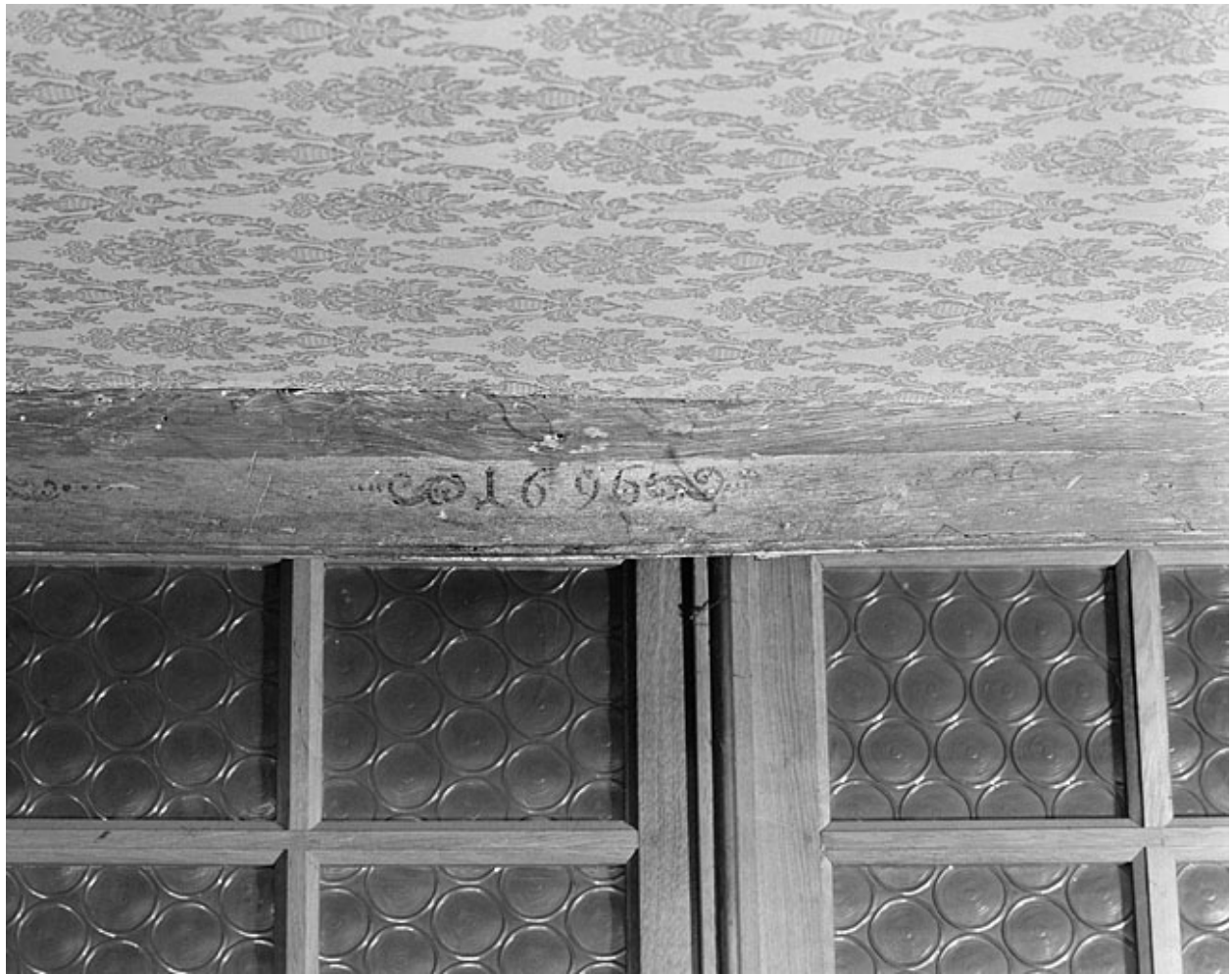
Premier corps de bâtiment. Plafond du rez-de-chaussée.
