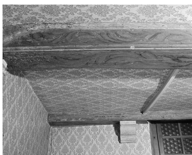
Premier corps de bâtiment. Plafond du rez-de-chaussée. Phot. Yves Sancey IVR43_19852500055X
