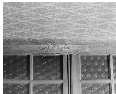
Premier corps de bâtiment. Plafond du rez-de-chaussée. Phot. Yves Sancey IVR43_19852500059X
