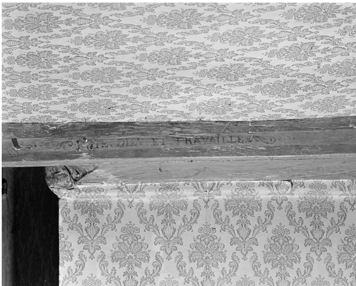
Premier corps de bâtiment. Plafond du rez-de-chaussée.
