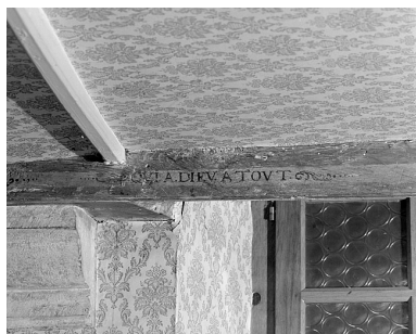
Premier corps de bâtiment. Plafond du rez-de-chaussée. Phot. Yves Sancey IVR43_19852500057X
