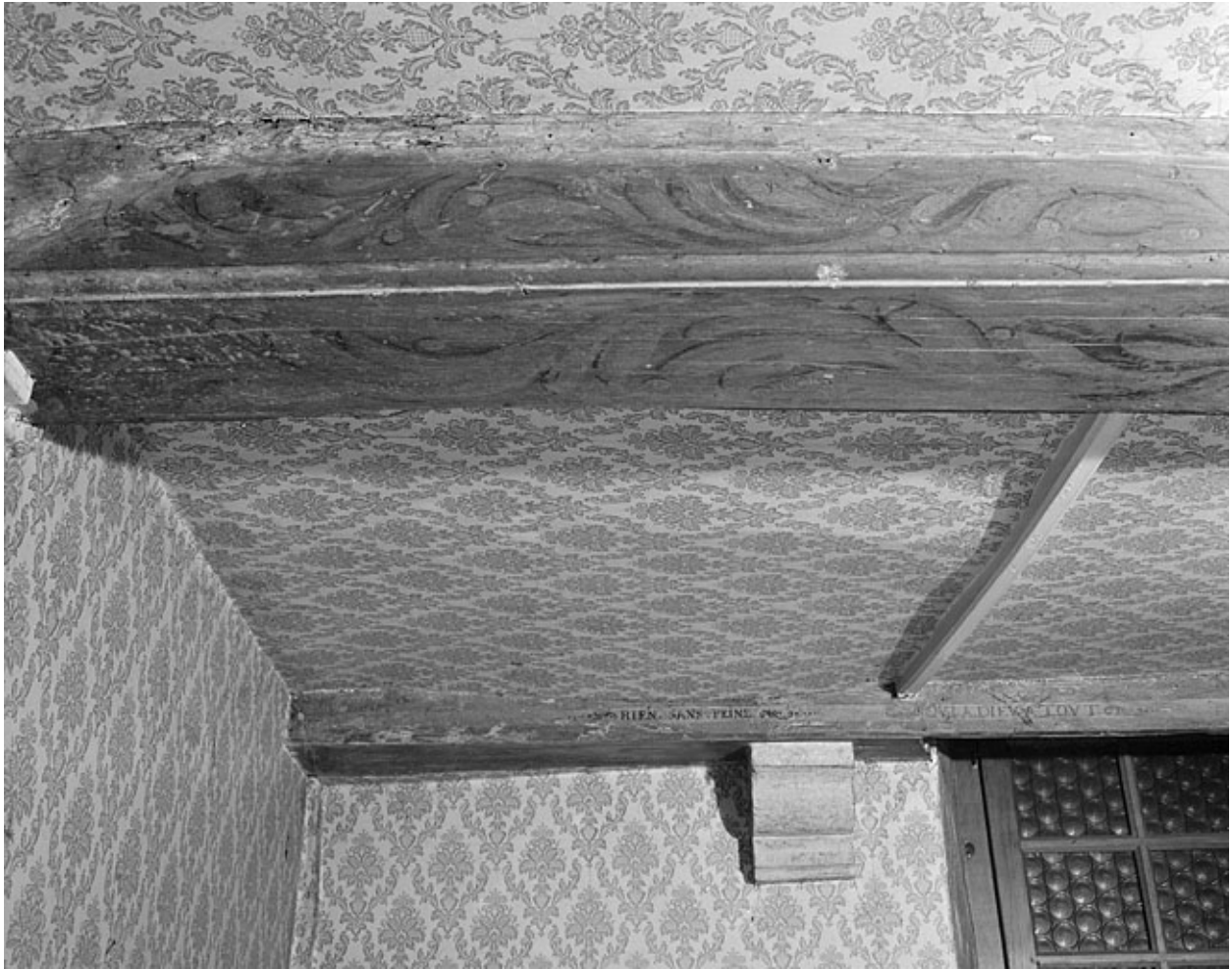
Premier corps de bâtiment. Plafond du rez-de-chaussée.
