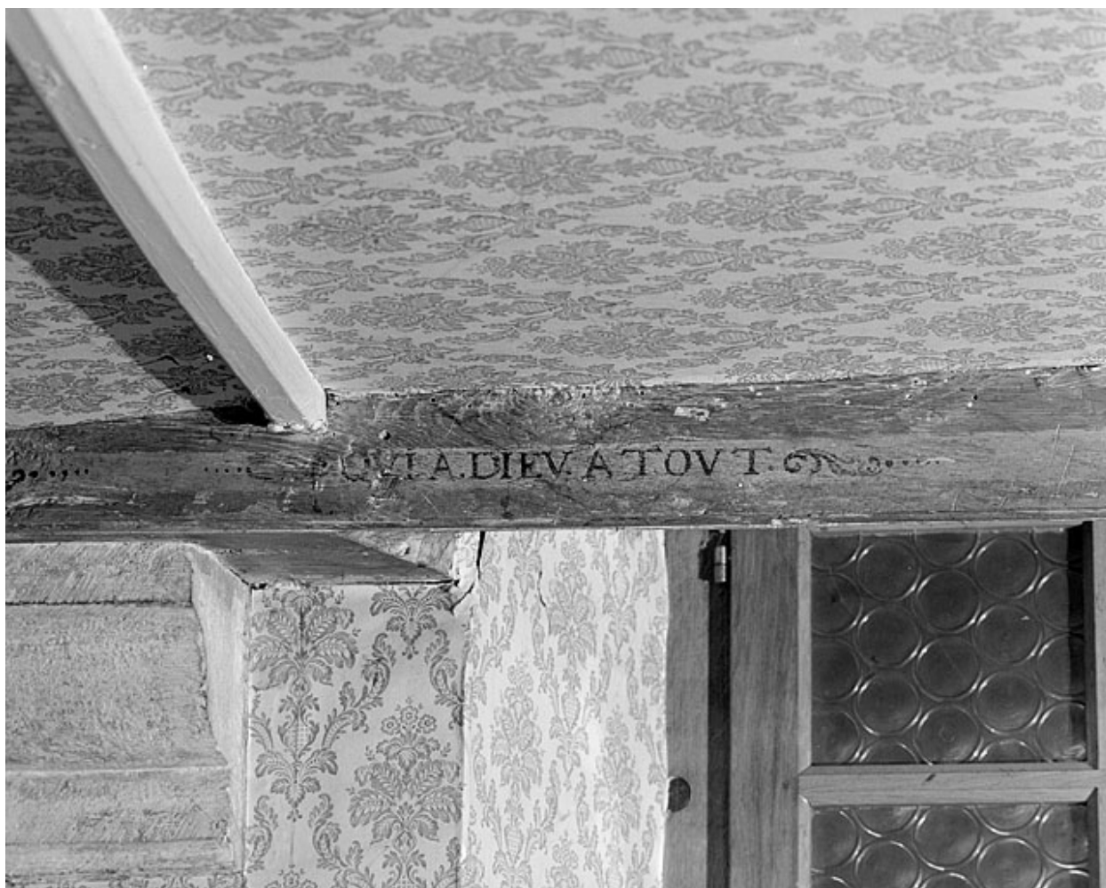
Premier corps de bâtiment. Plafond du rez-de-chaussée.
