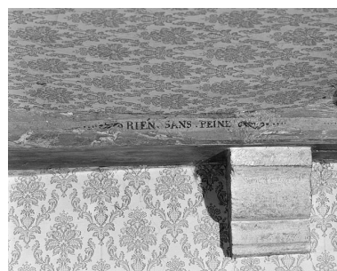
Premier corps de bâtiment. Plafond du rez-de-chaussée. Phot. Yves Sancey IVR43_19852500056X
