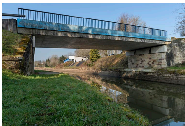
Pont routier enjambeant le canal, Pont-du-Bois (70). Phot. Sonia Dourlot IVR43_20167000199NUC4A
