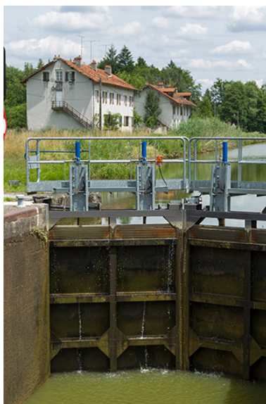
Ecluse n°44 : détail intérieur de la porte amont fermée et vue sur les cités, Demangevelle (70). Phot. Sonia Dourlot IVR43_20157000960NUC2A
