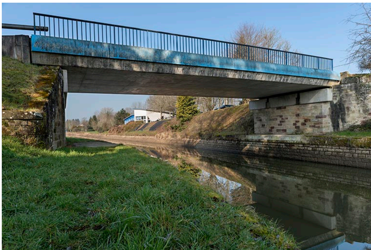
Pont routier enjambeant le canal, Pont-du-Bois (70).
