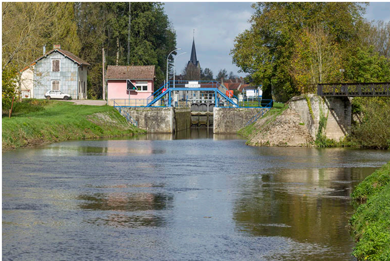
Depuis l'aval du site d'écluse n°46, la confluence du canal et du Coney, le poste de commande et la maison d'éclusier; Corre (70).
