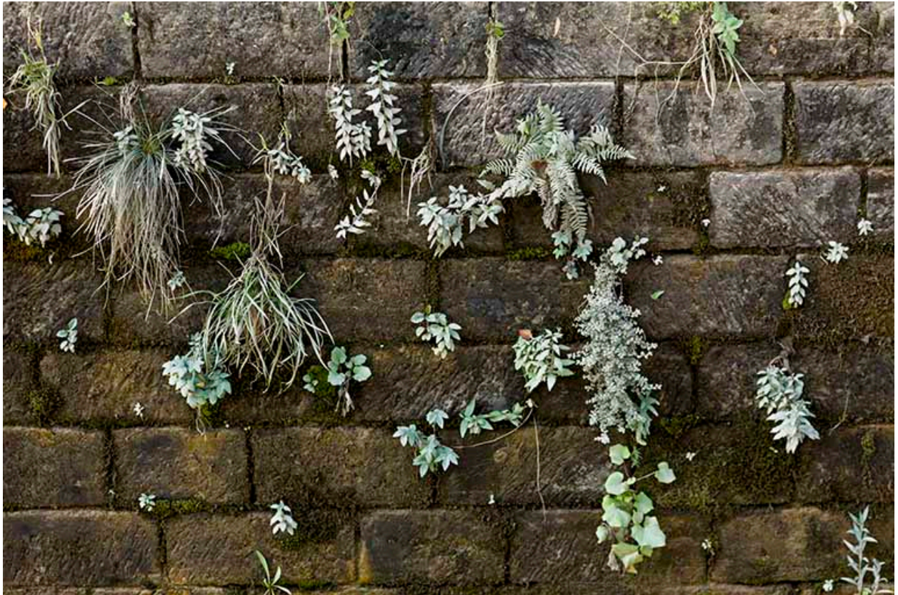
Détail sur la maçonnerie d'une écluse.
