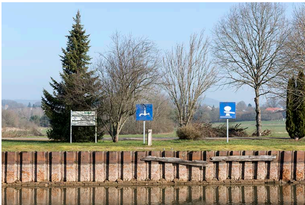
Détail des palplanches le long de la berge.
