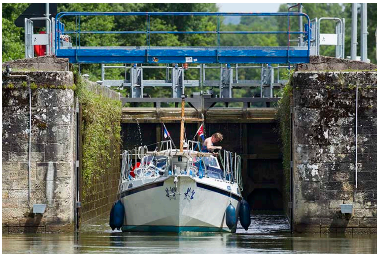
Ecluse n°43, Demangevelle (70).
