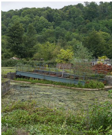
Vue du pont, à l'abandon. Phot. Pierre-Marie Barbe-Richaud IVR26_20175800432NUC2A
