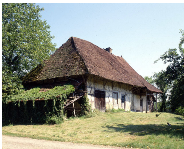
Cosges : ferme située rue du Moulin de Jousseau. Phot. Yves Sancey IVR43_19903901129XA
