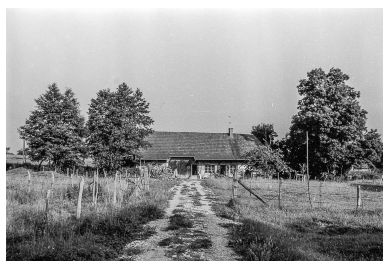
Fontainebrux : ferme cadastrée 1956 A1 151. Phot. Guy Forestier IVR43_19753900212Z
