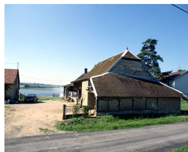
Fontainebrux : ferme située route de Fontainebrux.
