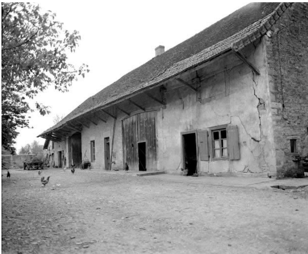
Villeveux : ferme située rue de Beaurepaire.
