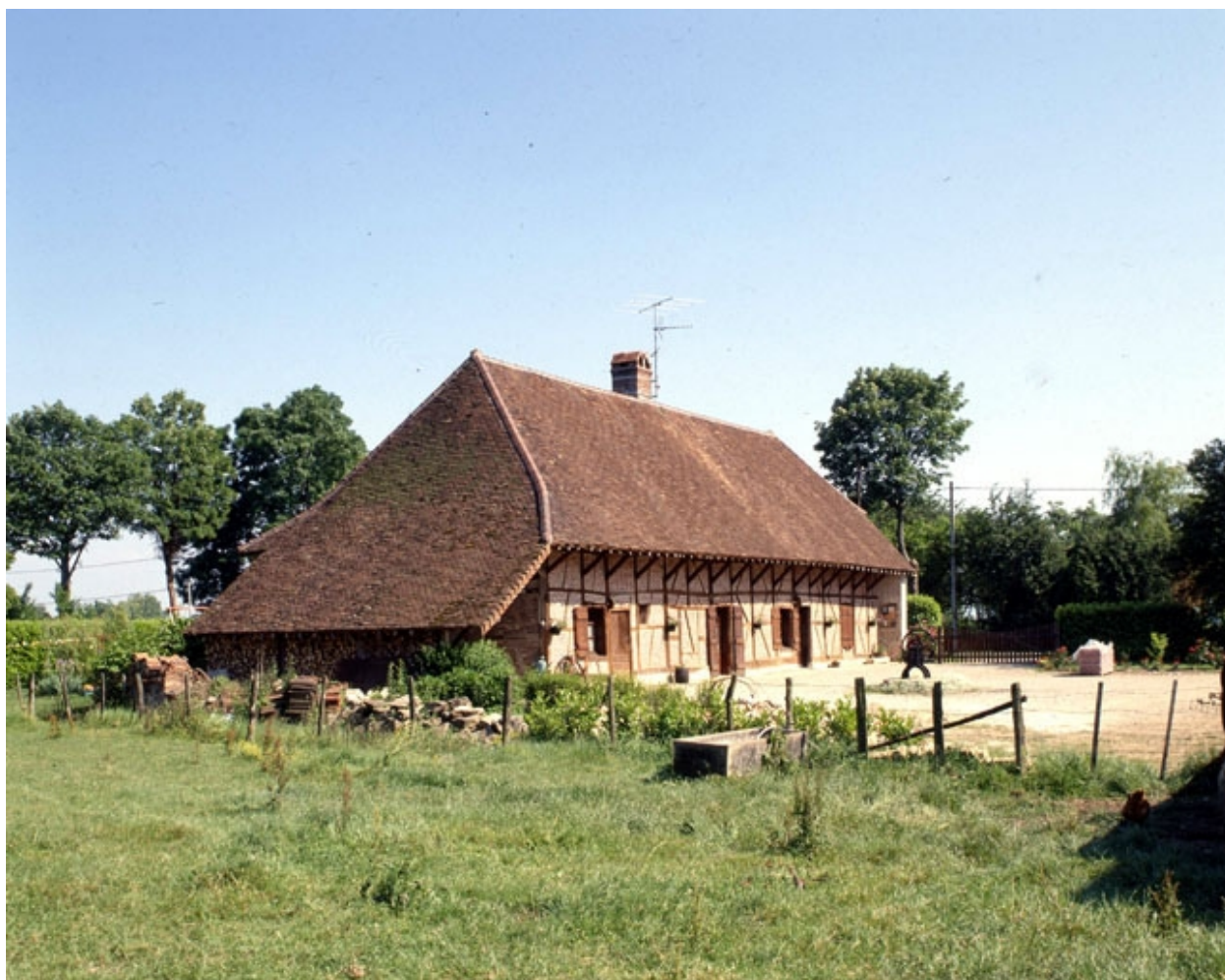
Cosges : ferme située au lieudit Sottessard.
