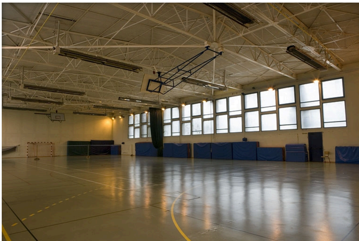
Bâtiment F1. Vue intérieure gymnase.
