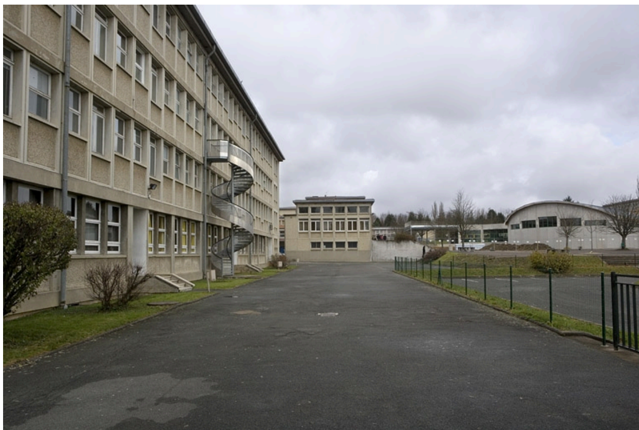
Vue latérale façade antérieure bâtiment D.
