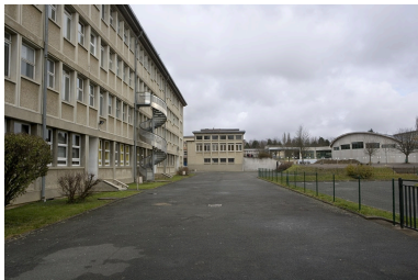
Vue latérale façade antérieure bâtiment D.
