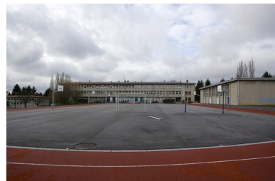
Vue d'ensemble bâtiment F2 et C.
