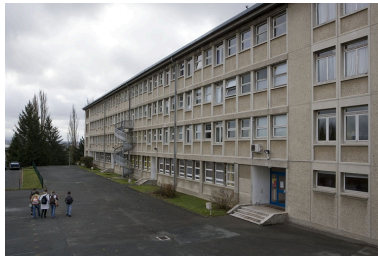
Vue façade latérale bâtiment D.
