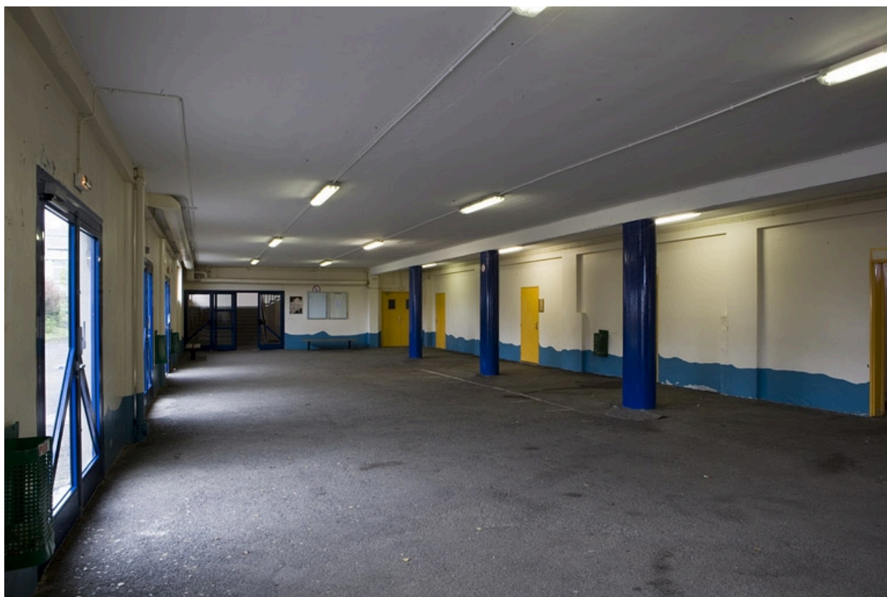
Bâtiment A. Préau.
