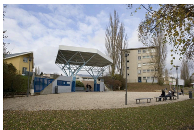
Vue de la nouvelle entrée. Phot. Yves Sancey IVR43_20072501034NUCA
