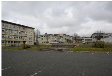
Vue d'ensemble bâtiments D et B.
