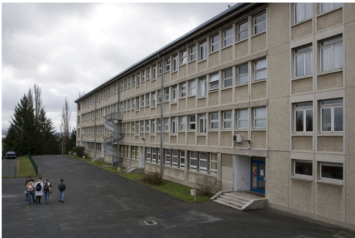
Vue façade latérale bâtiment D.
