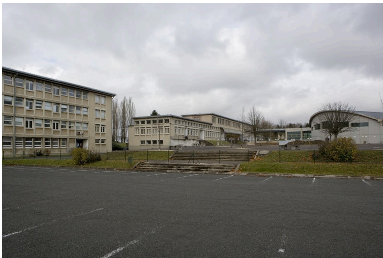
Vue d'ensemble bâtiments D et B.
