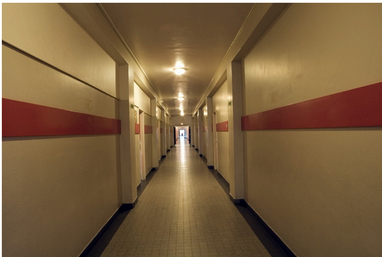
Bâtiment A. Vue couloir.
