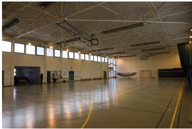
Bâtiment F1. Vue intérieure gymnase.
