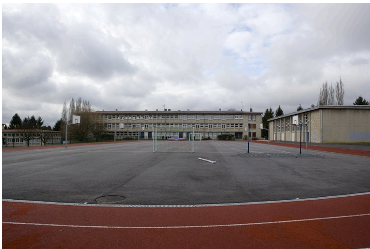
Vue d'ensemble bâtiment F2 et C.
