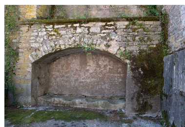
Détail dans la cour. Phot. Jérôme Mongreville IVR43_20177000493NUC4A
