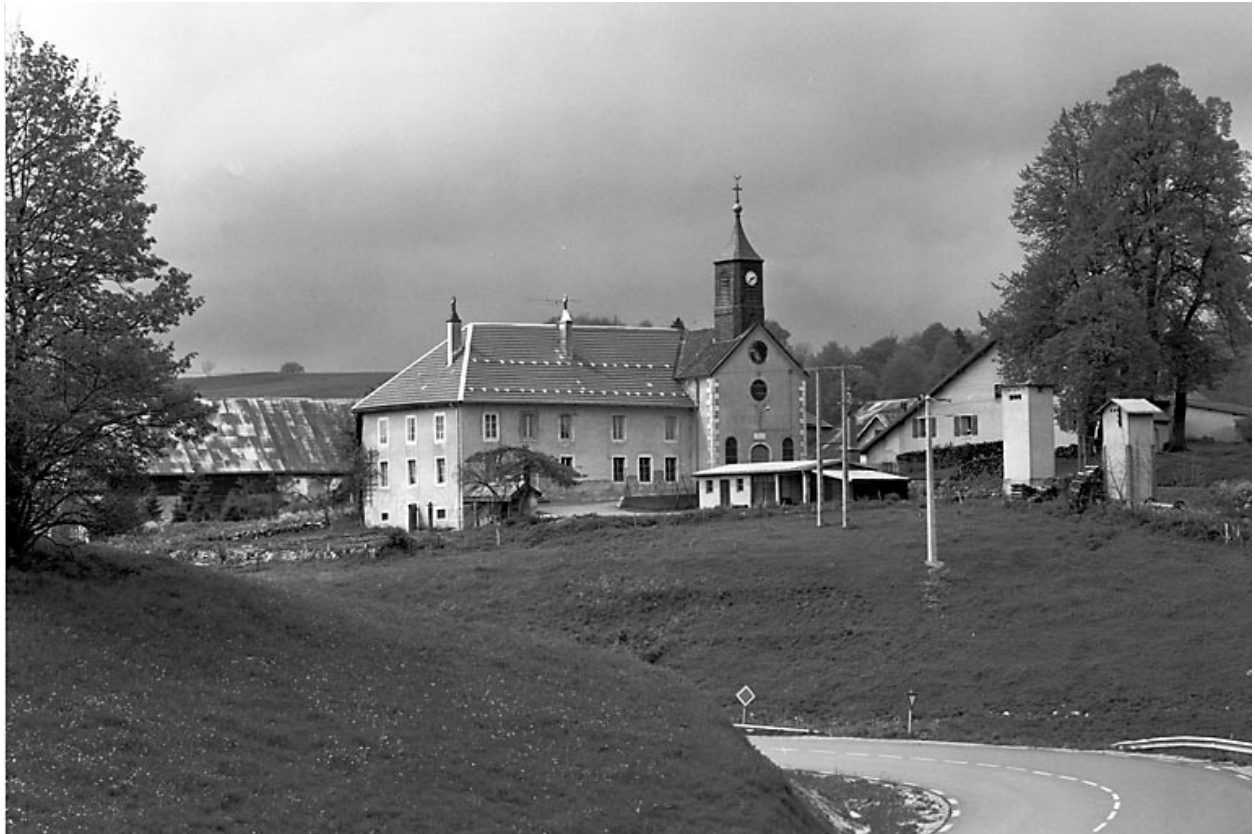
Vue d'ensemble dans le site.
