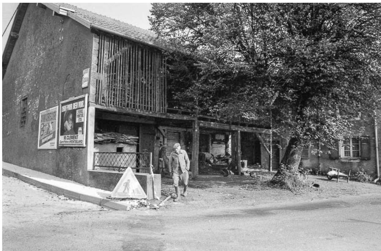
Façade antérieure : détail.
