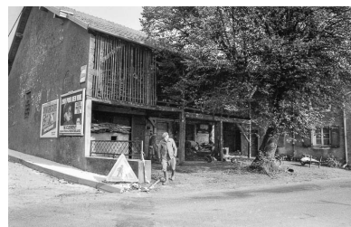
Façade antérieure : détail.
