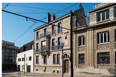
Vue de trois quarts droite. Phot. Jérôme Mongreville IVR43_20182500665NUC4A
