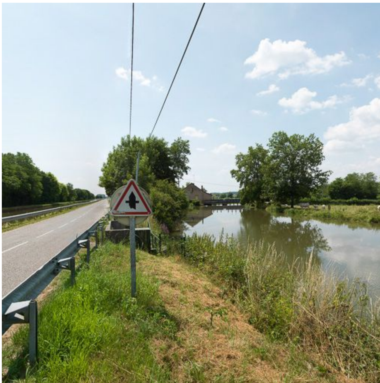
Détail de l'aqueduc.
