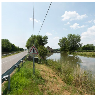
Détail de l'aqueduc.
