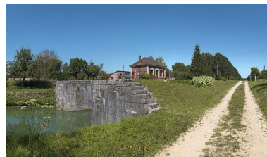
Vue de la tête amont du sas.
