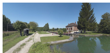
Vue d'ensemble du site. Phot. Thierry Kuntz IVR26_20118900155NUC4A
