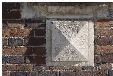
Maison éclusière : détail de la console en pointe de diamant sous la fenêtre.
