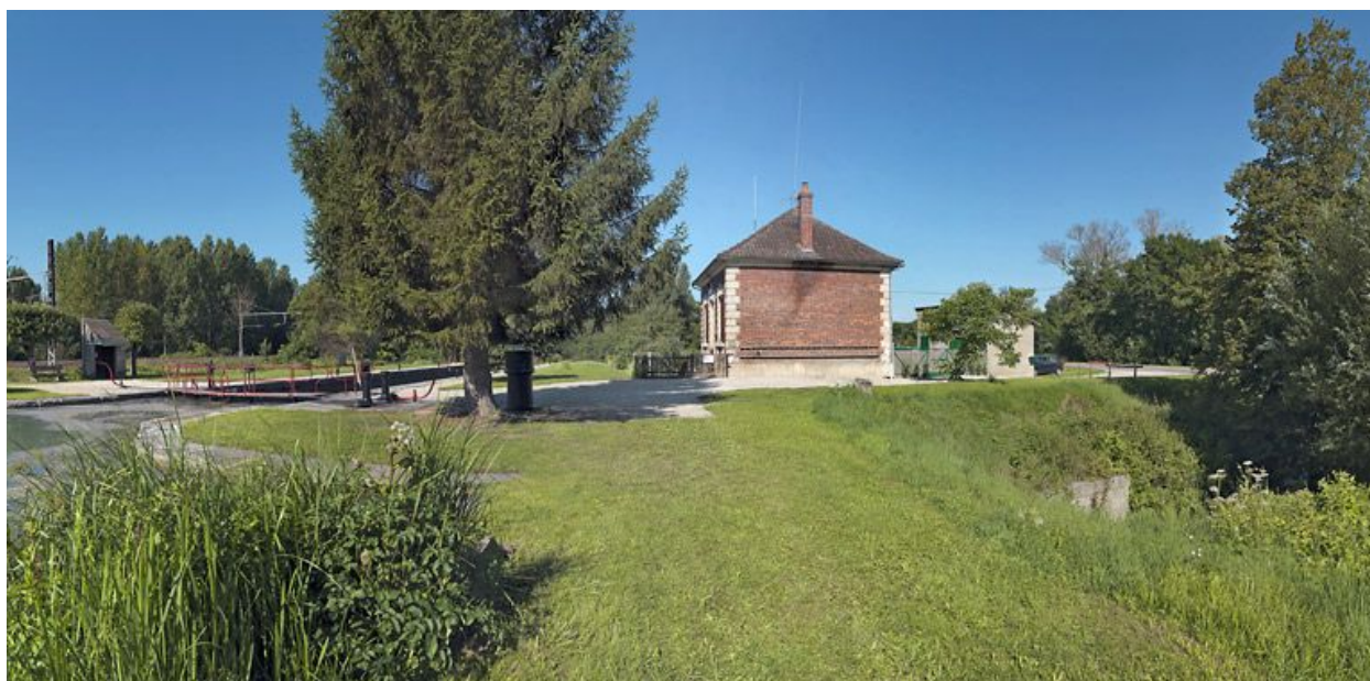
Maison éclusière : côté droit.
