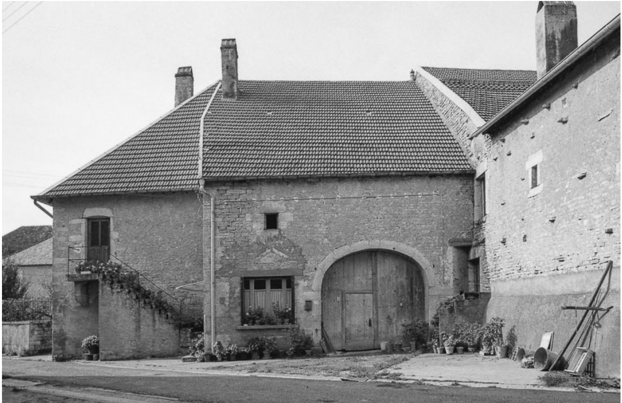
Façade antérieure vue de face.
