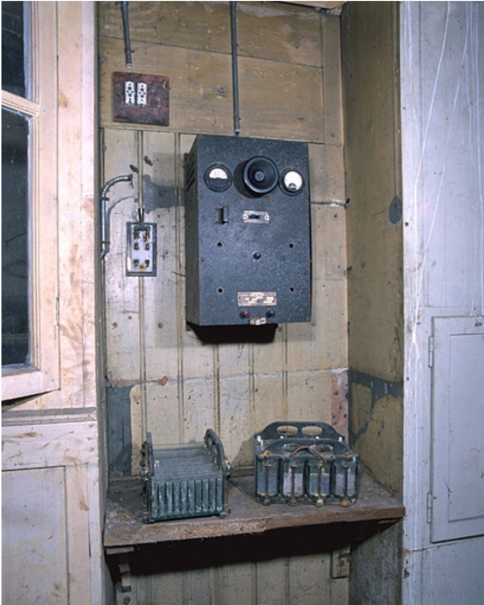
Chargeur de batterie Oxymétal Westinghouse : vue d'ensemble du chargeur et des batteries.
