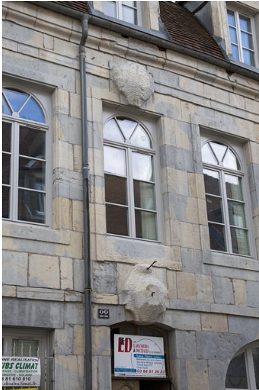
Façade antérieure : détail des pierres d'attente épannelées sur la porte du couloir et d'une fenêtre de l'étage.
