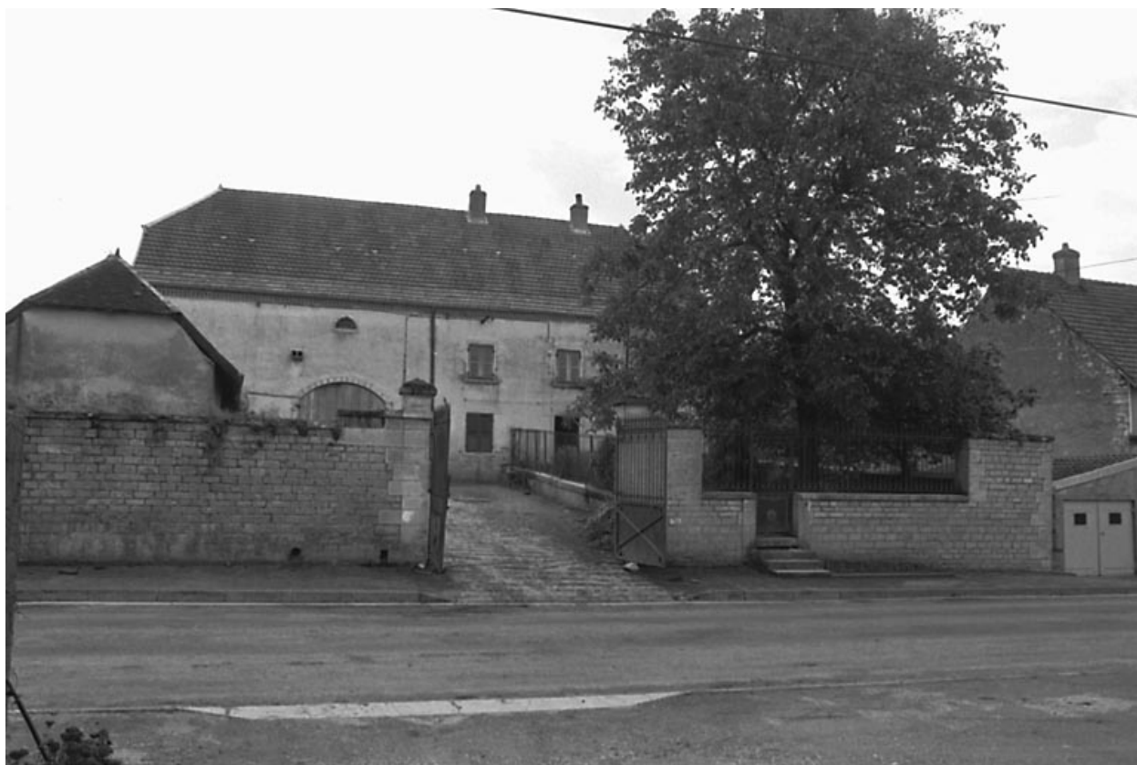
Vue d'ensemble depuis la rue.
