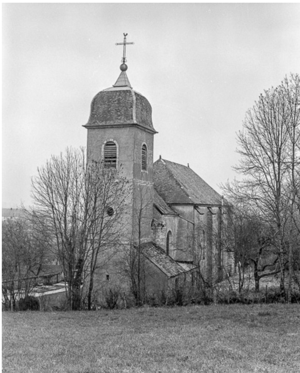
Extérieur : façades postérieure et latérale gauche.
