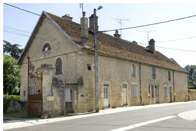
Logement ouvrier depuis le nord. Phot. Jérôme Mongreville IVR43_20087000613NUC2A
