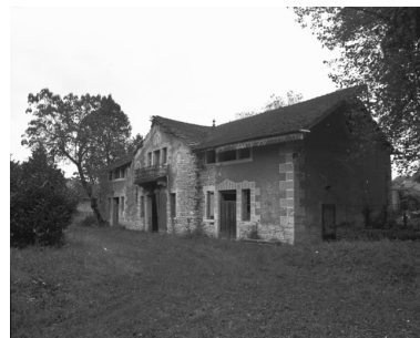
Ecurie. Vue de trois quarts droite en 1989. Phot. Yves Sancey IVR43_19897000650X
