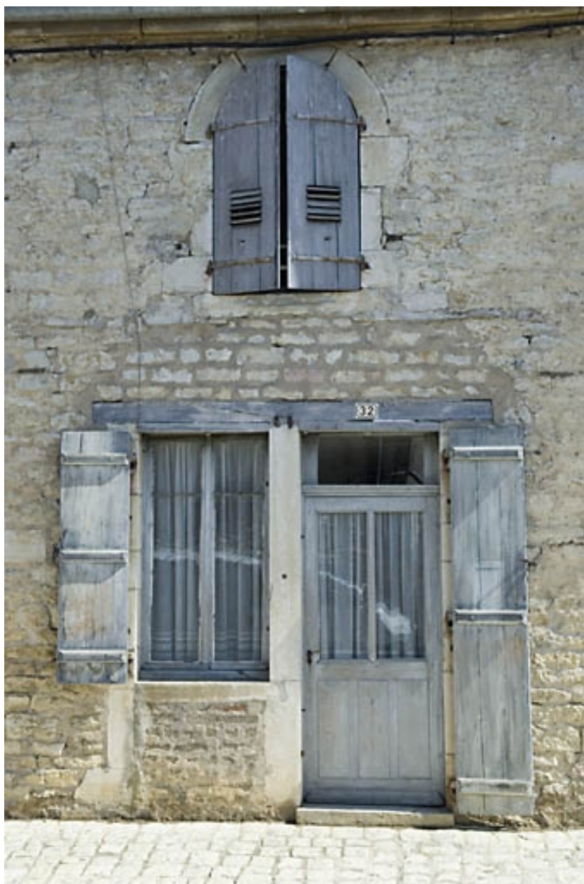
Travée de la façade du logement ouvrier.
