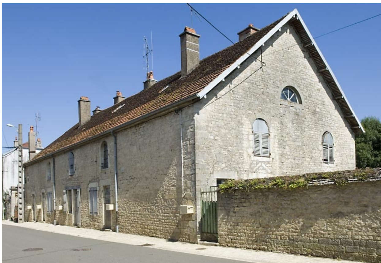
Logement ouvrier depuis l'ouest.
