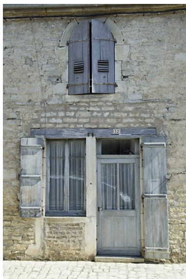
Travée de la façade du logement ouvrier. Phot. Jérôme Mongreville IVR43_20087000614NUC2A
