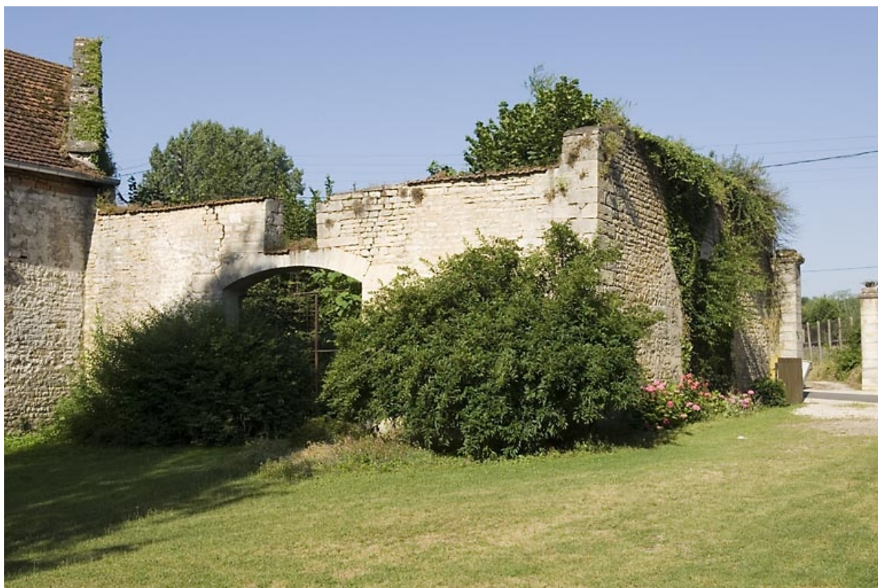
Vestiges de la halle à charbon.
