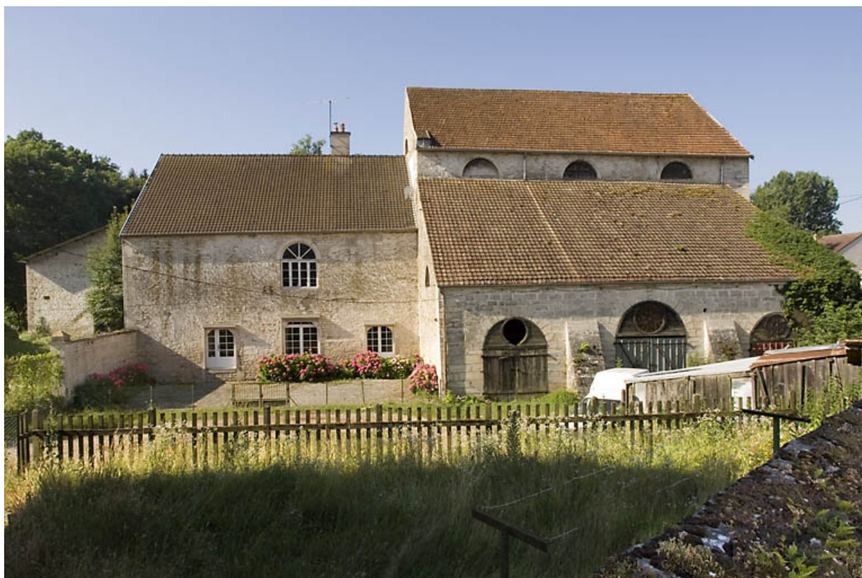
Façade nord du haut fourneau.
