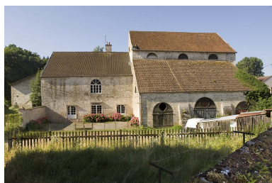
Façade nord du haut fourneau. Phot. Jérôme Mongreville IVR43_20087000605NUC2A
