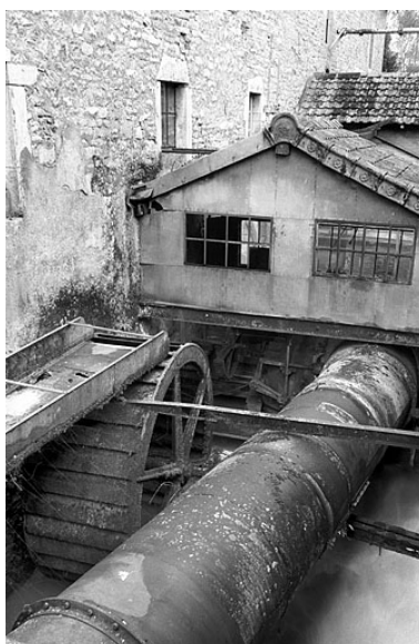
Roue hydraulique, conduite forcée et bâtiment d'eau. Phot. Laurent Poupard IVR43_19933900451Z
