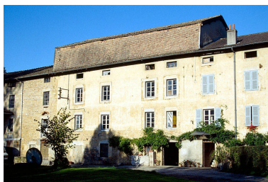
Partie centrale de la minoterie. Phot. Laurent Poupard IVR43_19933900447ZA
