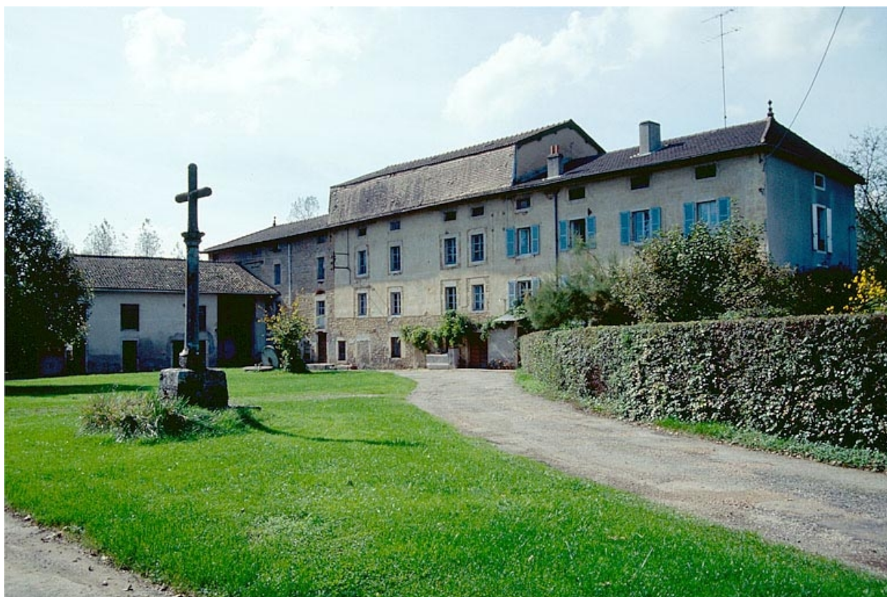
Vue d'ensemble depuis l'entrée de la cour.
