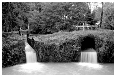
Vannes de décharge. Phot. Laurent Poupard IVR43_19933900457Z
