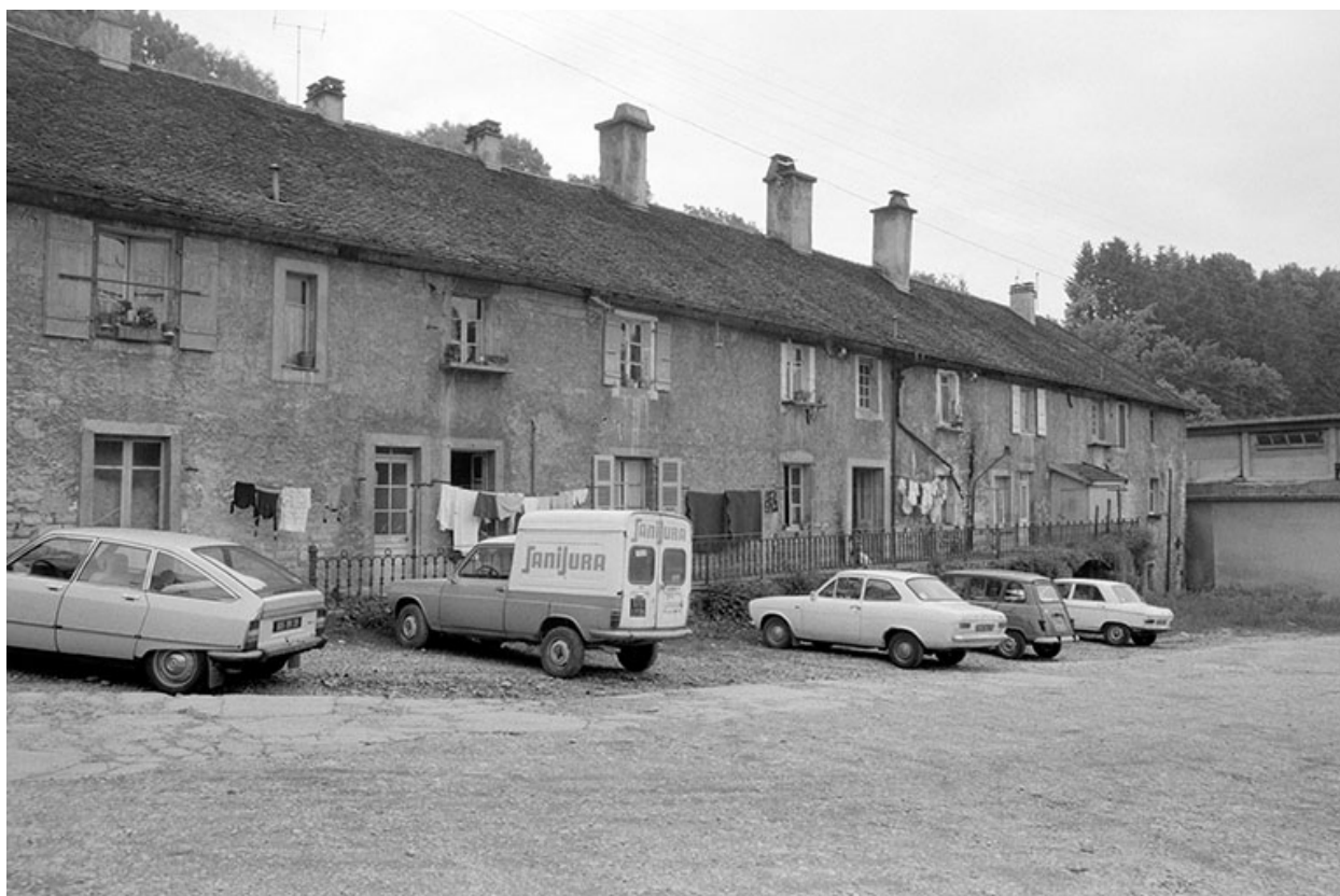
Logements d'ouvriers en 1980 : façade sur cour.
