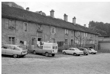
Logements d'ouvriers en 1980 : façade sur cour.
