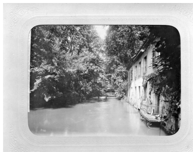
Canal et logement patrimonial, à la fin du 19e siècle. Phot. Yves Sancey, Autr. NEPASUTILISERDe Jongh Frères (photographe) IVR43_19883900494V
