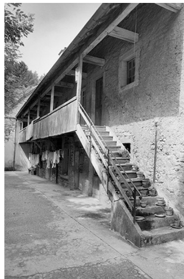
Façade postérieure d'un logement ouvrier en 1980.
