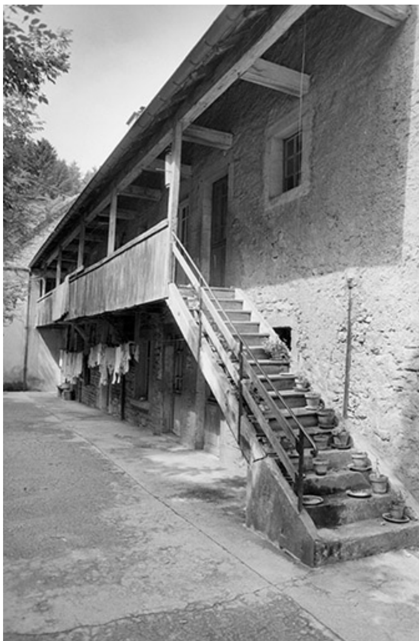
Façade postérieure d'un logement ouvrier en 1980.
