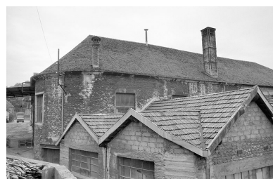
Extrémité est de l'atelier de forge en 1980. Phot. Jack Dumont IVR43_19803900314Z
