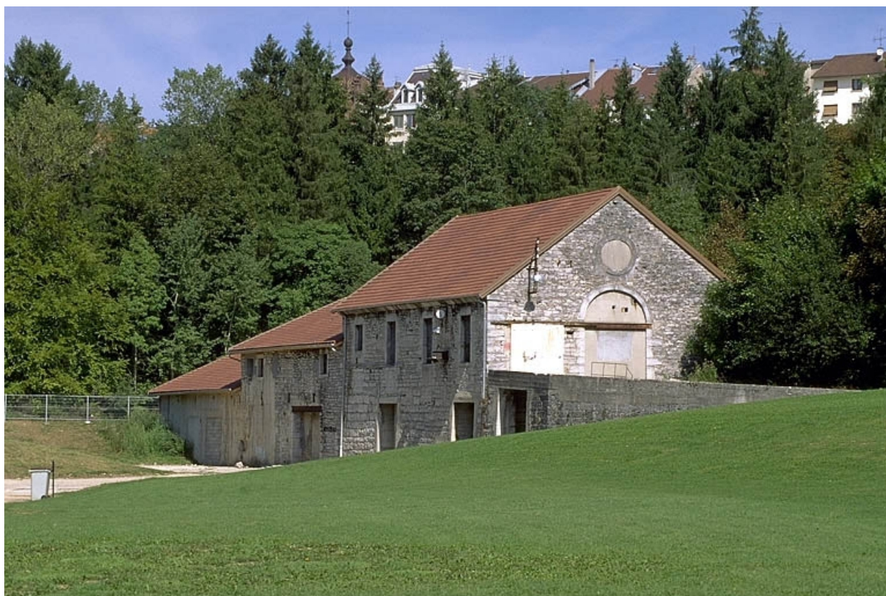
Ateliers de fabrication (galvanisation).
