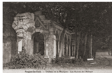
Vue ancienne. Autr. auteur inconnu IVR26_20195800744NUC4A
