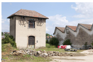
Transformateur. Phot. Jérôme Mongreville IVR43_20112501273NUC4A
