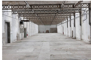
Extension ouest. Vue depuis le sud. Phot. Jérôme Mongreville IVR43_20112501286NUC4A
