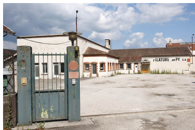
Bâtiments d'entrée. Phot. Jérôme Mongreville IVR43_20112501271NUC4A
