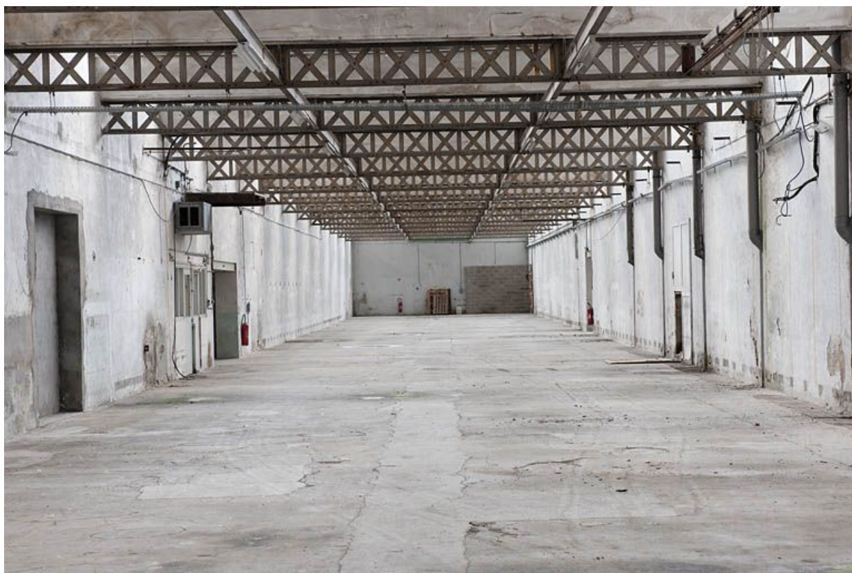
Extension ouest. Vue depuis le sud.
