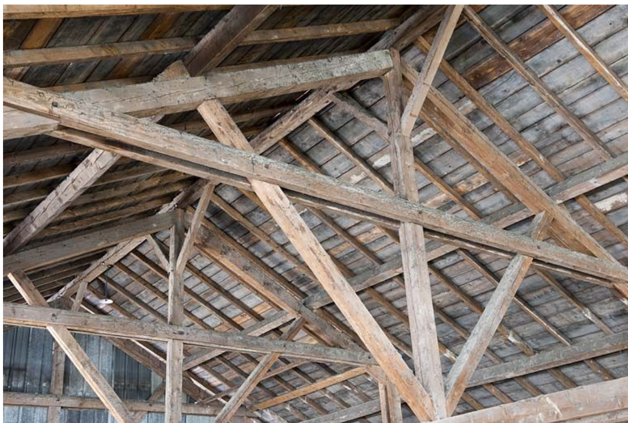
Entrepôt industriel. Détail de la charpente.
