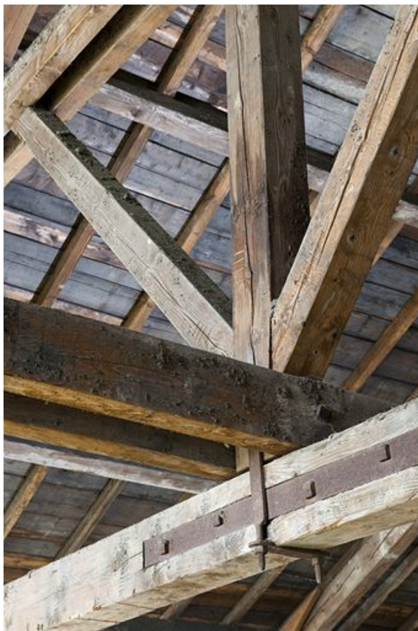
Entrepôt industriel. Charpente : jonction poinçon-entrait.
