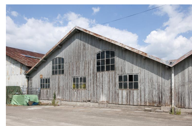
Pignon en bois d'un entrepôt industriel. Phot. Jérôme Mongreville IVR43_20112501269NUC4A
