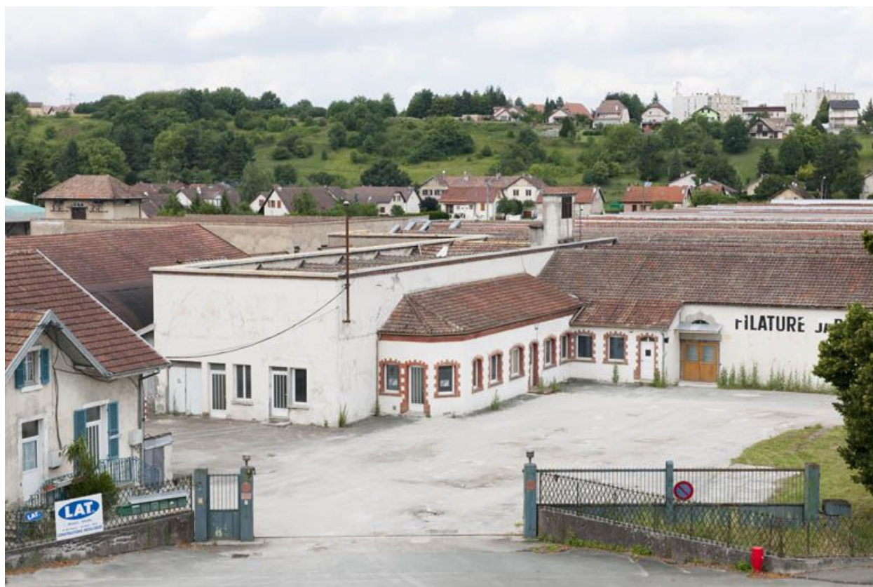
Vue d'ensemble plongeante depuis le sud.
