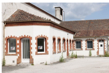
Bureaux. Phot. Jérôme Mongreville IVR43_20112501267NUC4A
