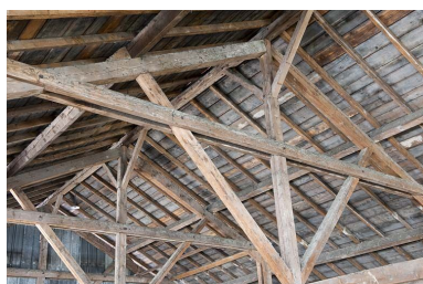
Entrepôt industriel. Détail de la charpente. Phot. Jérôme Mongreville IVR43_20112501279NUC4A
