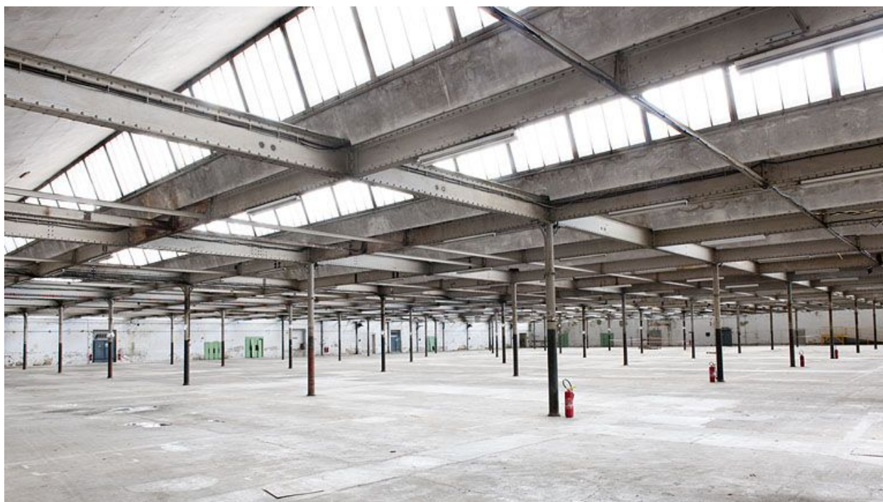
Salle de filature. Vue depuis le sud-est.
