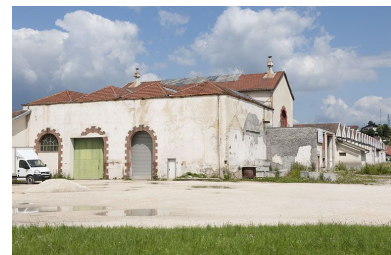
Salle des machines. Phot. Jérôme Mongreville IVR43_20112501265NUC4A
