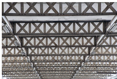
Extension ouest. Poutrelles à treillis de la charpente. Phot. Jérôme Mongreville IVR43_20112501285NUC4A
