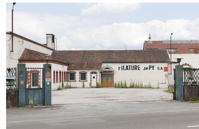
Entrée de l'usine. Phot. Jérôme Mongreville IVR43_20112501276NUC4A
