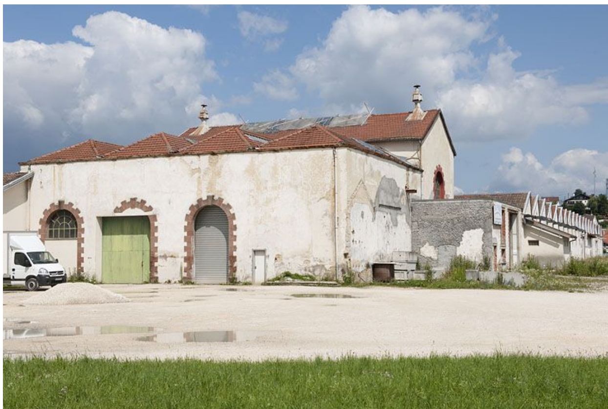
Salle des machines.
