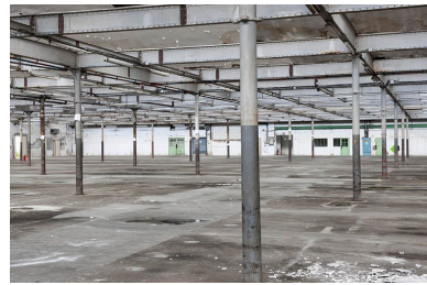
Salle de filature. Vue depuis le nord-ouest. Phot. Jérôme Mongreville IVR43_20112501284NUC4A
