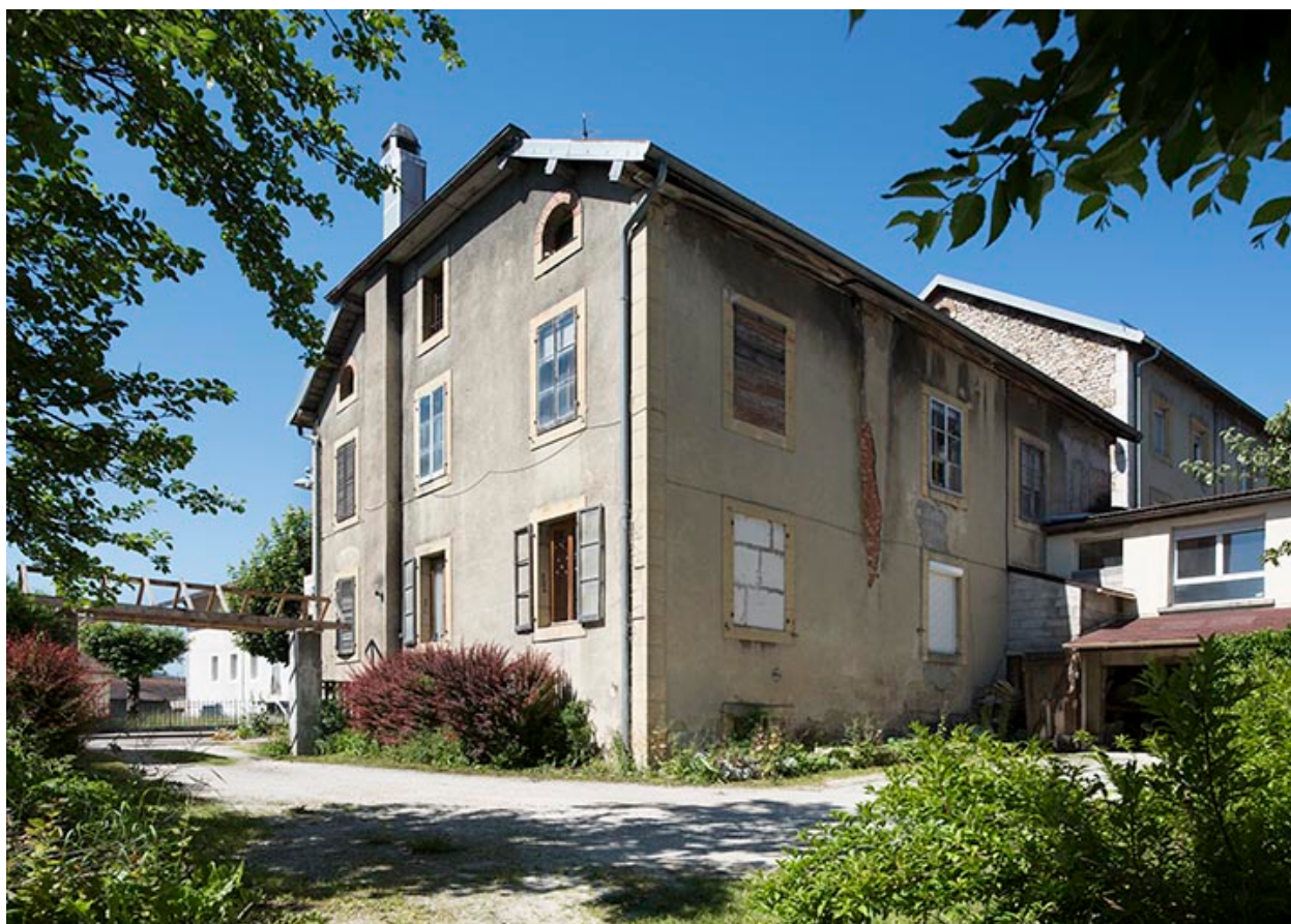
Façades postérieure et latérale droite.
