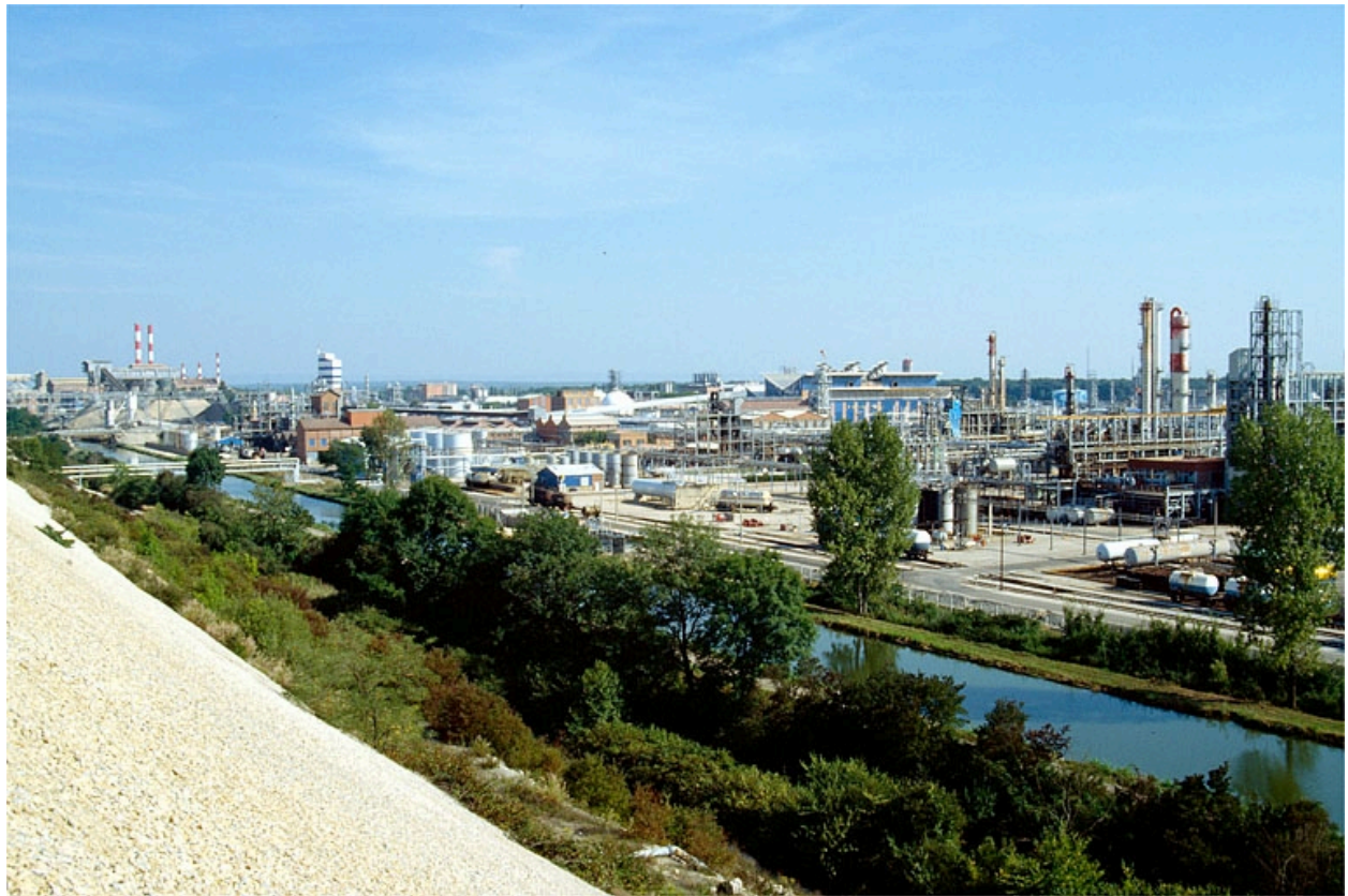
Vue d'ensemble depuis le haut des bassins de décantation.
