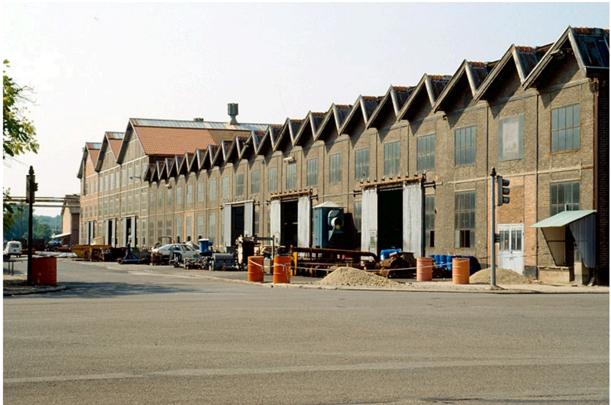
Ateliers de réparation (18) vus de trois quarts droit.
