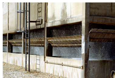
Détail de l'une des tours de réfrigération. Phot. Yves Sancey IVR43_19893900389ZA
