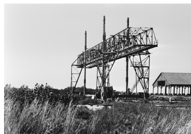
Montage du portique roulant du parc aux pièces.
