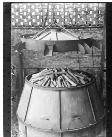
Fabrication de charbon de bois (ou de gaz carbonique ?) : mise en place du couvercle sur la machine.
