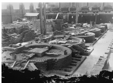
Atelier de caustification : construction des pots (batterie n° 4). Phot. Jérôme Mongreville, Phot. Charnotet IVR43_19903900063X
