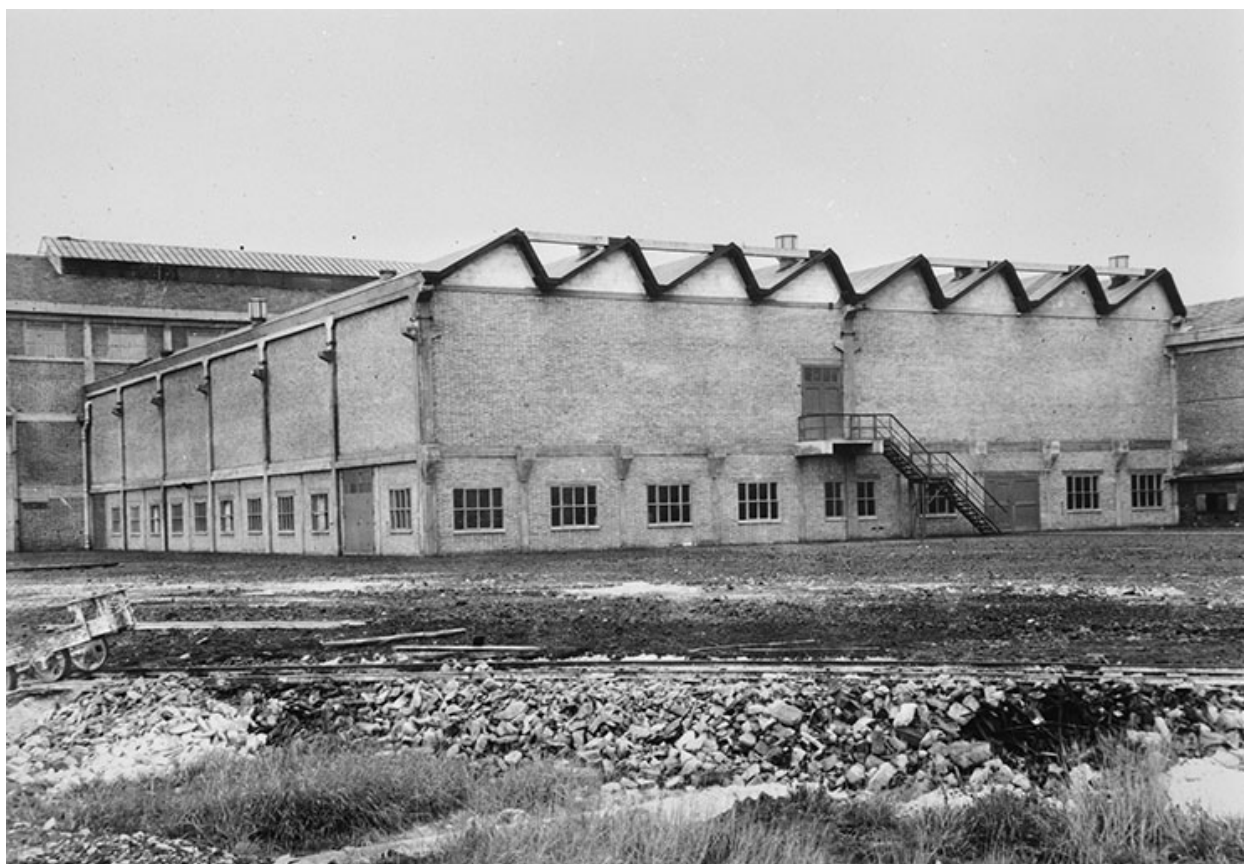
Usine d'électrolyse, Salle 2 : bâtiment des cellules.
