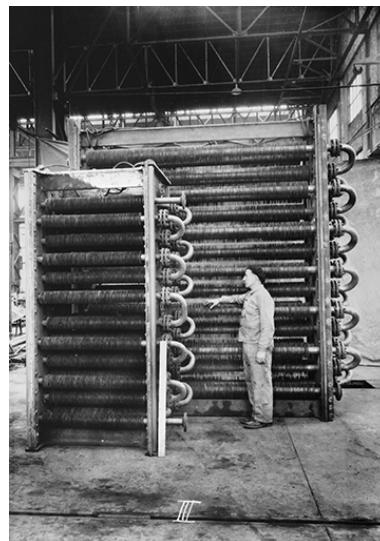
Atelier de réparation : remise en état de réchauffeurs de la caustification. Phot. Jérôme Mongreville, Phot. Charnotet IVR43_19903900070X
