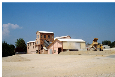
Bâtiments du broyeur vus du sud-ouest. Phot. Yves Sancey IVR43_19893900400ZA
