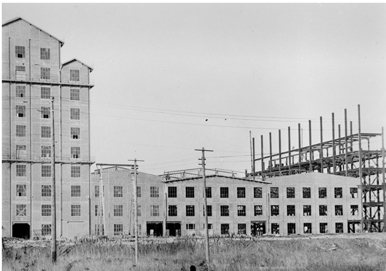
Soudière en construction, en 1930.
