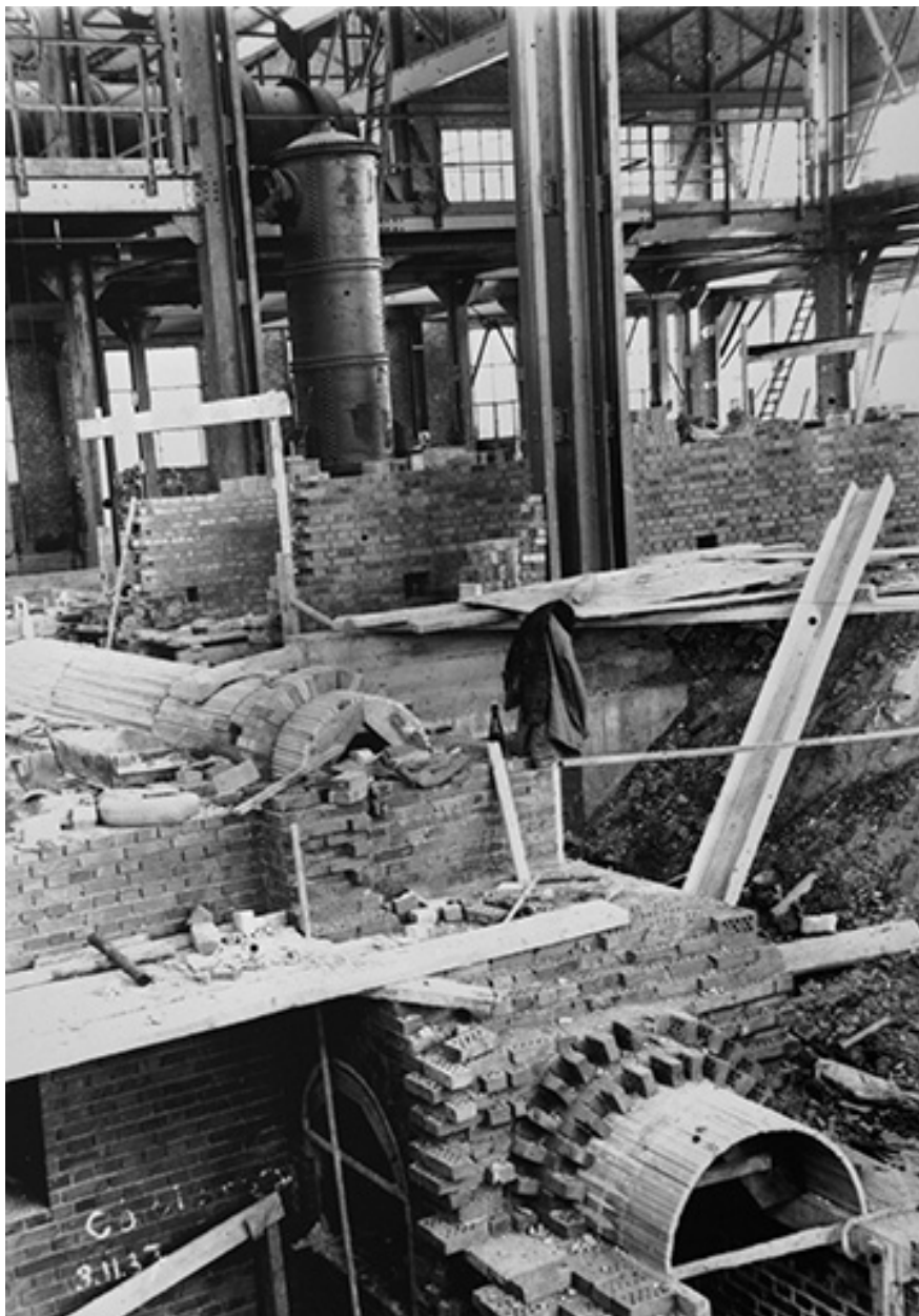
Atelier du chlorure de calcium : construction des pots.
