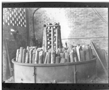
Fabrication de charbon de bois (ou de gaz carbonique ?) : 2e étape du chargement du bois dans la machine.
