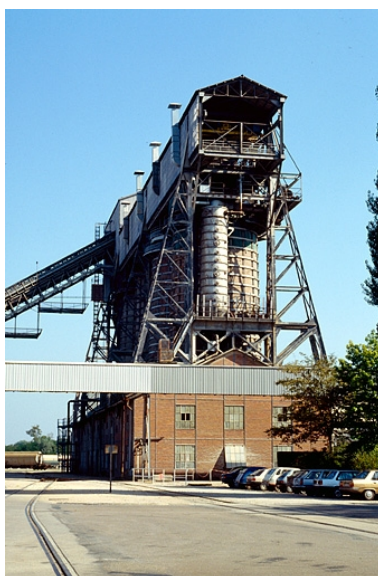
Fours à chaux vus du sud. Phot. Yves Sancey IVR43_19893900384ZA
