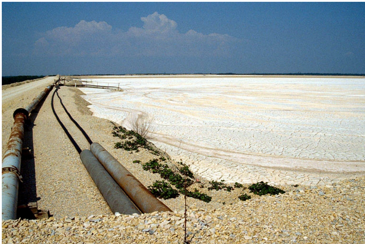
Bassins de décantation.
