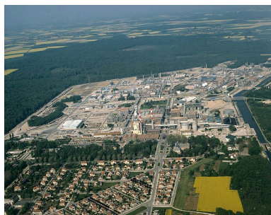
L'usine vue de l'est, photographie aérienne. Phot. Yves Sancey IVR43_19903900232XA
