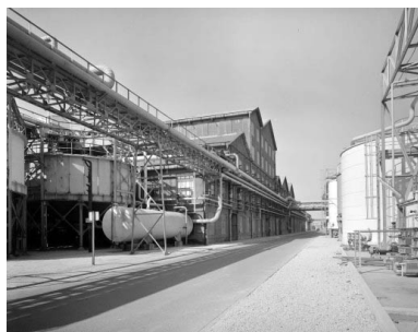
Bâtiment de la caustification (20) vu de l'est. Phot. Yves Sancey IVR43_19893900376V
