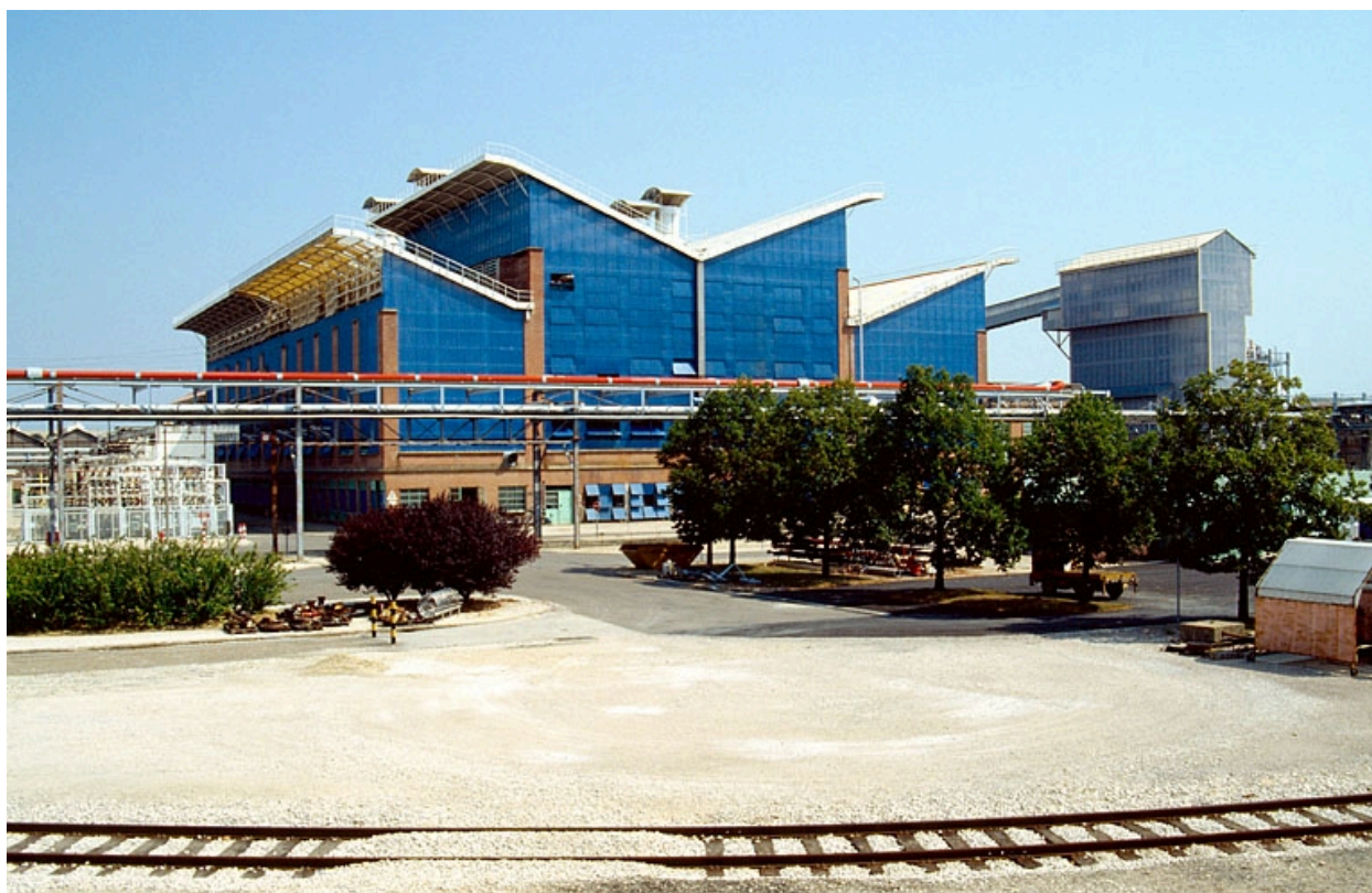
Usine d'électrolyse (37) vue du sud.
