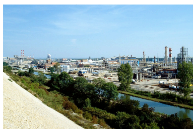
Vue d'ensemble depuis le haut des bassins de décantation. Phot. Yves Sancey IVR43_19893900357ZA
