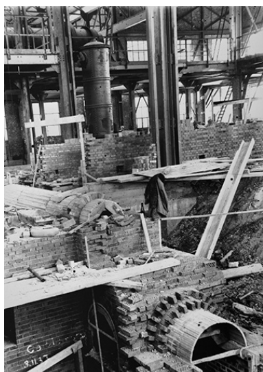
Atelier du chlorure de calcium : construction des pots. Phot. Jérôme Mongreville, Phot. Charnotet IVR43_19903900065X
