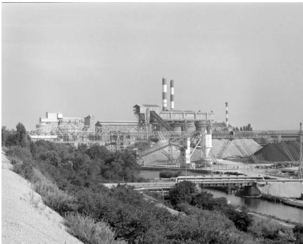
Caisses à soude (13) et fours à chaux (9) vus du haut des bassins de décantation.
