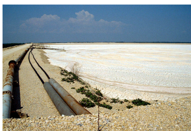
Bassins de décantation. Phot. Yves Sancey IVR43_19893900405ZA
