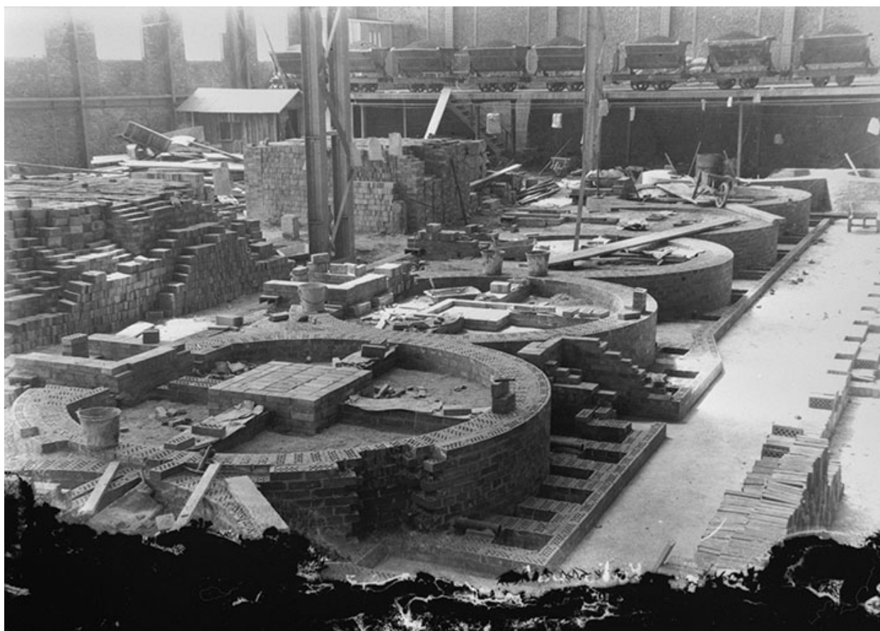
Atelier de caustification : construction des pots (batterie n° 4).
