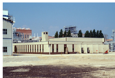
Salle de contrôle type blockaus du P79 (29).
