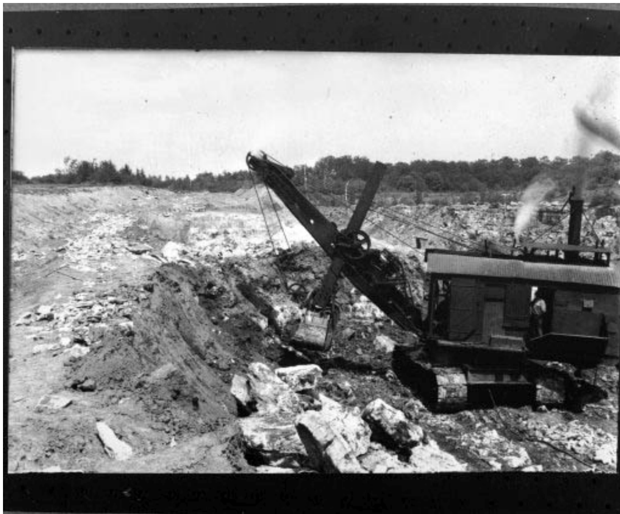
Excavatrice à vapeur Bucyrus, vers 1930.
