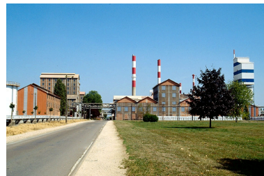
Soudière (10) et ancien atelier du chlorure de calcium (à l'extrémité de la caustification 20), vus de l'ouest. Phot. Yves Sancey IVR43_19893900375ZA
