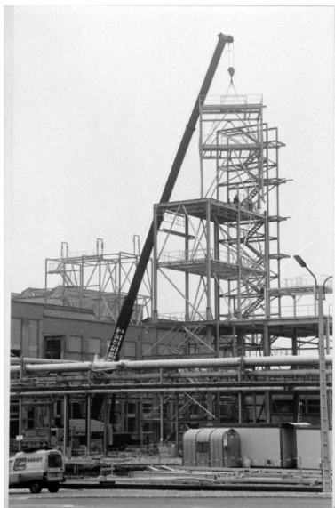
Mise en place de la structure du PVDF. Phot. Jean-Pierre Bévalot, Autr. Bernard Lamy IVR43_19903900135ZC
