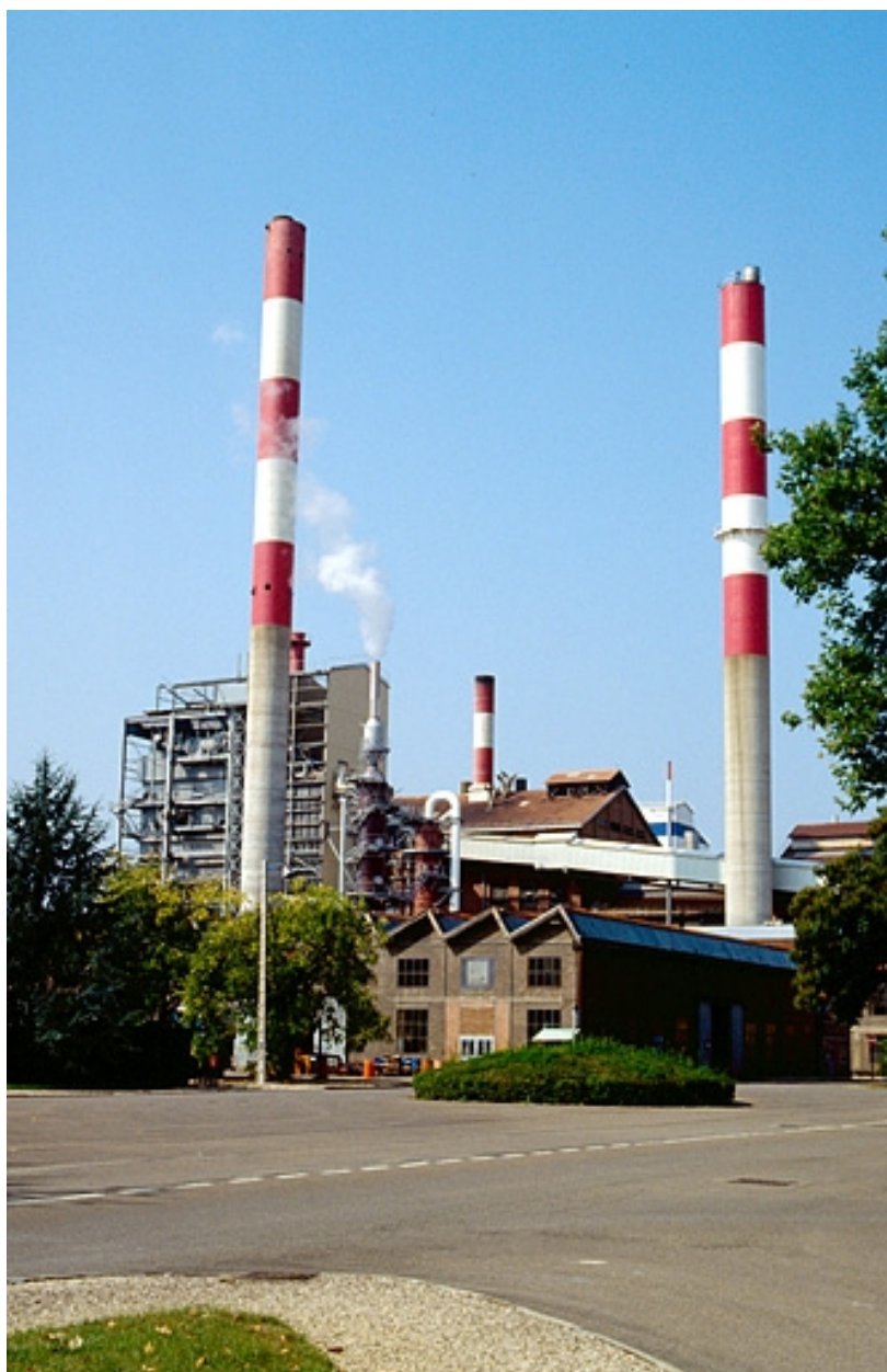
Ateliers de réparation (18) et chaufferie (19), vus du nord-est.
