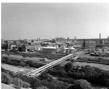
Division Electrolyse vue depuis le haut des bassins de décantation. Phot. Yves Sancey IVR43_19893900358X
