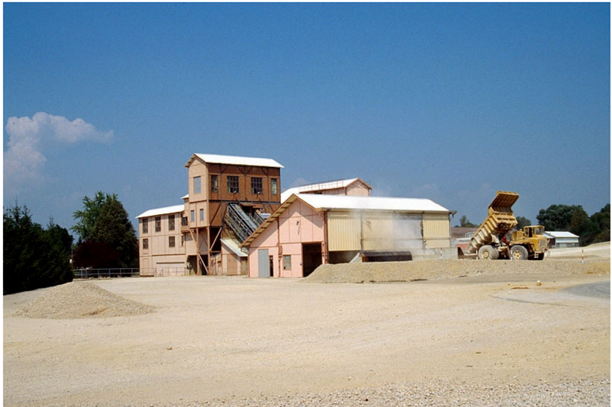
Bâtiments du broyeur vus du sud-ouest.
