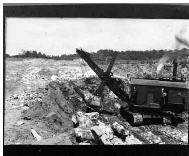
Excavatrice à vapeur Bucyrus, vers 1930. Phot. Jérôme Mongreville, Phot. Charnotet IVR43_19903900077X
