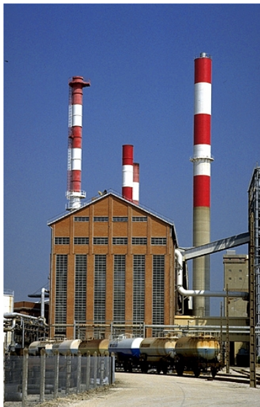
Façade postérieure du bâtiment des générateurs de vapeur et d'électricité. Phot. Yves Sancey IVR43_19893900374ZA
