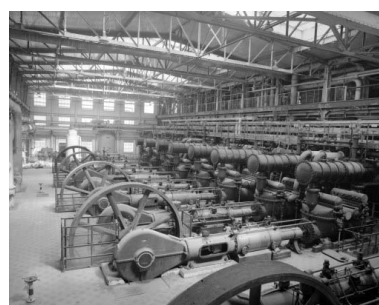
Soudière, salle des machines : vue d'ensemble des pompes à gaz (vue de trois quarts). Phot. Yves Sancey IVR43_19893900417X
