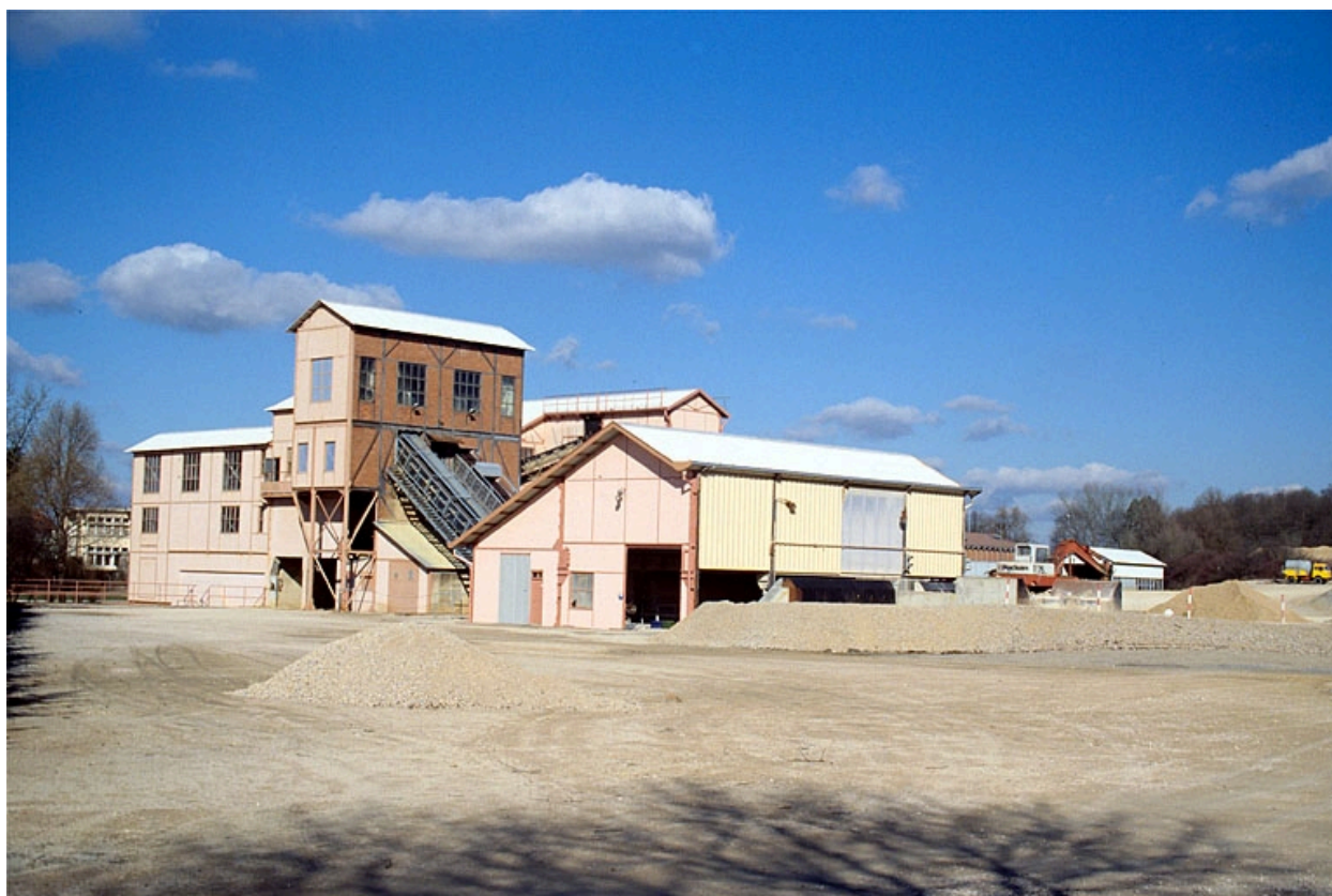
Bâtiments du broyeur vus du sud-ouest.
