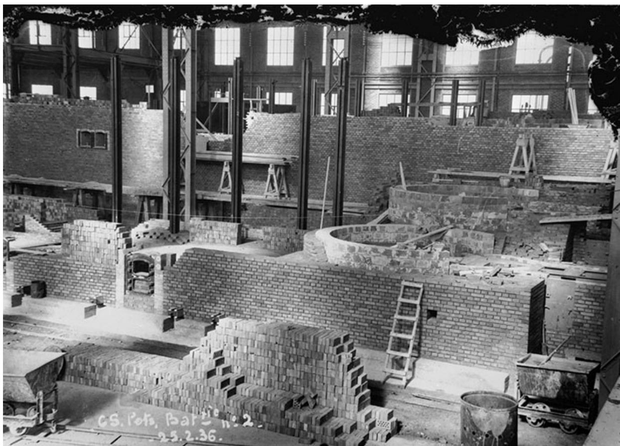
Atelier de caustification : construction des pots (batterie n° 2).
