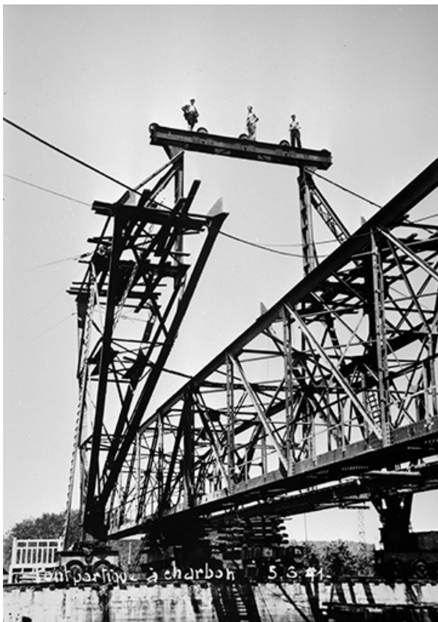
Remontage du pont-portique à charbon, en 1941.
