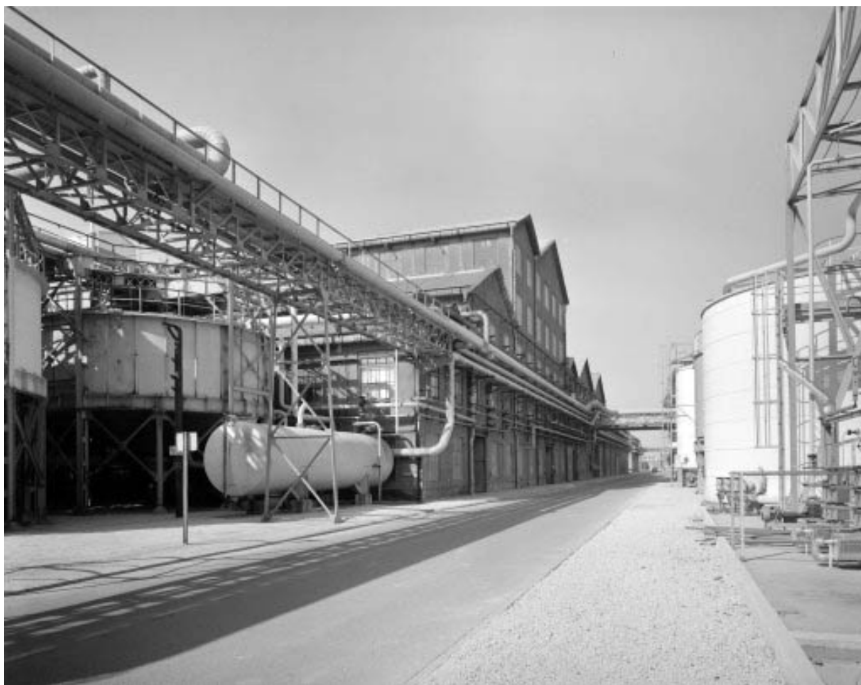
Bâtiment de la caustification (20) vu de l'est.
