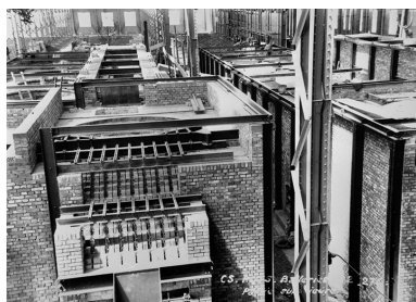
Atelier de caustification : construction des pots (partie supérieure de la batterie n° 2). Phot. Jérôme Mongreville IVR43_19903900062X
