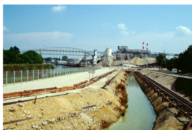
Contre-fossé unissant l'usine à la Saône via l'étang de l'Aillon. Phot. Yves Sancey IVR43_19893900380ZA
