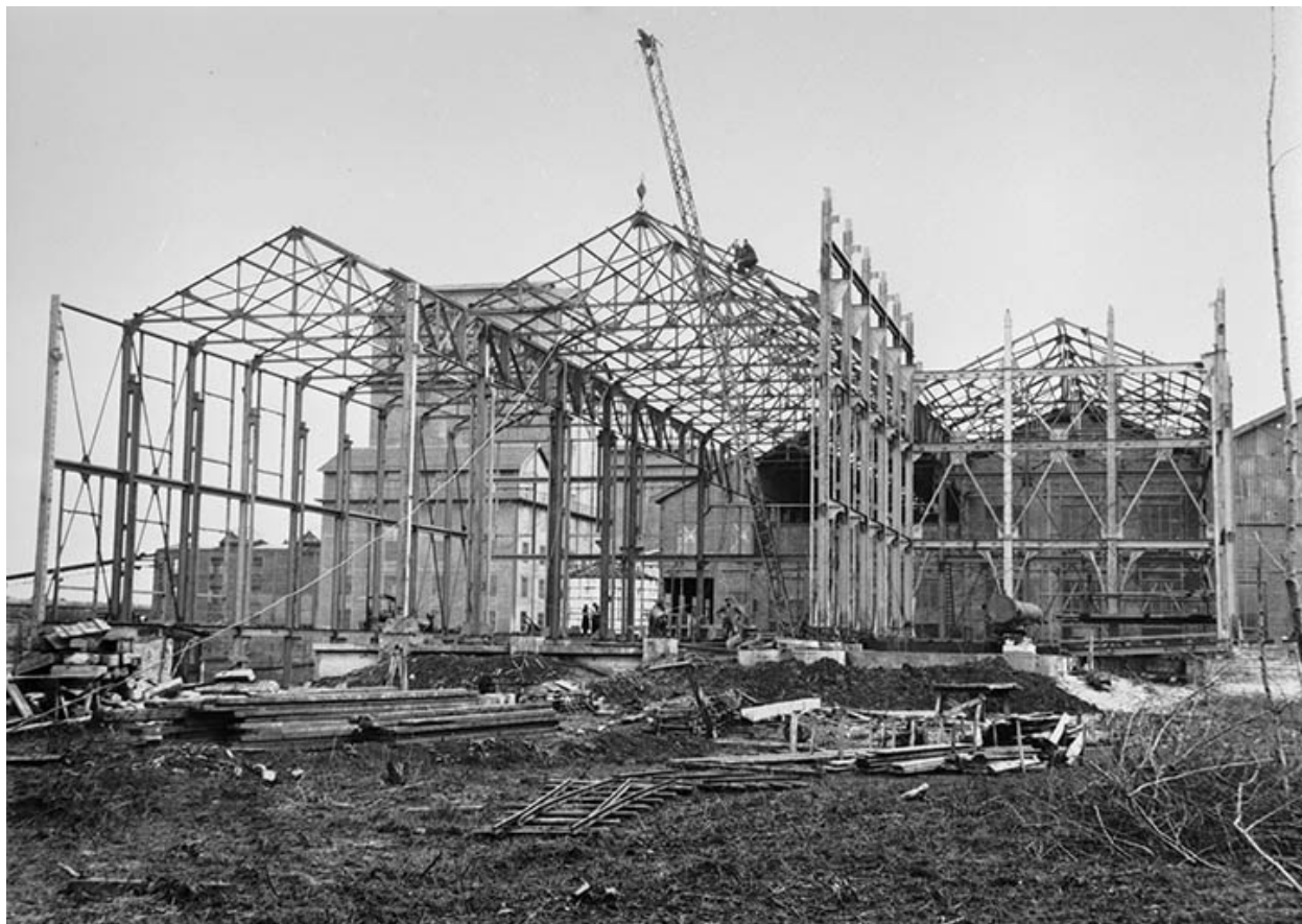
Construction de l'atelier du chlorure de calcium : montage de la charpente, en 1937].
