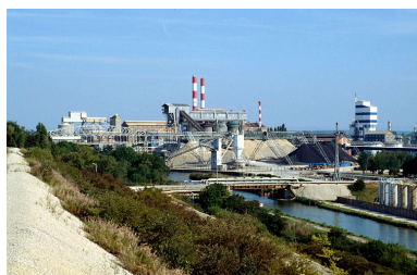
Division Alcalis vue depuis le haut des bassins de décantation (vue rapprochée).
