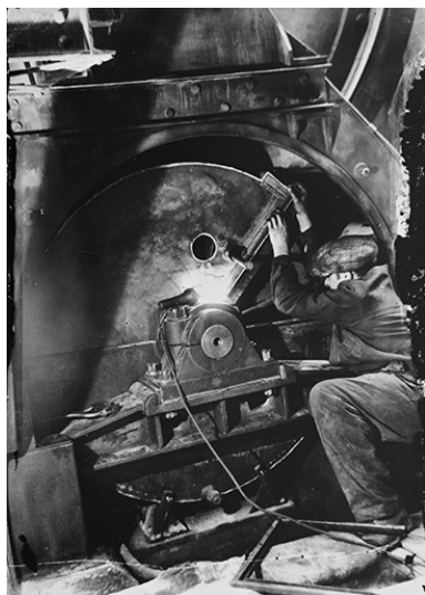
Atelier de réparation : intervention sur le galet sécheur d'un four tournant de la soudière. Phot. Jérôme Mongreville, Phot. Charnotet IVR43_19903900071X
