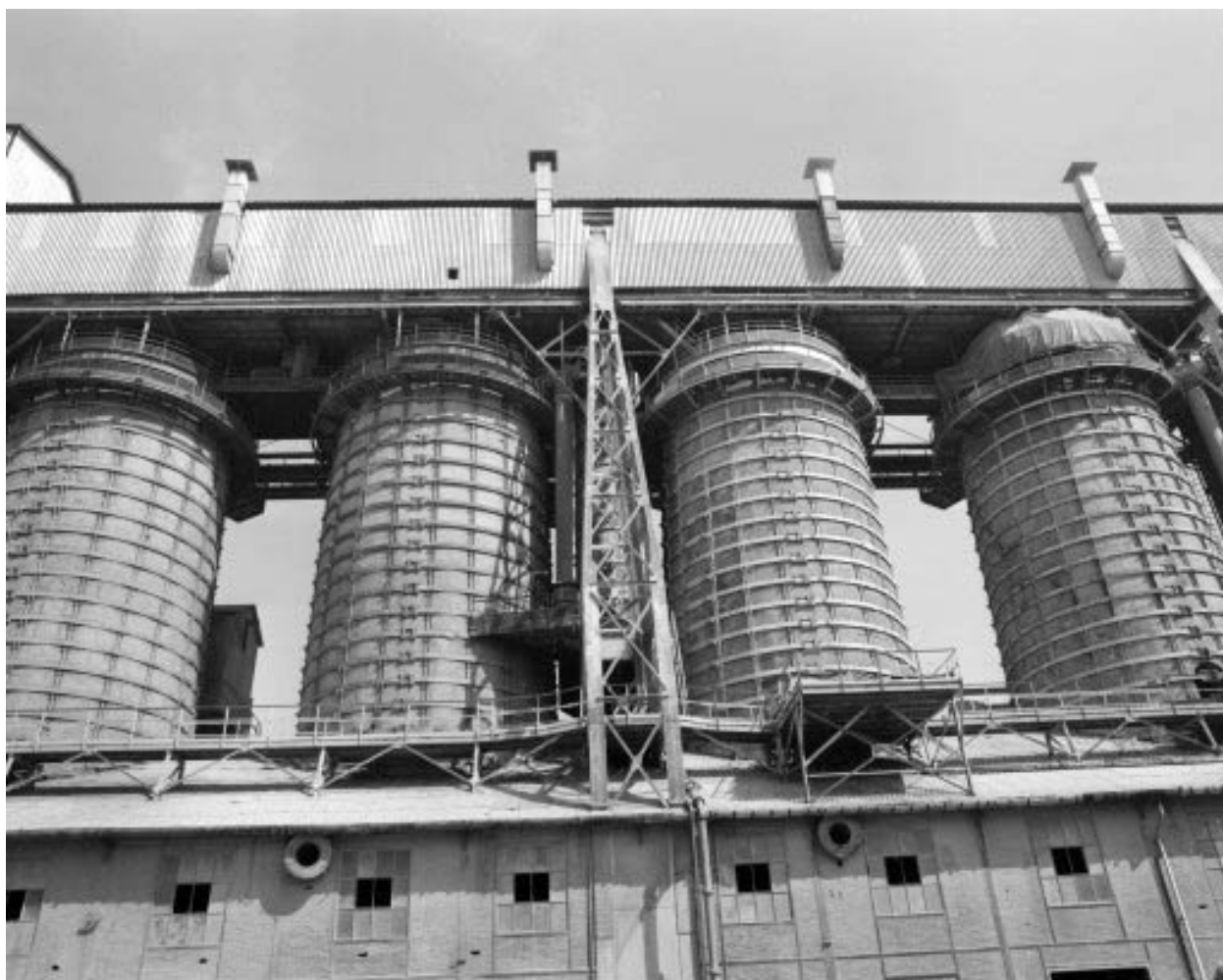
Fours à chaux vus en contre-plongée.
