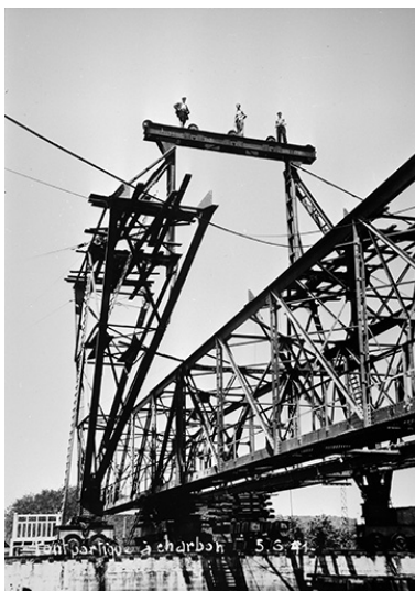
Remontage du pont-portique à charbon, en 1941. Phot. Jérôme Mongreville, Phot. Charnotet IVR43_19903900057X
