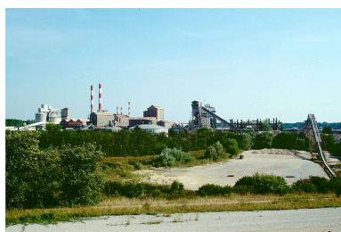
Division Alcalis vue du nord. Phot. Yves Sancey IVR43_19893900362ZA
