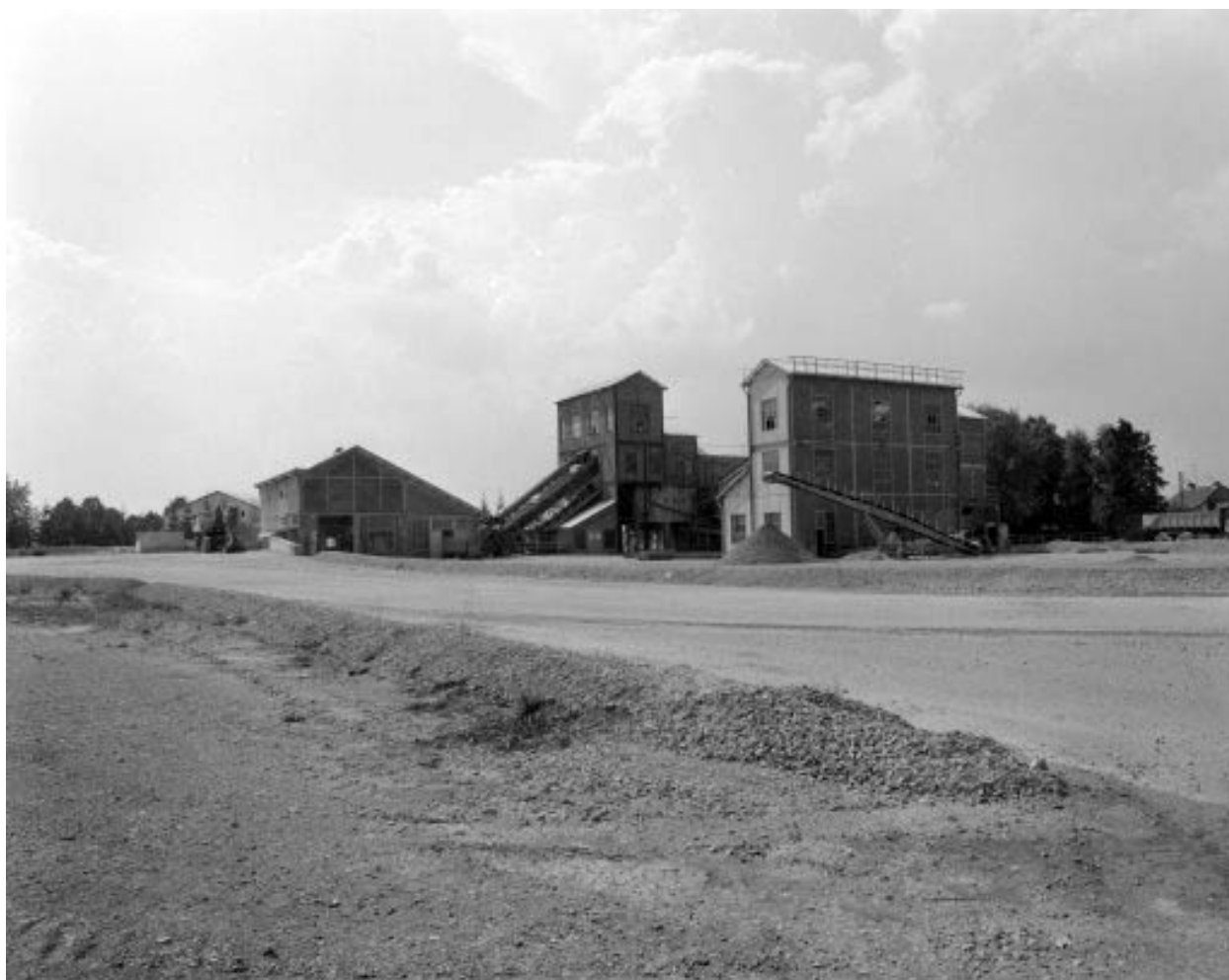
Bâtiments du broyeur (1) vus du nord-est.
