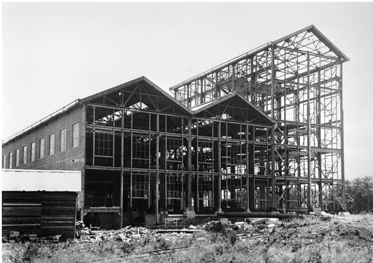
Construction de l'atelier du chlorure de calcium : briquetage et couverture.
