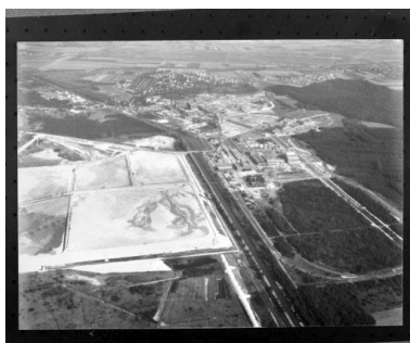
Vue d'ensemble de l'usine depuis l'ouest [vue aérienne].
