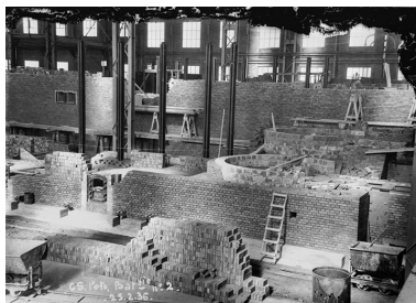
Atelier de caustification : construction des pots (batterie n° 2). Phot. Jérôme Mongreville, Phot. Charnotet IVR43_19903900060X
