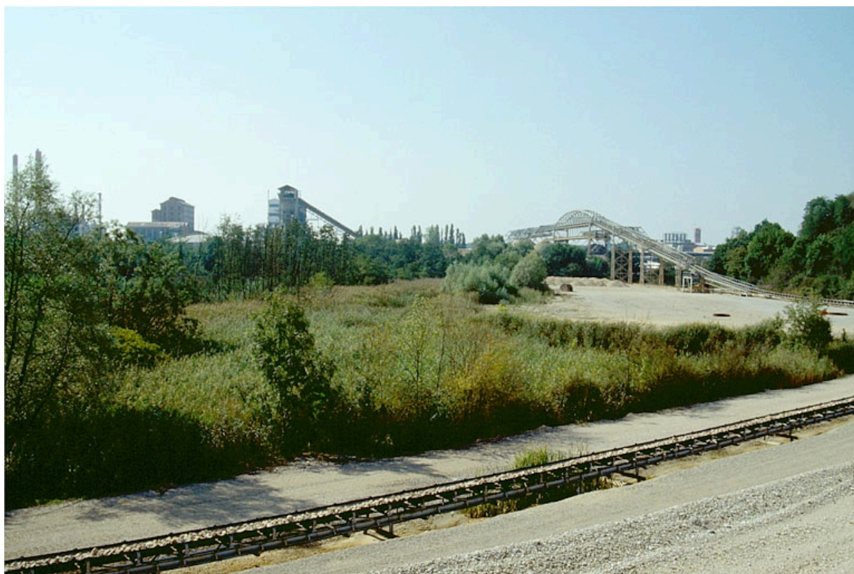
Transporteur automatique à bande et portique sur le canal, vus du nord.
