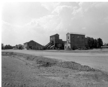
Bâtiments du broyeur (1) vus du nord-est. Phot. Yves Sancey IVR43_19893900399X
