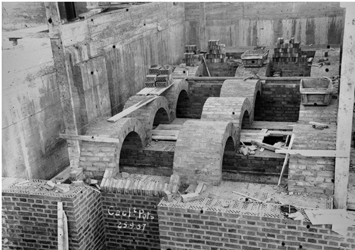
Atelier du chlorure de calcium : construction des pots.
