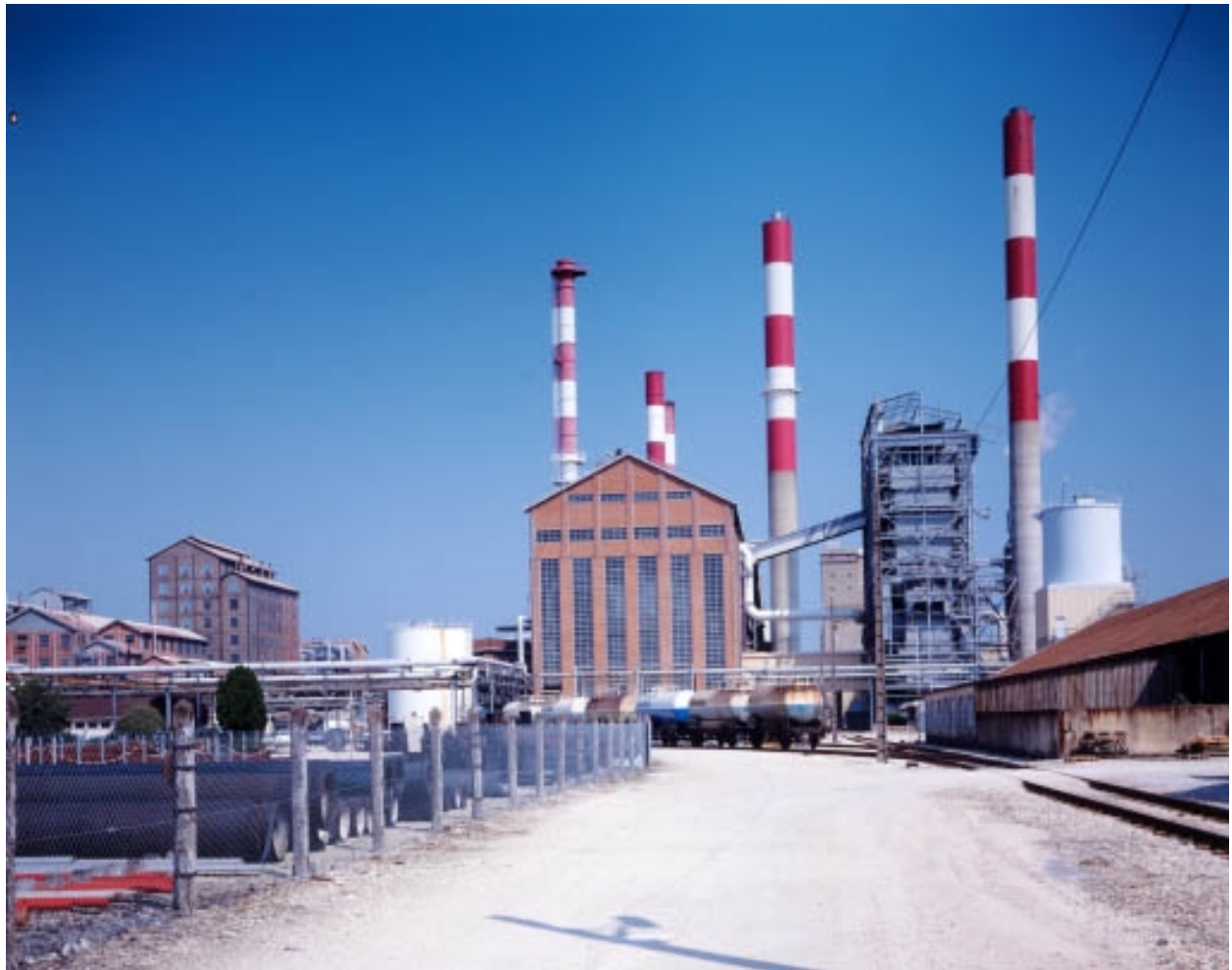
Façade postérieure de la chaufferie et des générateurs de vapeur et d'électricité.
