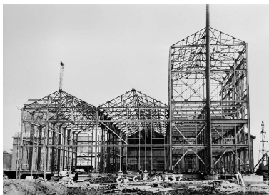
Construction de l'atelier du chlorure de calcium : montage de la charpente. Phot. Jérôme Mongreville, Phot. Charnotet IVR43_19903900051X
