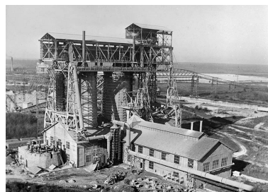
Construction des fours à chaux : mise en place de la base du 3e four, vers 1931.
