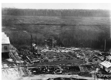
Construction de l'atelier du chlorure de calcium ( \text{CaCl}_2 ) : enfoncement des pilots. Phot. Jérôme Mongreville, Phot. Charnotet IVR43_19903900048X
