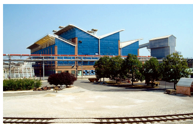
Usine d'électrolyse (37) vue du sud. Phot. Yves Sancey IVR43_19893900387ZA
