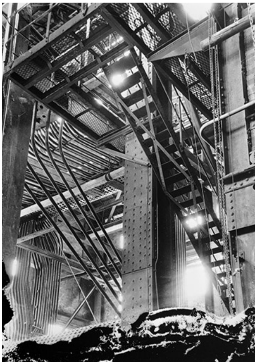
Tuyauterie des générateurs de vapeur au charbon.
