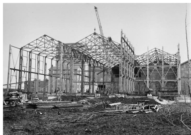
Construction de l'atelier du chlorure de calcium : montage de la charpente, en 1937]. Phot. Jérôme Mongreville, Phot. Charnotet IVR43_19903900050X
