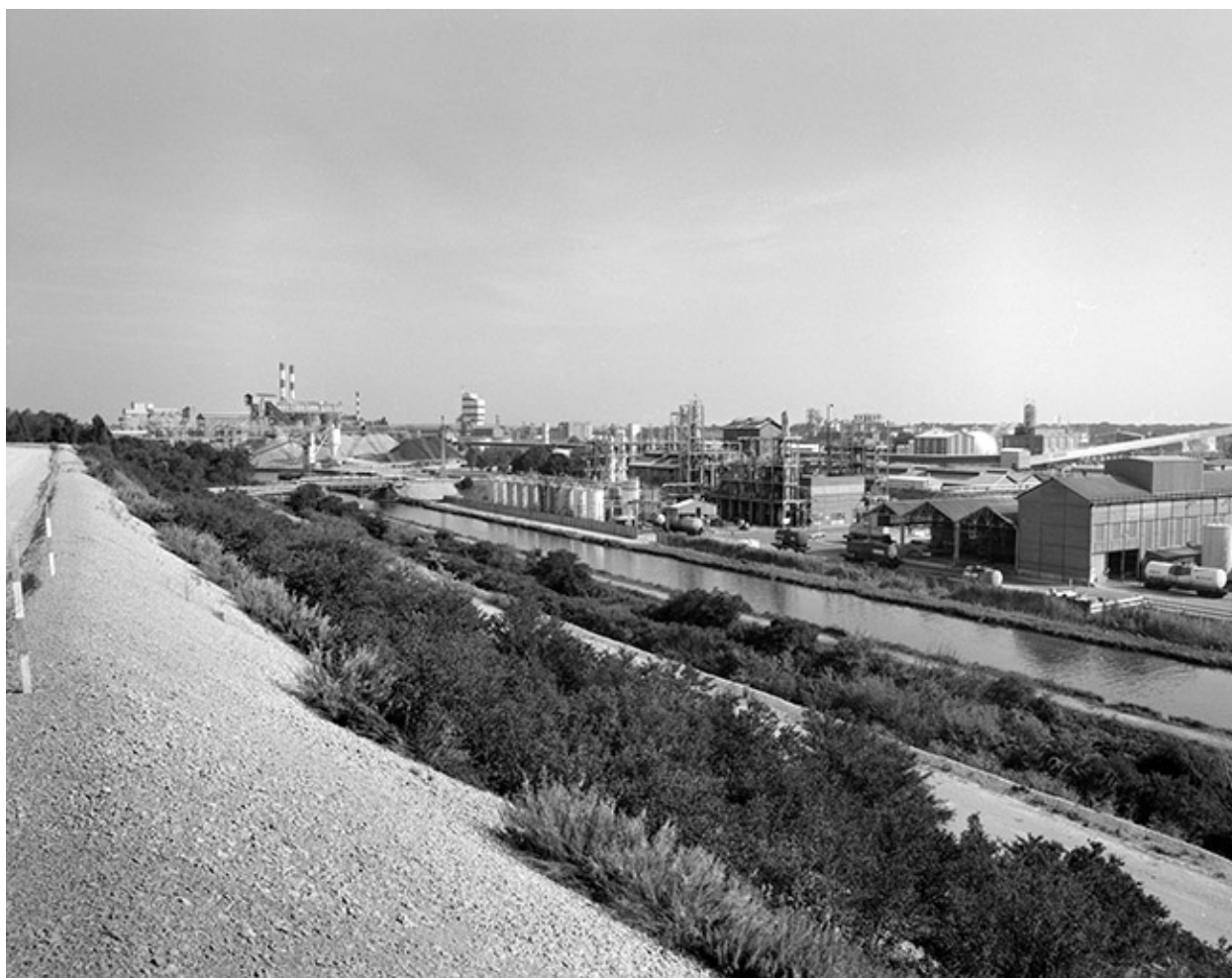
Division Alcalis vue depuis le haut des bassins de décantation.
