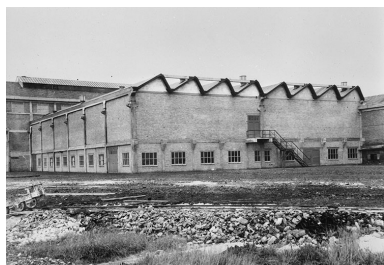
Usine d'électrolyse, Salle 2 : bâtiment des cellules. Phot. Jérôme Mongreville, Phot. Charnotet IVR43_19903900056X
