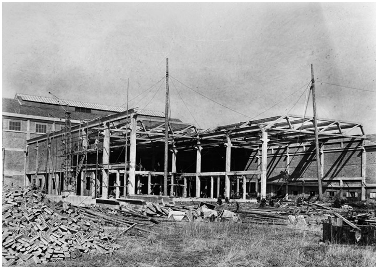
Usine d'électrolyse, Salle 2 : construction du bâtiment des cellules.
