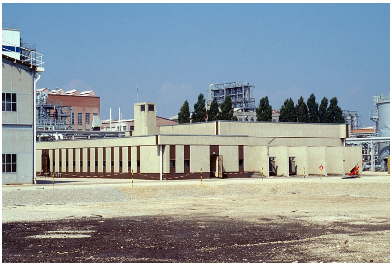
Salle de contrôle type blockaus du P79 (29).
