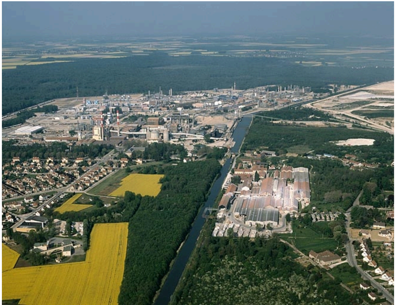
Vue d'ensemble depuis l'est, photographie aérienne.
