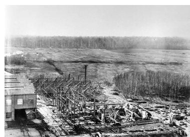
Construction de l'atelier du chlorure de calcium : montage de l'ossature métallique. Phot. Jérôme Mongreville, Phot. Charnotet IVR43_19903900049X
