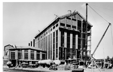
Agrandissement du bâtiment des générateurs. Phot. Jérôme Mongreville, Phot. Charnotet IVR43_19903900058X
