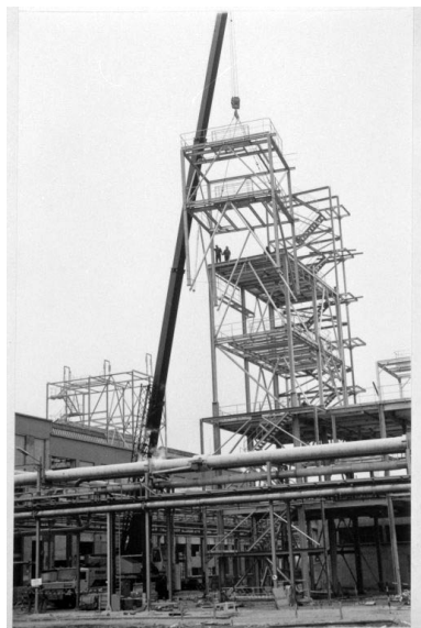
Mise en place de la structure du PVDF. Phot. Jean-Pierre Bévalot, Autr. Bernard Lamy IVR43_19903900134ZC
