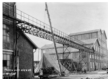
Mise en place du portique entre l'atelier de caustification et le bâtiment des générateurs d'électricité et de vapeur. Phot. Jérôme Mongreville, Phot. Charnotet IVR43_19903900046X
