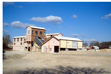
Bâtiments du broyeur vus du sud-ouest. Phot. Yves Sancey IVR43_19893900386ZA
