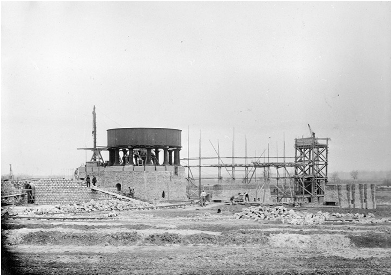
Construction des fours à chaux : base du 1er four.
