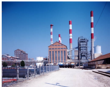
Façade postérieure de la chaudière et des générateurs de vapeur et d'électricité. Phot. Yves Sancey IVR43_19893900373VA
