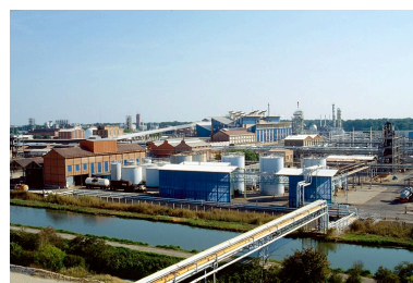
Division Electrolyse vue depuis le haut des bassins de décantation. Phot. Yves Sancey IVR43_19893900359ZA
