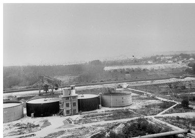
Réservoirs à saumure, en avant du port.
