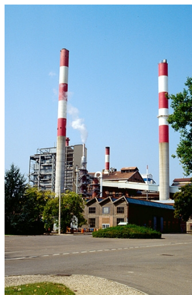
Ateliers de réparation (18) et chaufferie (19), vus du nord-est. Phot. Yves Sancey IVR43_19893900369ZA
