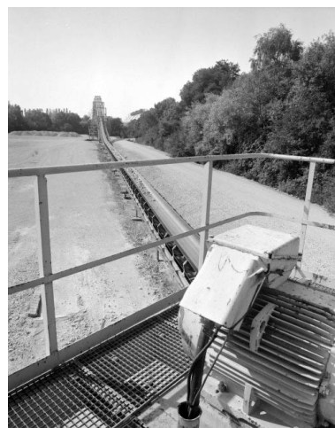
Transporteur automatique à bande et portique sur le canal, vus depuis l'installation de renvoi (3). Phot. Yves Sancey IVR43_19893900402X
