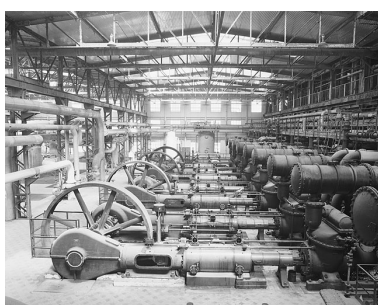
Soudière, salle des machines : vue d'ensemble des pompes à gaz depuis le sud. Phot. Yves Sancey IVR43_19893900416X
