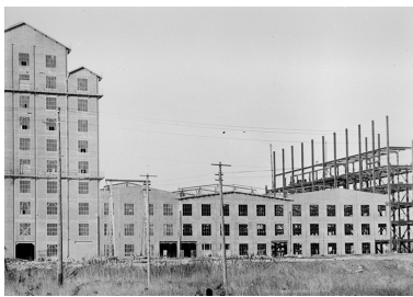
Soudière en construction, en 1930.
