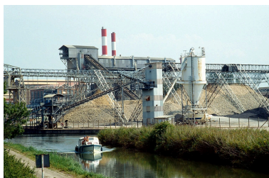
Fours à chaux (9) et aire des matières premières (7) vus du nord-ouest. Phot. Yves Sancey IVR43_19893900378ZA
