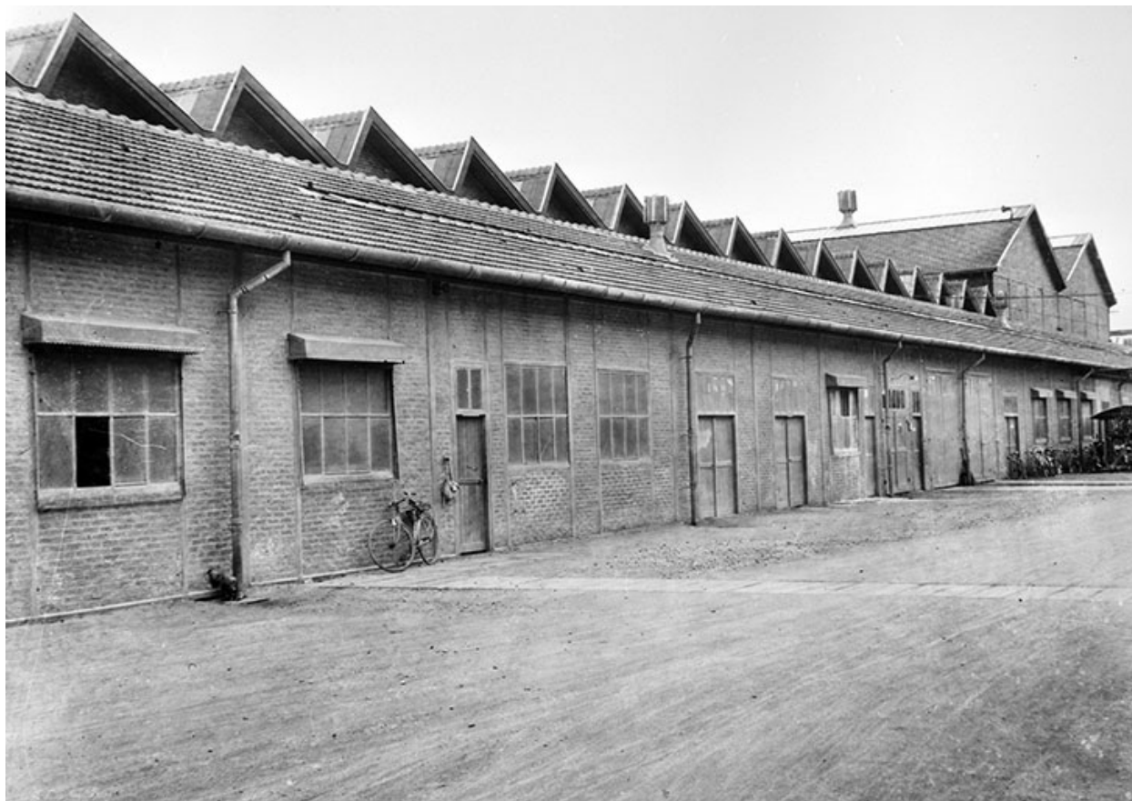
Façade des ateliers de réparation (ATM).
