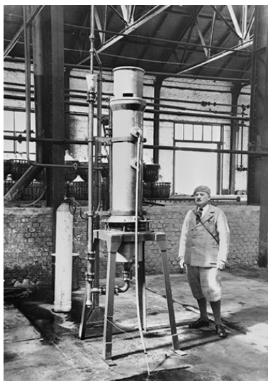
Appareil pour la fabrication d'hypochlorite de soude (eau de javel), fabriqué et commercialisé par la société Solvay. Phot. Jérôme Mongreville, Phot. Charnotet IVR43_19903900072X
