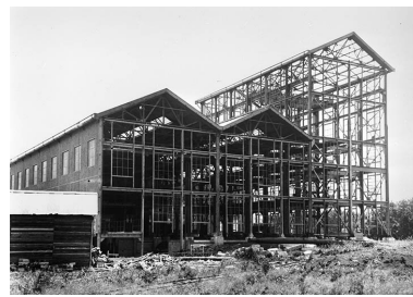
Construction de l'atelier du chlorure de calcium : briquetage et couverture. Phot. Jérôme Mongreville, Phot. Charnotet IVR43_19903900052X
