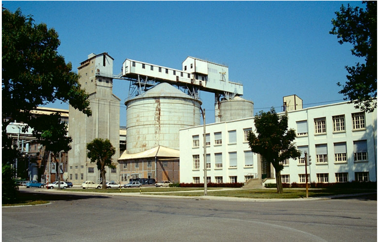
Caisses à soude (13) et laboratoire (14).
