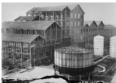
Construction de l'atelier de caustification : briquetage. Phot. Jérôme Mongreville, Phot. Charnotet IVR43_19903900045X
