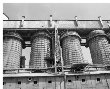
Fours à chaux vus en contre-plongée. Phot. Yves Sancey IVR43_19893900385X
