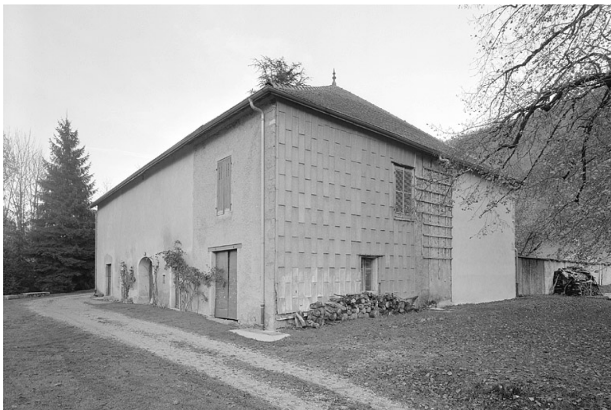
Face sud-ouest et façade postérieure.
