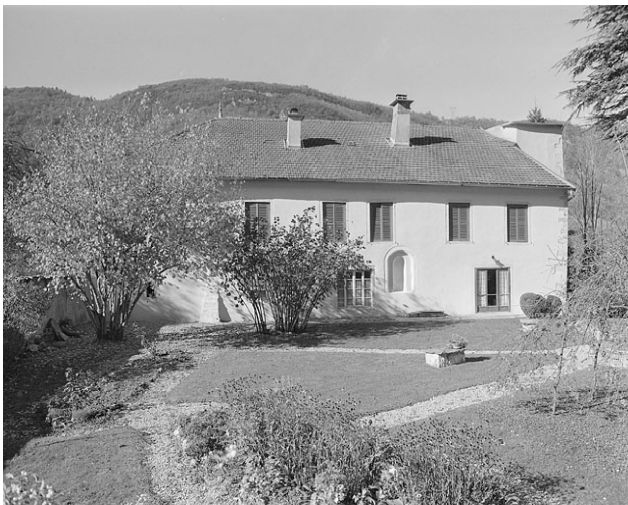
Façade principale, vue de trois quarts.
