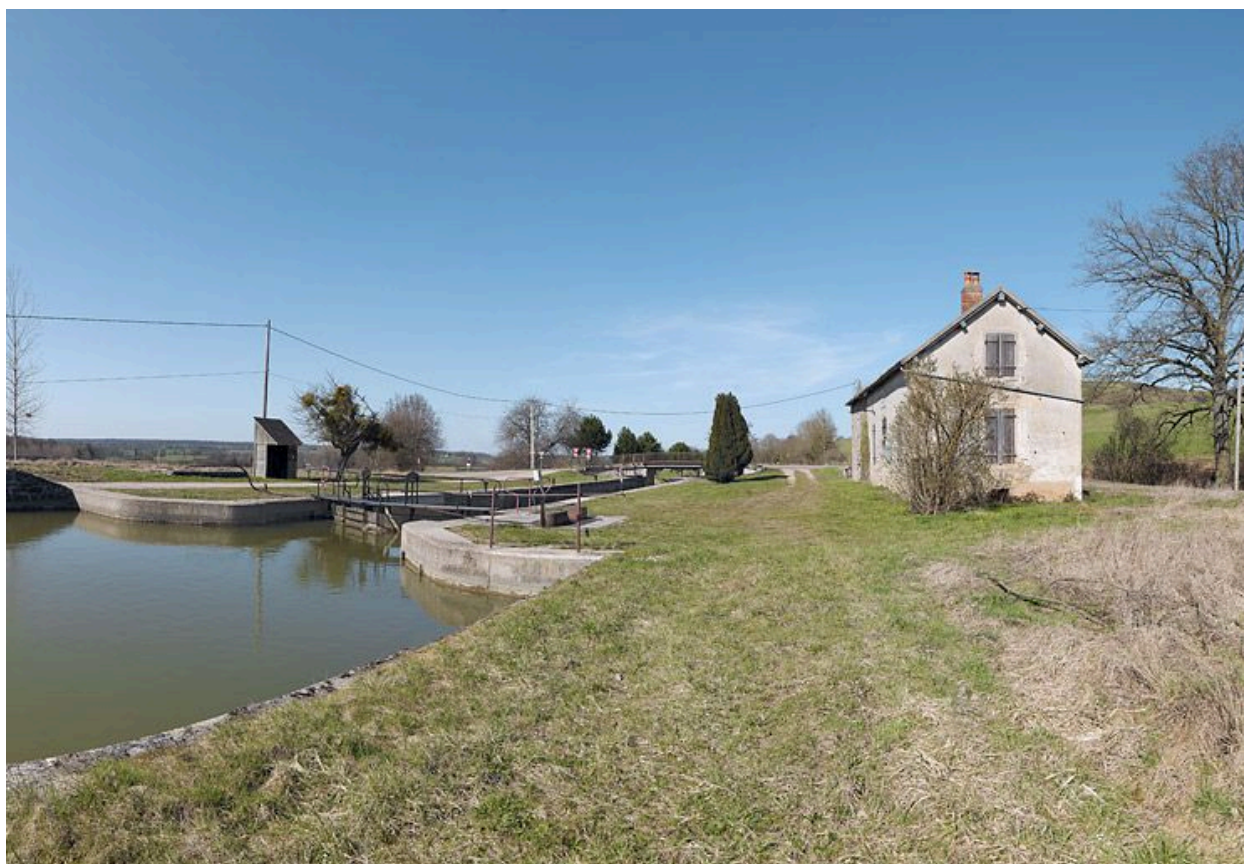
Le site d'écluse vu d'amont.
