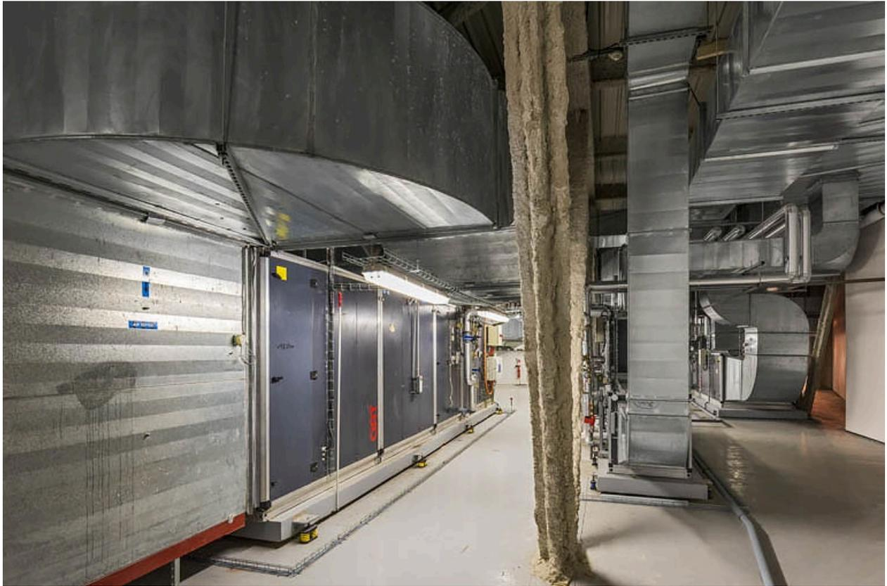
Ventilation dans le comble (les équipements sont fixés sur silentblocs).
