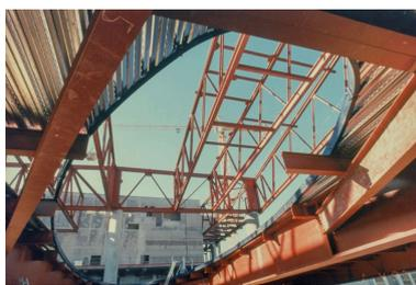
Construction : charpente métallique supportant le puits de lumière, vue du sol. 1er avril 1997.
