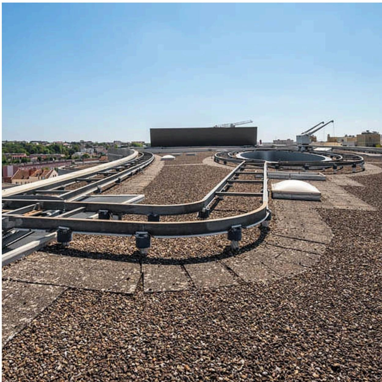
Toit terrasse au-dessus de la salle : rail du chariot permettant le déplacement de la nacelle utilisée pour le nettoyage des façades.
