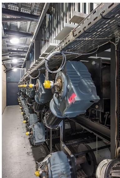
Equipes contrebalancées (fils, poulies, contrepoids, etc., permettant de manoeuvrer les perches) : moteurs électriques.
