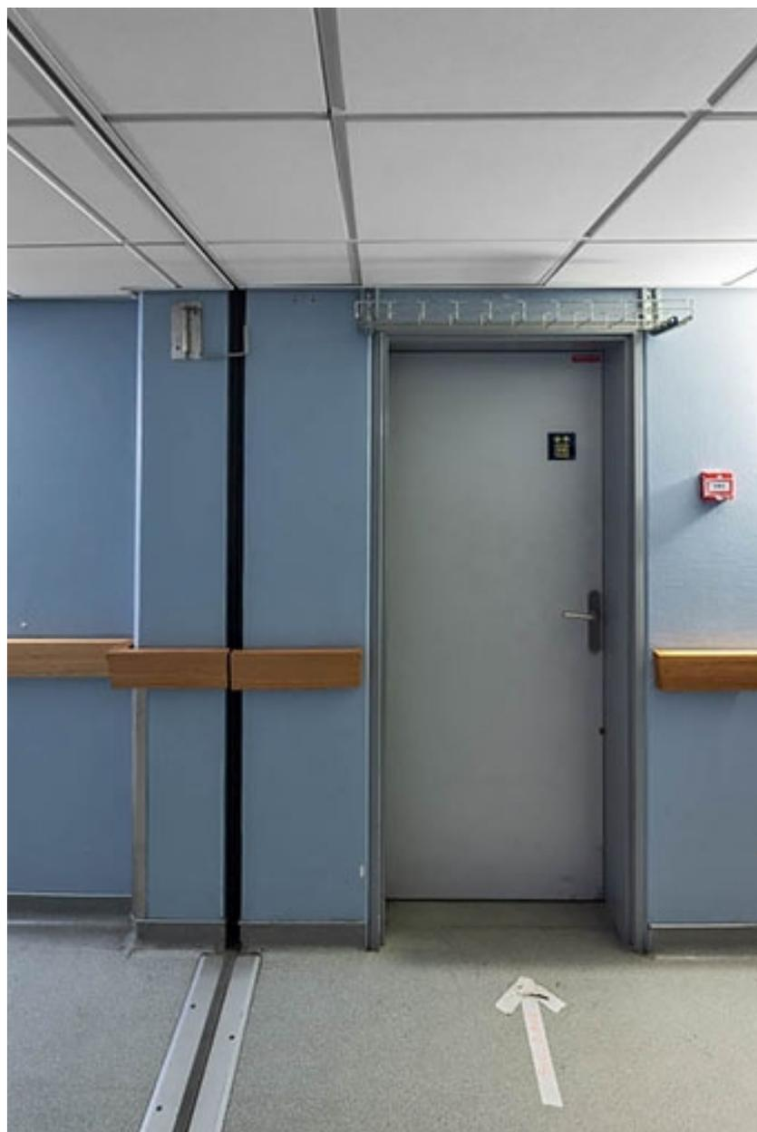
Maîtrise de l'acoustique : joint de séparation entre les bâtiments (au sol et se poursuivant sur le mur).
