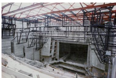
Construction : passerelles, structures métalliques des réflecteurs acoustiques et cadre de scène. 30 avril 1997.
