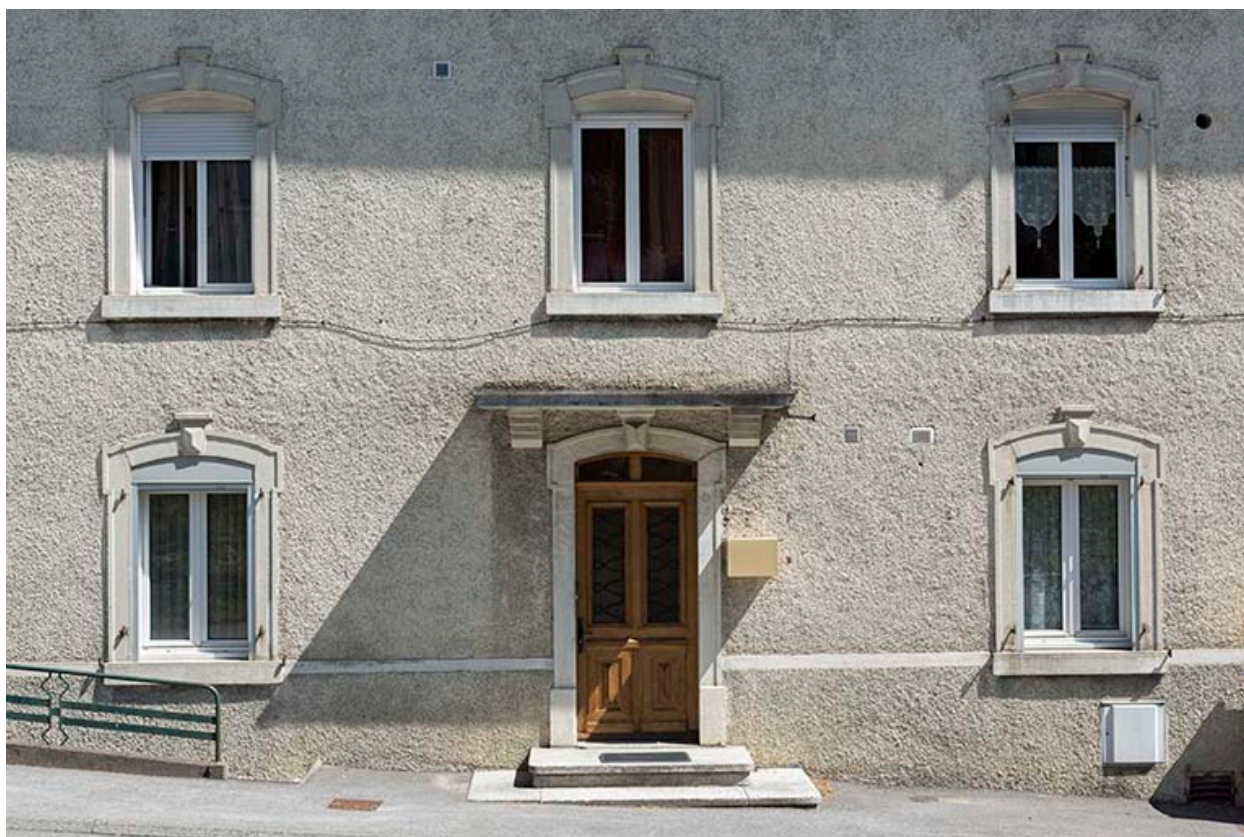
Façade antérieure : baies du bâtiment d'origine.
