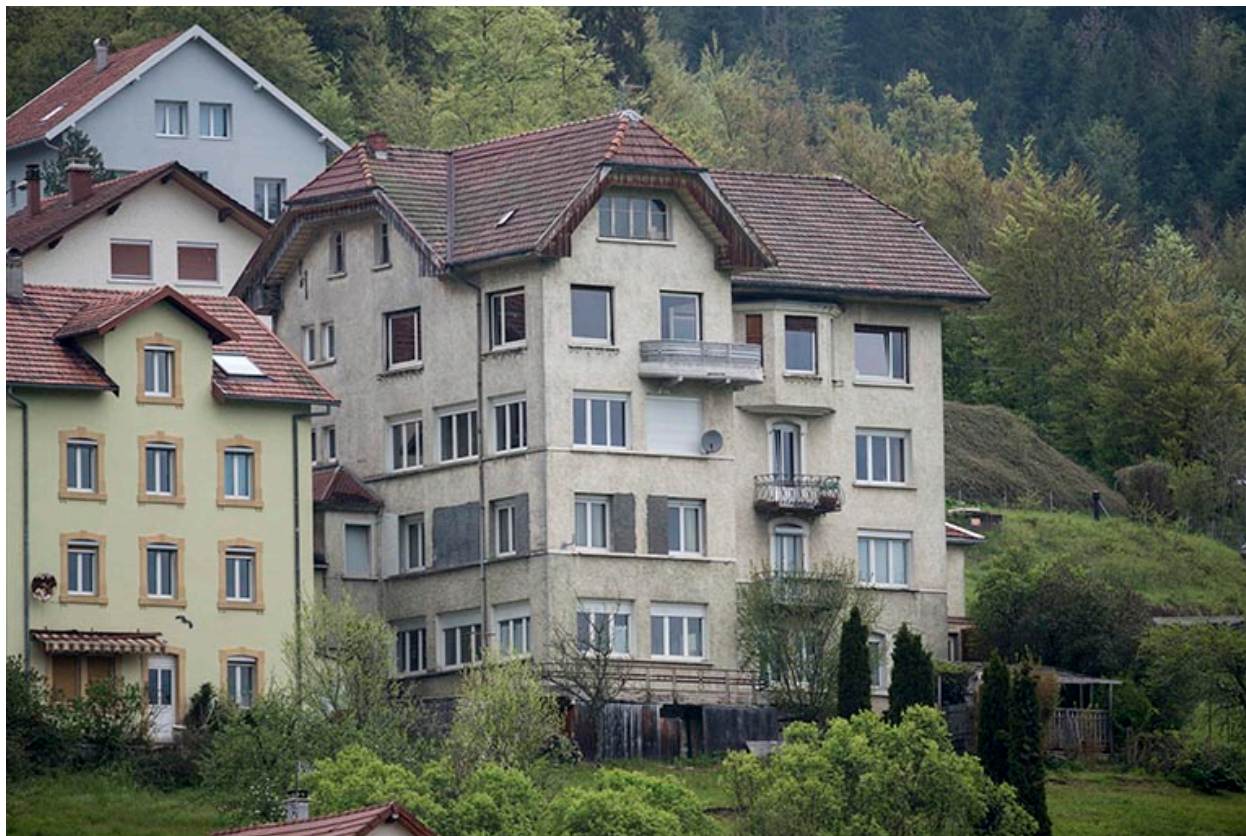
Façades postérieure et latérale droite.
