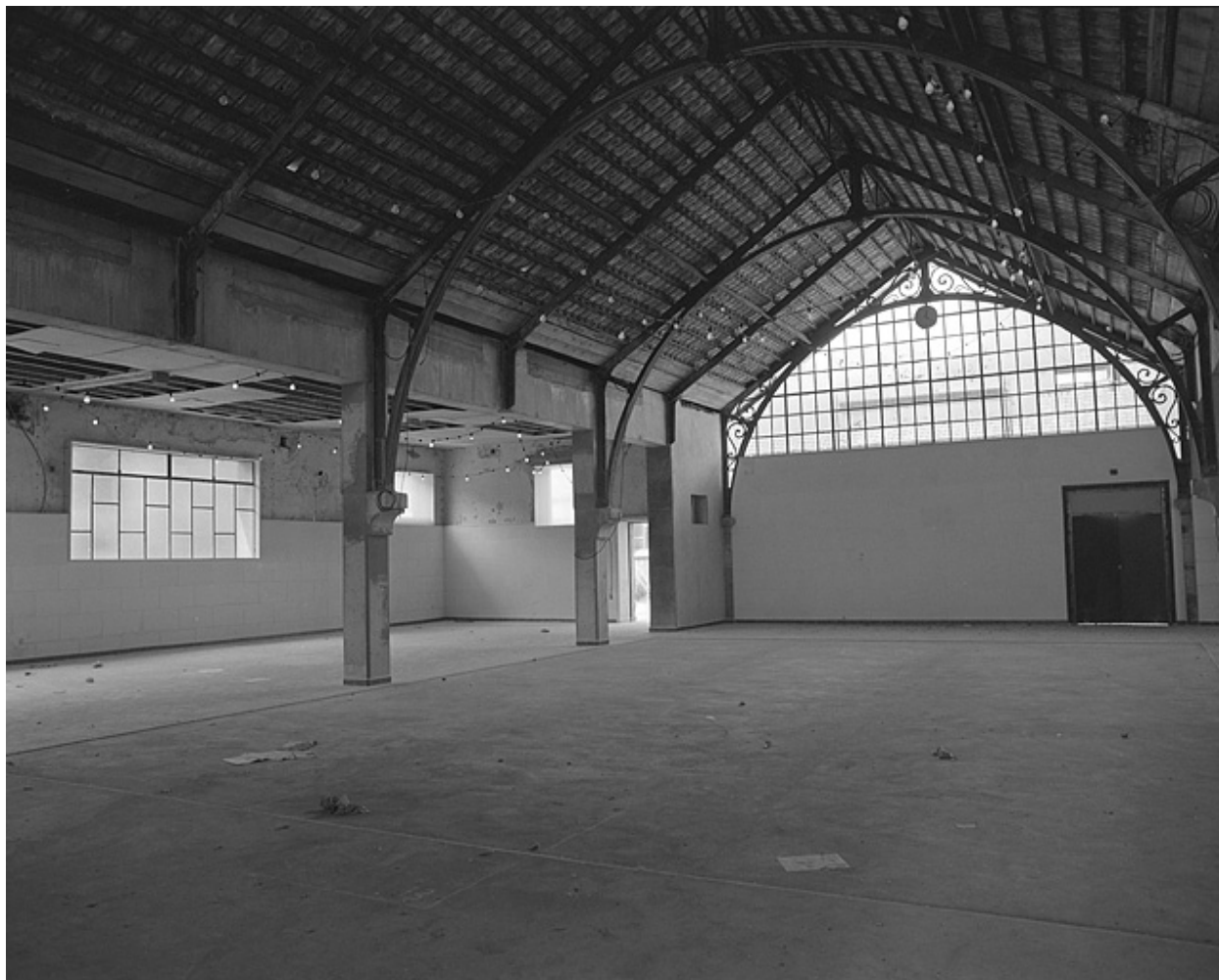
Vue intérieure de la halle.
