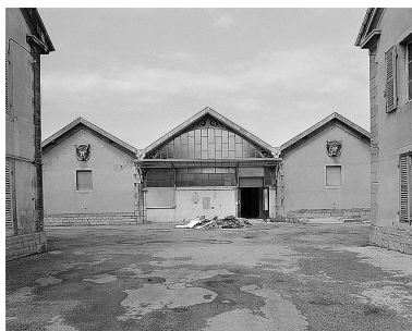
Façade antérieure de la halle. Phot. Yves Sancey IVR43_19833900124X
