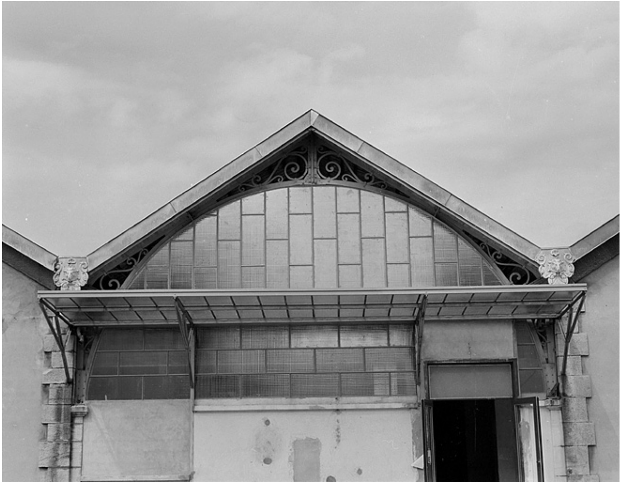
Détail de la couverture de la halle.
