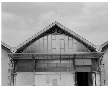
Détail de la couverture de la halle. Phot. Yves Sancey IVR43_19833900128X
