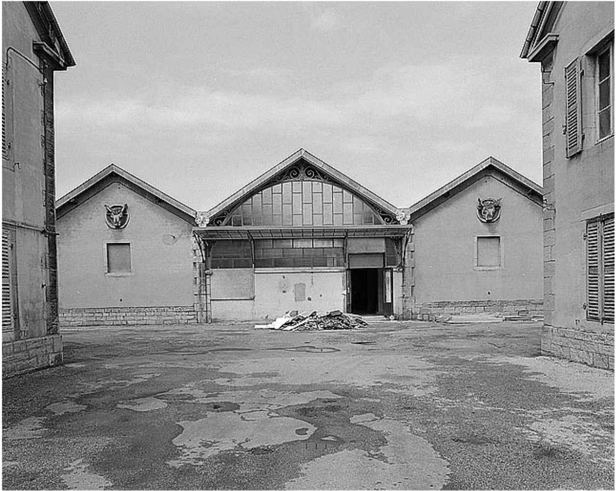
Façade antérieure de la halle.
