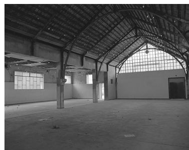
Vue intérieure de la halle. Phot. Yves Sancey IVR43_19833900126X
