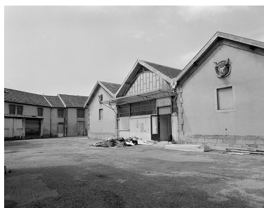
Vue de la cour devant la halle. Phot. Yves Sancey IVR43_19833900123X
