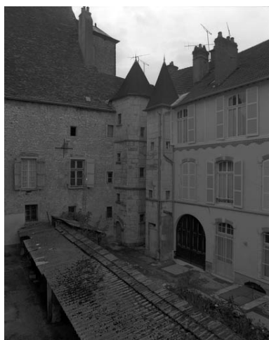
Façade latérale gauche : partie droite. Phot. Yves Sancey IVR43_19917000179X
