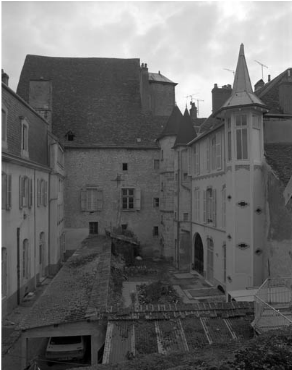
Façade latérale gauche : vue éloignée.
