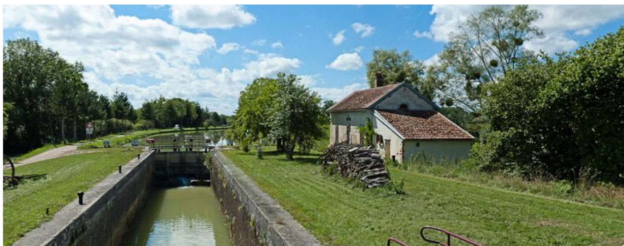
Vue d'ensemble du site d'écluse.
