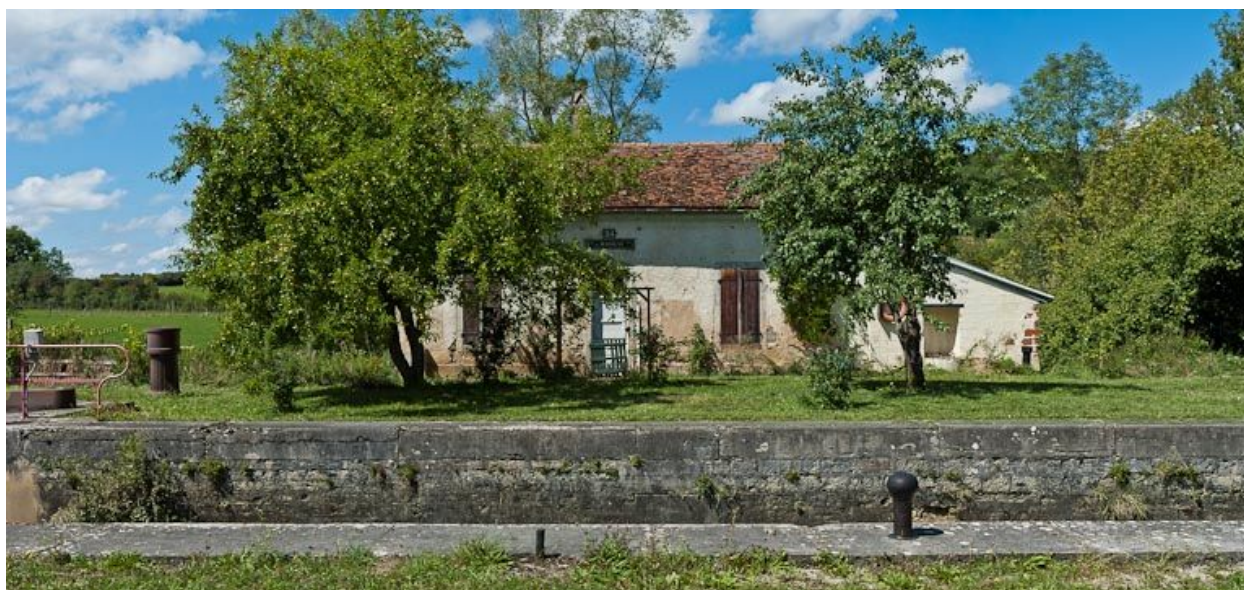
Vue de face de la maison éclusière.
