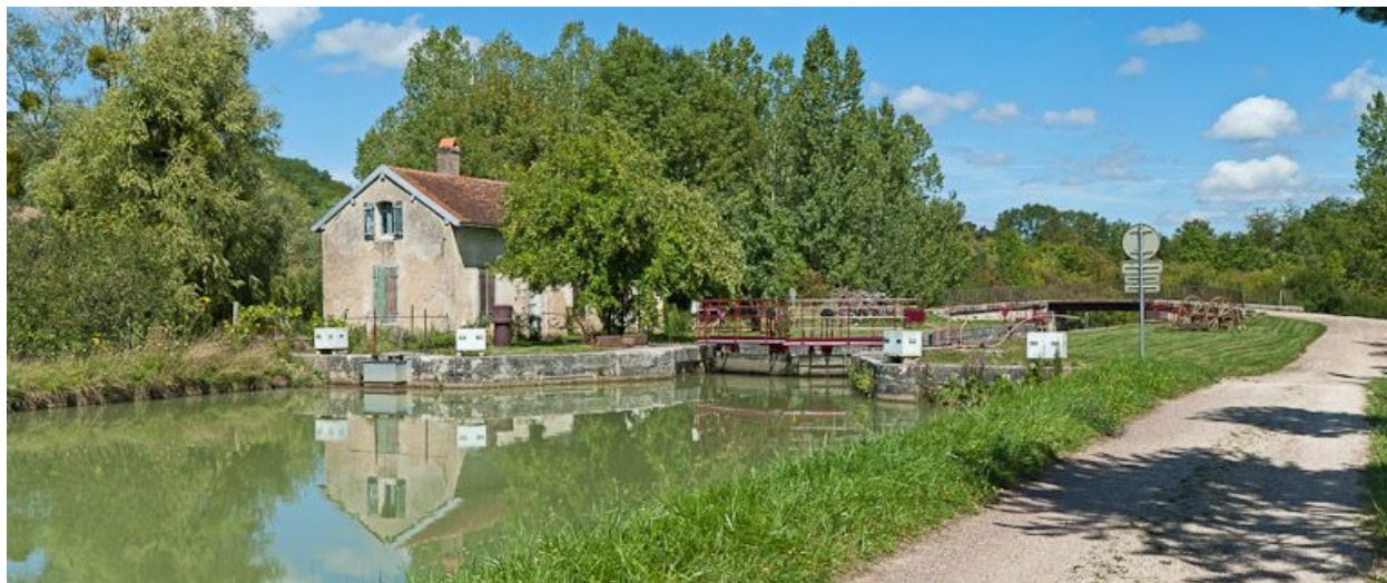
Vue d'ensemble du site d'écluse.
