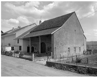
Façade antérieure et façade droite. Phot. Yves Sancey IVR43_19813900157X
