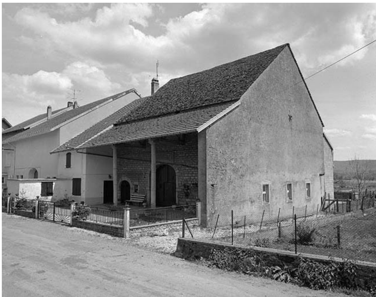
Façade antérieure et façade droite.
