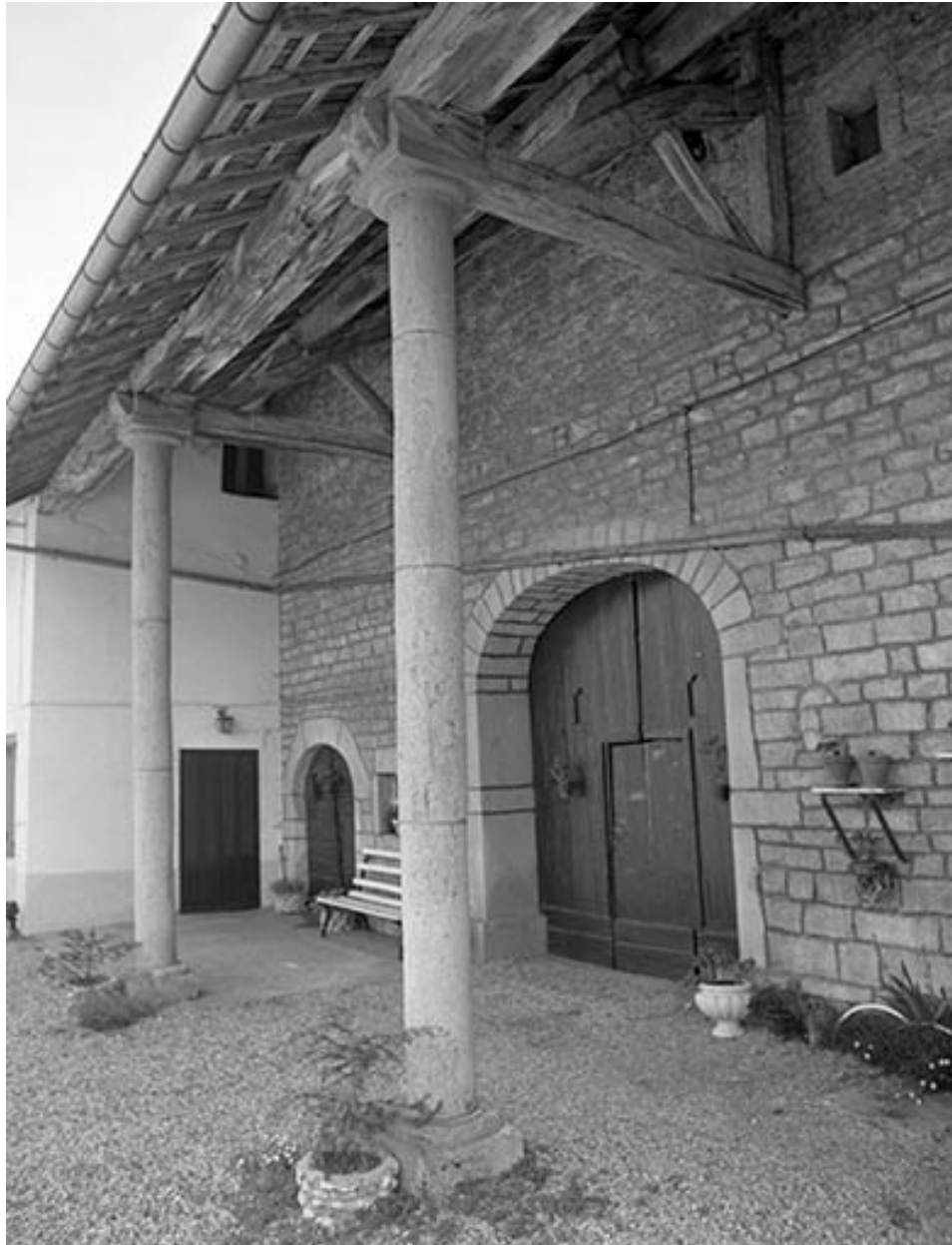
Façade antérieure : détail de l'avant-toit.
