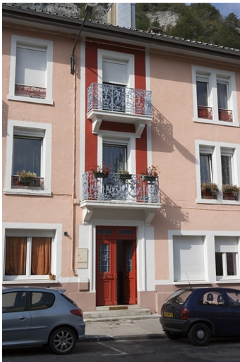
Façade antérieure : travée de la porte d'entrée.
