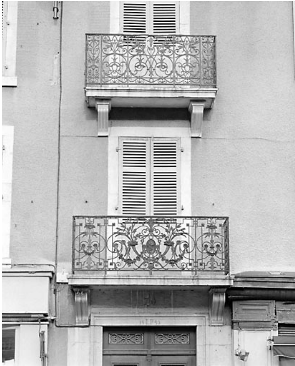
Balcons surmontant la porte d'entrée, avant restauration.
