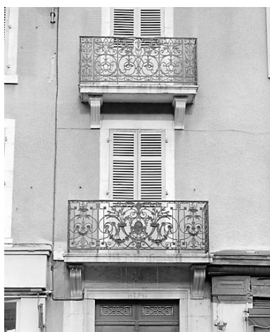
Balcons surmontant la porte d'entrée, avant restauration. Phot. Yves Sancey IVR43_20033900209X
