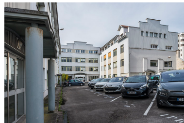
Bâtiment nord depuis la cour. Phot. Jérôme Mongreville IVR43_20172501110NUC4A
