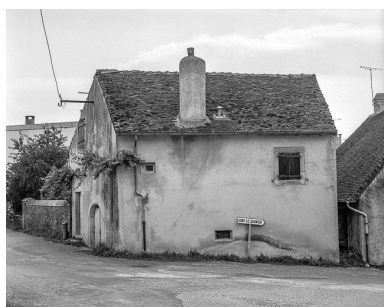
Façade latérale gauche. Phot. Yves Sancey IVR43_19843900069X
