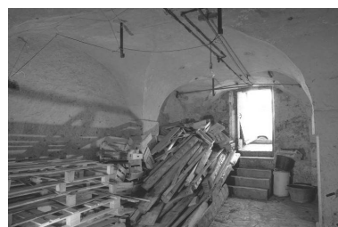
Pièce voûtée, en sous-sol. Phot. Laurent Poupard IVR43_19913901398Z
