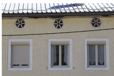
Baies aérant le comble de l'ancien moulin à tan. Phot. Yves Sancey IVR43_20103900658NUC2A
