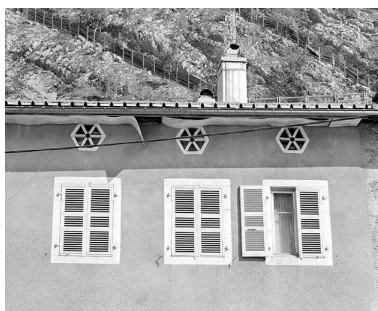
Fenêtres du dernier étage et baies aérant le comble de la maison au n° 18 (façade postérieure). Phot. Yves Sancey IVR43_20033900381X
