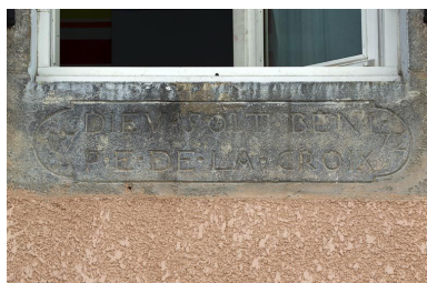
Linteau remployé comme appui de fenêtre. Phot. Yves Sancey IVR43_20103900511NUC2A
