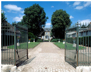
Bâtiment d'habitation depuis la grille d'entrée ouverte. Phot. Yves Sancey IVR43_19887000017XA
