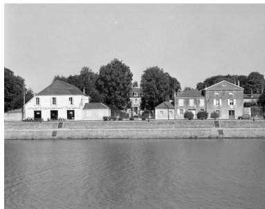
Vue d'ensemble depuis le quai Mavia. Phot. Yves Sancey IVR43_19887000016X
