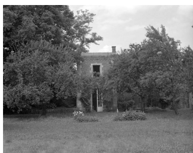
Vue de l'orangerie au fond du parc. Phot. Yves Sancey IVR43_19887000038X
