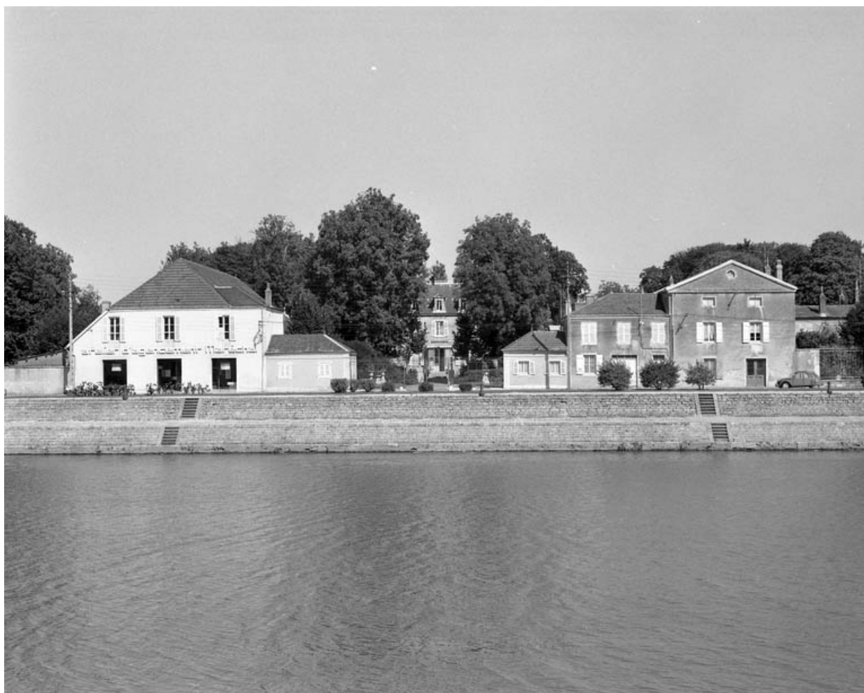
Vue d'ensemble depuis le quai Mavia.
