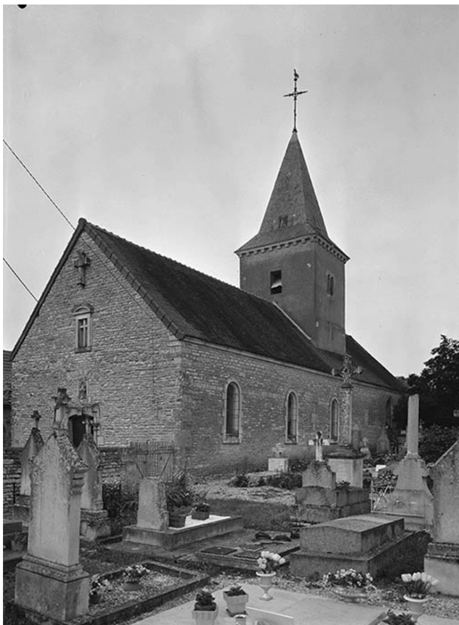
Façade occidentale et bas-côté sud.
