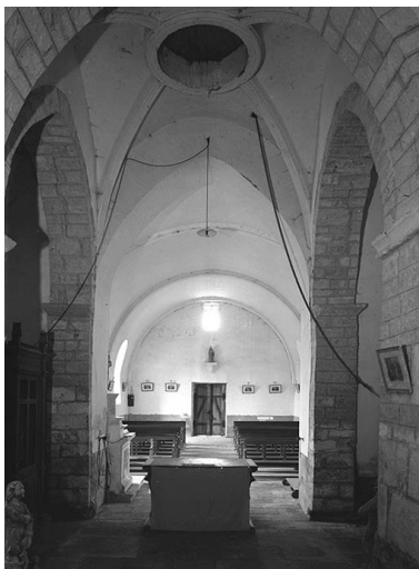
Vue intérieure prise depuis le chœur.
