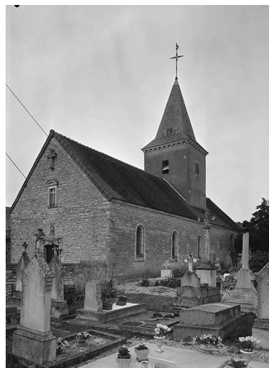
Façade occidentale et bas-côté sud. Phot. Jean-Luc Duthu IVR26_19748900377V
