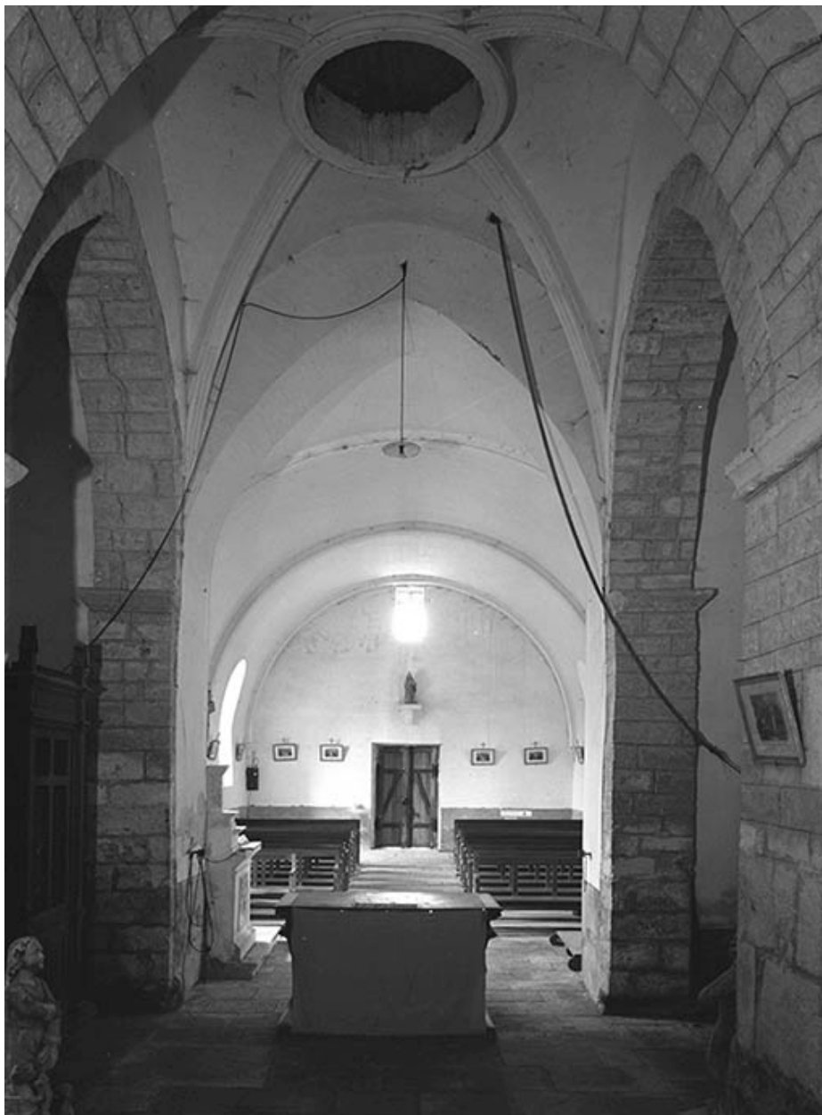
Vue intérieure prise depuis le chœur.
