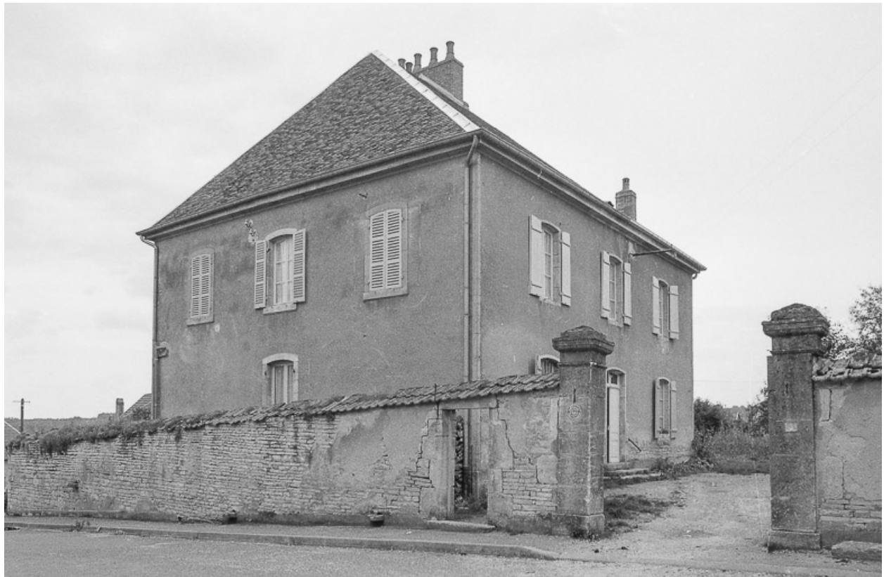
Façade sur cour.
