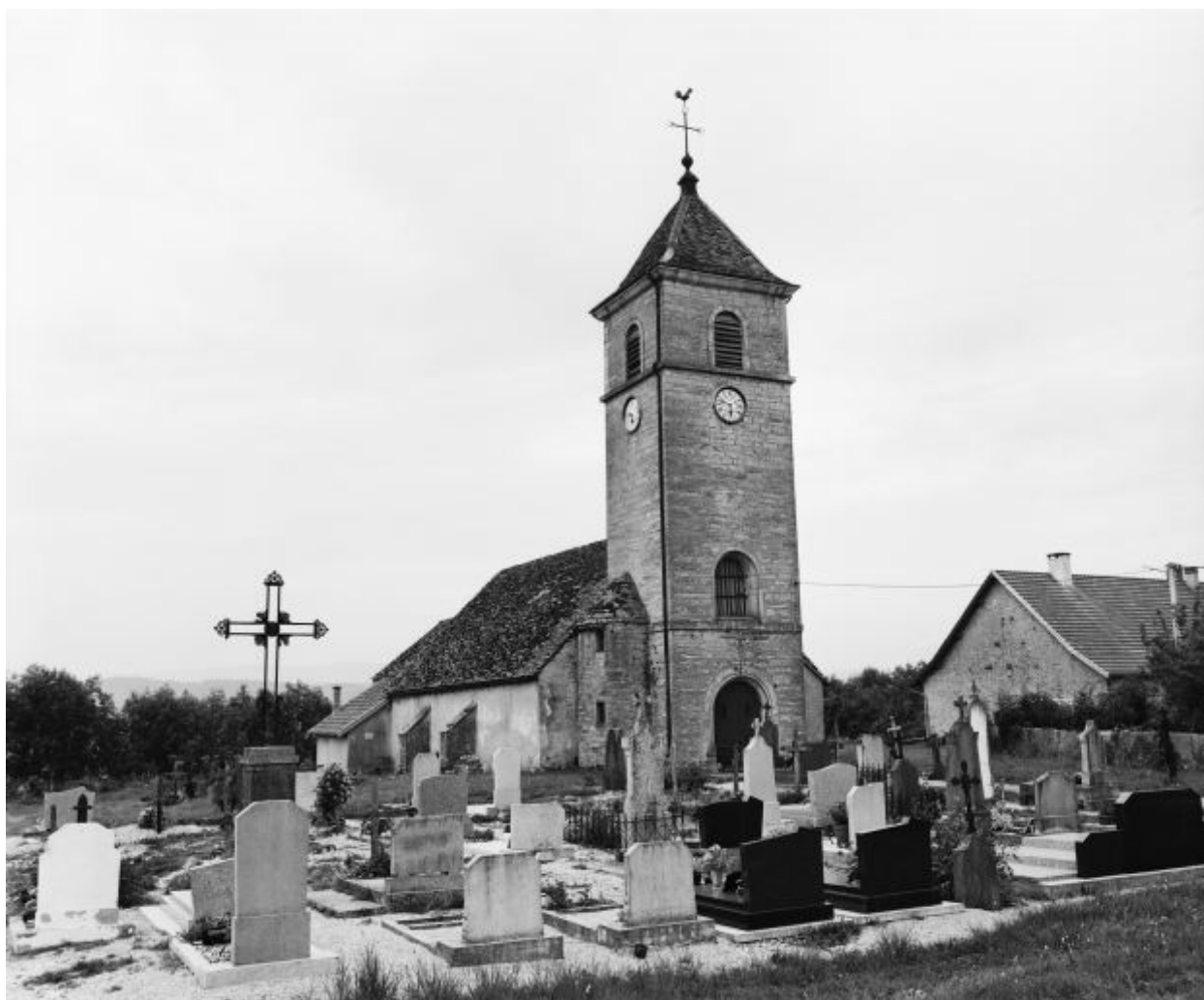
Façades antérieure et latérale gauche.
