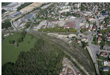
Vue aérienne du site de la gare, depuis le sud-est. Phot. Jean-Pierre Bévalot IVR43_20050100202NUCA
