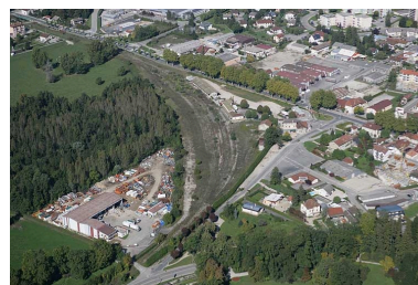
Vue aérienne du site de la gare, depuis le sud-est. Phot. Jean-Pierre Bévalot IVR43_20050100201NUCA
