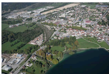
Vue aérienne rapprochée du quartier de la gare, depuis le sud-est. Phot. Jean-Pierre Bévalot IVR43_20050100200NUCA
