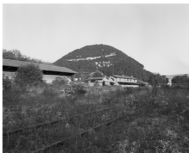
Vue d'ensemble de l'entrepôt et du site, depuis l'ouest. Phot. Yves Sancey IVR43_20050100124X
