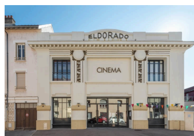
Cinéma Eldorado, à Dijon. Phot. Pierre-Marie Barbe-Richaud IVR26_20212100110NUC4A
