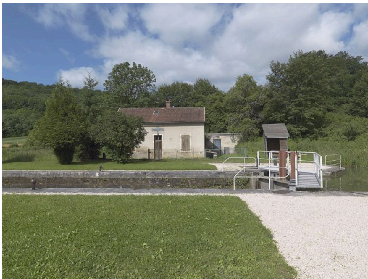
Maison éclusière de face.
