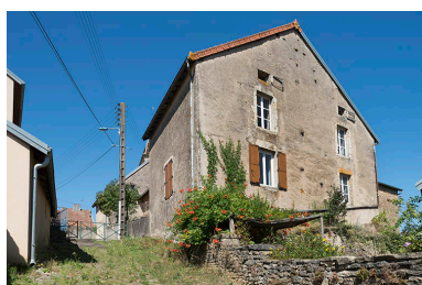
Le mur pignon côté sud. Phot. Jérôme Mongreville IVR43_20177001218NUC4A
