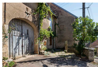
La porte cochère et l'accès vers une des maisons. Phot. Jérôme Mongreville IVR43_20177001220NUC4A
