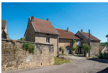
Vue depuis la rue avec le retour du mur de l'ancien cimetière. Phot. Jérôme Mongreville IVR43_20177001217NUC4A
