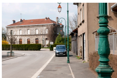
Vue générale de l'avenue et du bâtiment des voyageurs. Phot. Jérôme Mongreville IVR43_20102500618NUC4A
