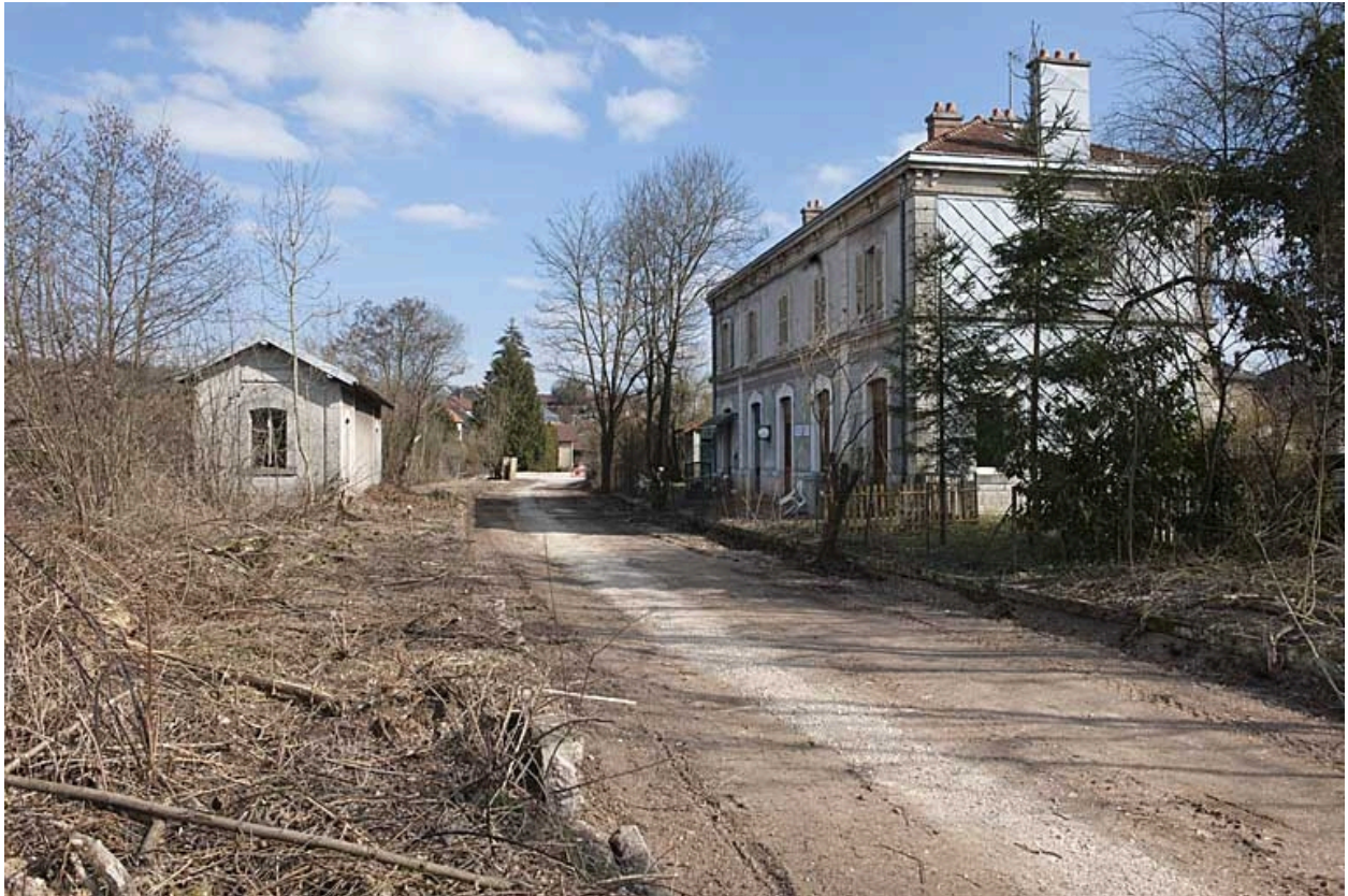
Bâtiment des voyageurs et abri.
