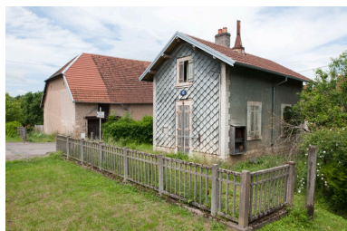
Maison de garde-barrière (cadastrée AK 125), rue du Pont. Phot. Jérôme Mongreville IVR43_20102500645NUC4A
