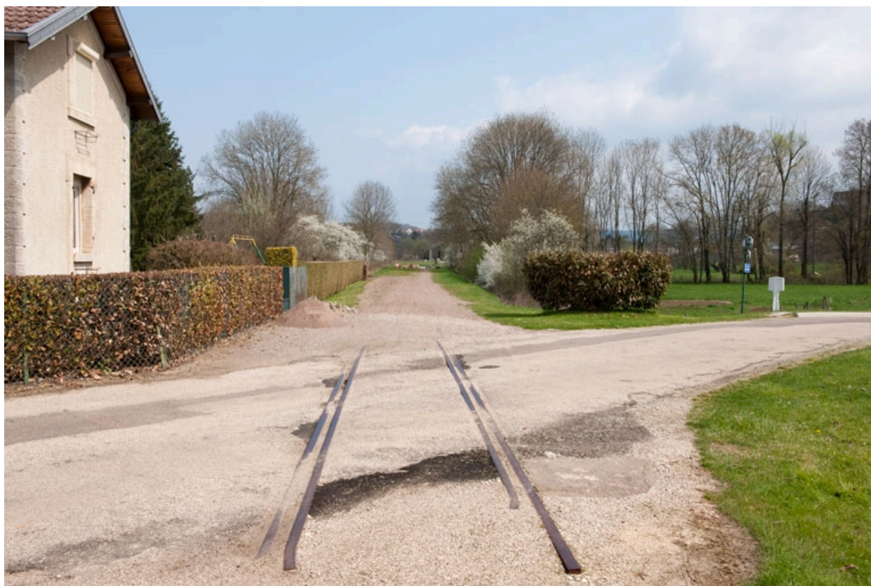
Tracé de la voie au niveau de la maison de garde-barrière, chemin du Souvenir français. Noter les rails encore en place.
