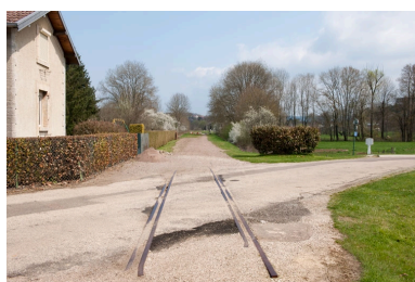
Tracé de la voie au niveau de la maison de garde-barrière, chemin du Souvenir français. Noter les rails encore en place. Phot. Jérôme Mongreville IVR43_20102500615NUC4A
