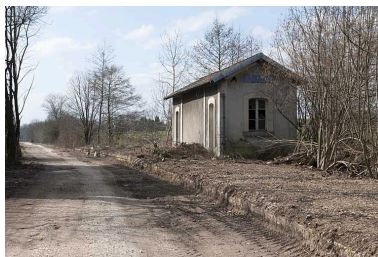
Abri de voyageurs. Phot. Jérôme Mongreville IVR43_20112500343NUC4A
