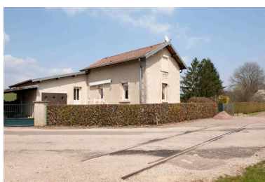
Maison de garde-barrière, chemin du Souvenir français : vue rapprochée. Noter les rails encore en place. Phot. Jérôme Mongreville IVR43_20102500616NUC4A
