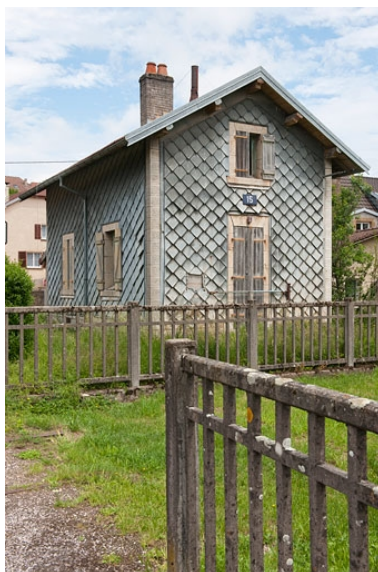
Maison de garde-barrière, rue du Pont : vue rapprochée. Phot. Jérôme Mongreville IVR43_20102500644NUC4A
