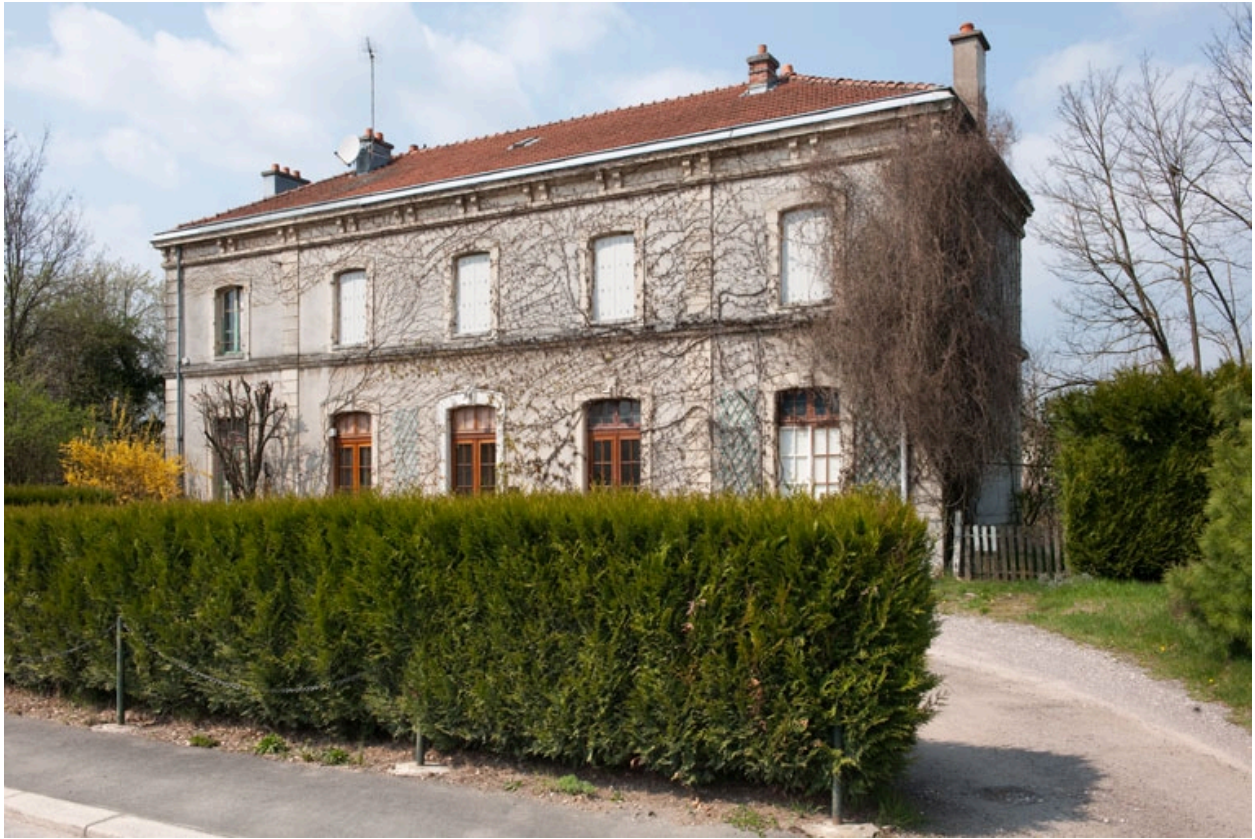
Bâtiment des voyageurs.
