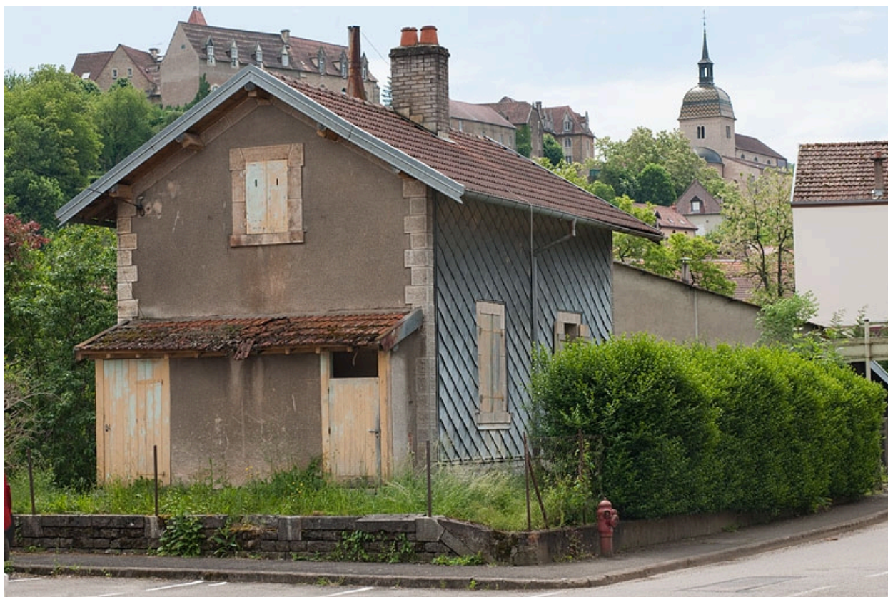
Maison de garde-barrière, rue du Pont : vue rapprochée, depuis le carrefour.
